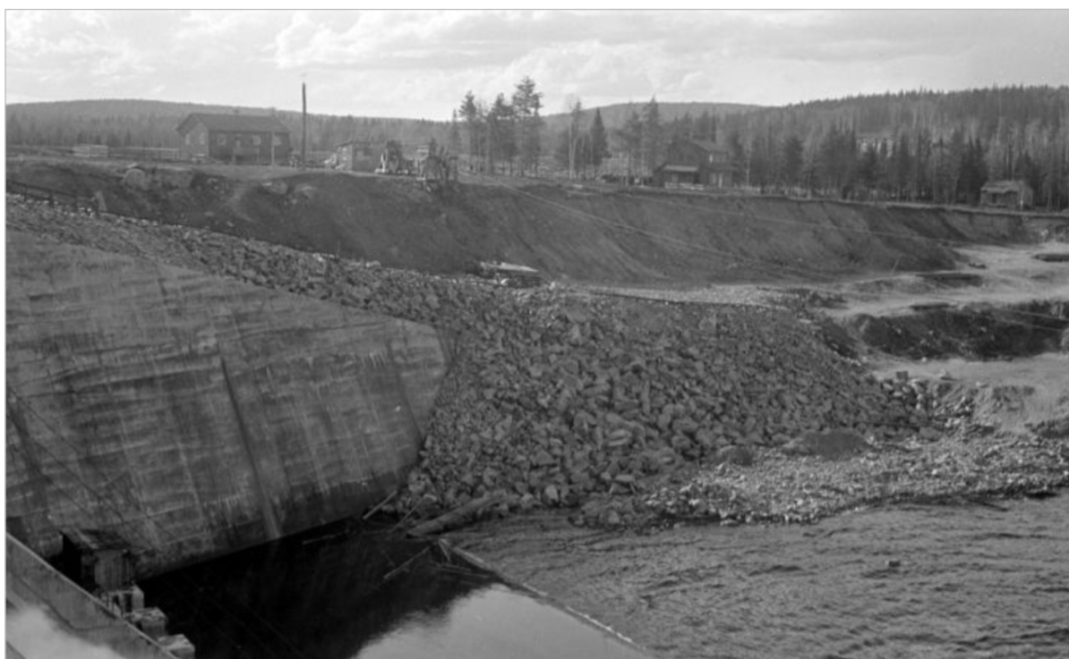
Photo 4. Empierrement en rive gauche du barrage Matawin (1932)
