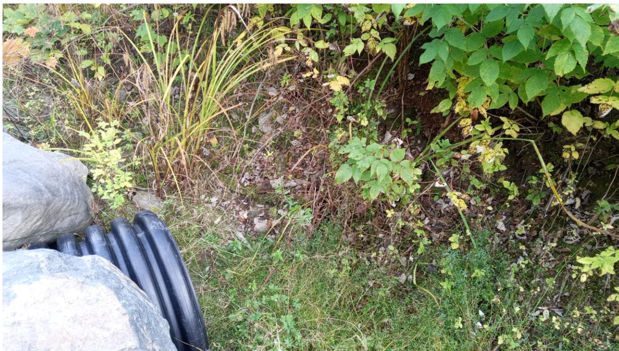
Photo 5. Ponceau de drainage de 450 mm, pas considéré cours d'eau par foresterie, pas de zone tampon de 20 m
