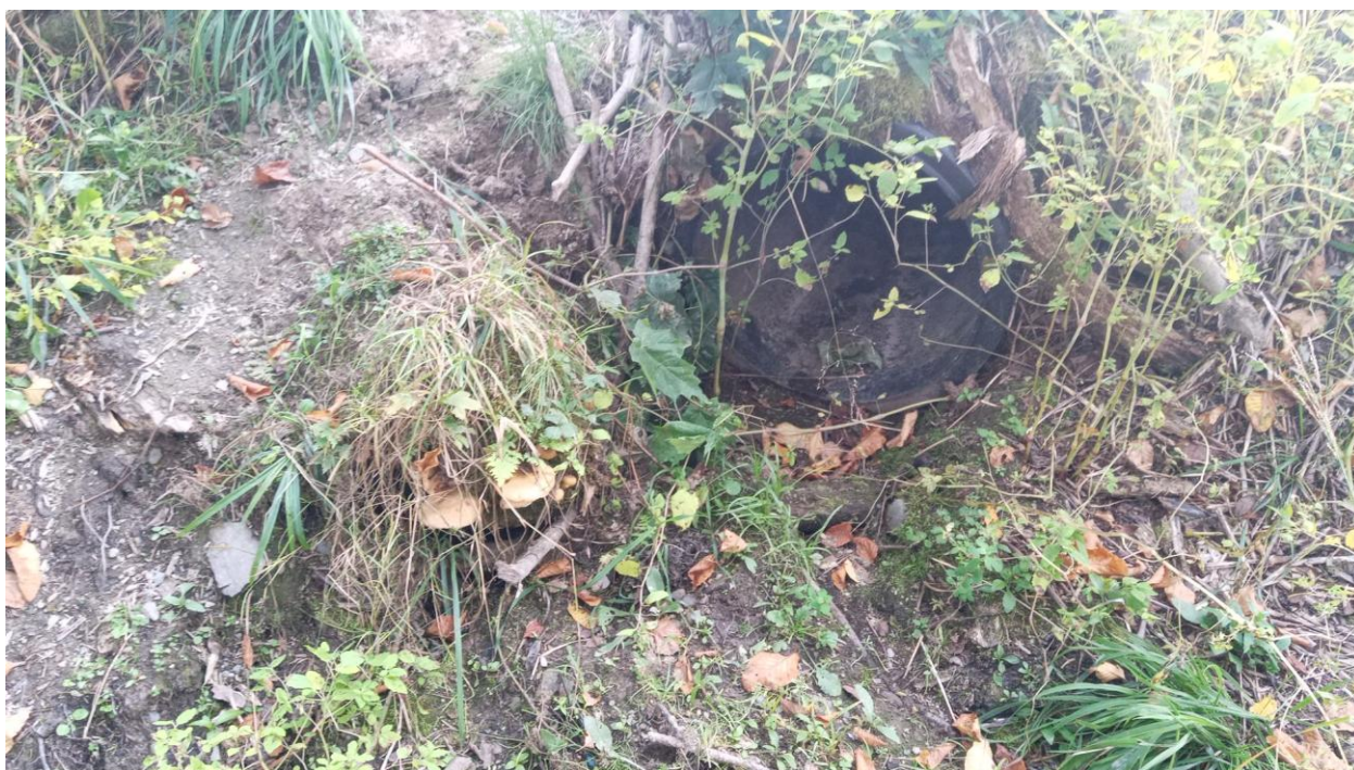
Photo 9. Aval, ponceau 450 mm bouché de l'autre côté par le barrage de castor.
