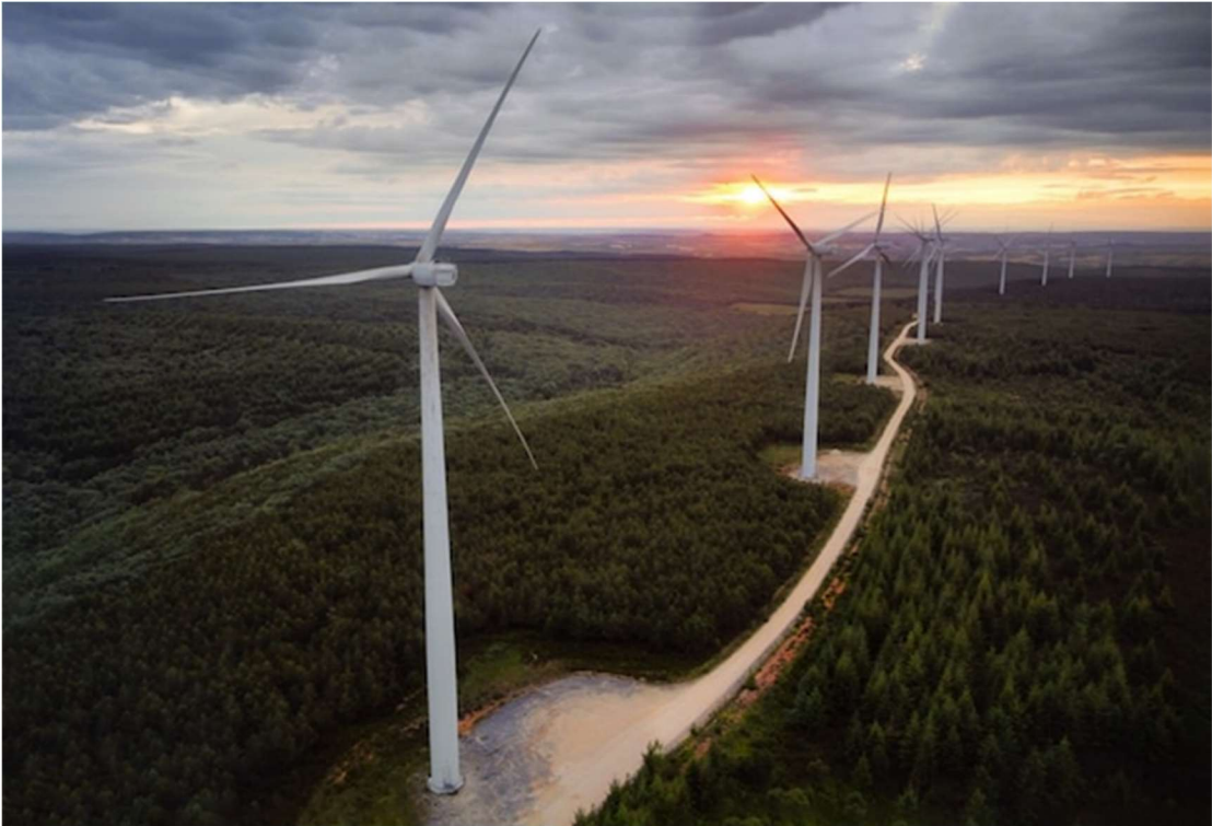
Figure 20. Parc éolien construit avec les aires d'assemblage adjacent au chemin, ce qui permet de réduire les superficies déboisées et la fragmentation du territoire.
