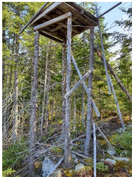
Figure 4. Mirador dans la zone AU-1C, vue vers le nord (photographie AU24-016_PNWW-042).
