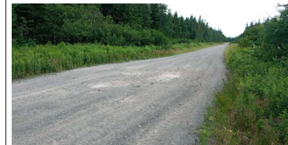
Chaussée de l'infrastructure existante
