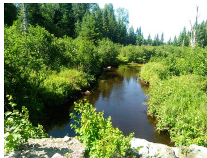
Vue amont de l'infrastructure existante
