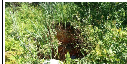
Vue aval de l'infrastructure existante
