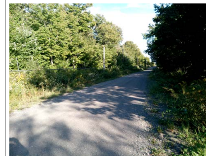
Chaussée de l'infrastructure existante
