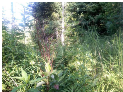
Talus, rive droite
