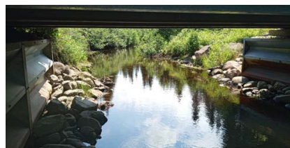
Vue amont de l'infrastructure existante
