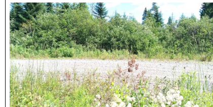
Chaussée de l'infrastructure existante
