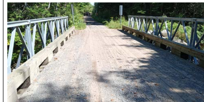
Chaussée de l'infrastructure existante
