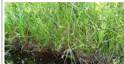
Talus, rive droite
