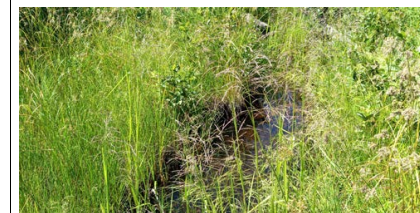
Vue aval de l'infrastructure existante
