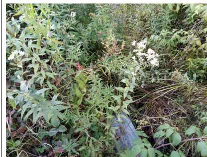
Vue amont de l'infrastructure existante
