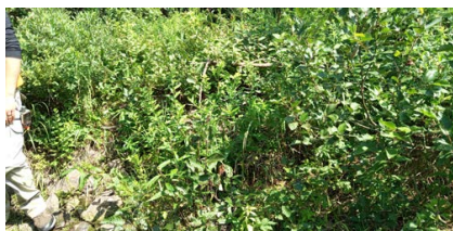
Talus, rive droite
