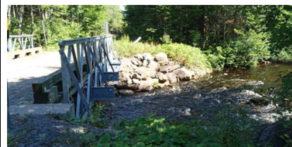
Vue amont de l'infrastructure existante
