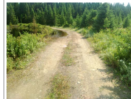
Chaussée de l'infrastructure existante
