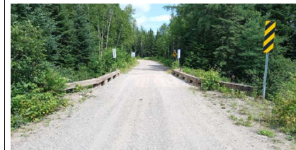
Chaussée de l'infrastructure existante
