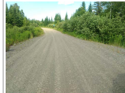
Chaussée de l'infrastructure existante
