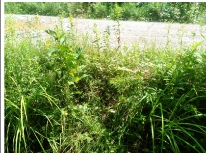
Talus, rive droite
