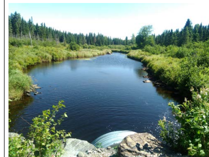
Vue aval de l'infrastructure existante
