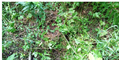
Talus, rive droite
