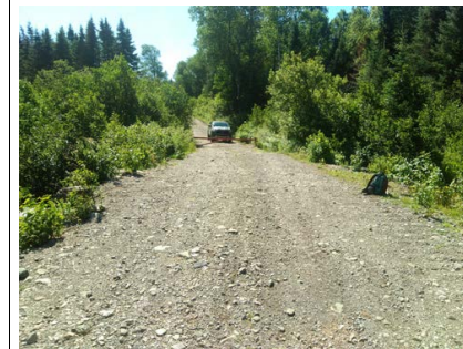
Chaussée de l'infrastructure existante
