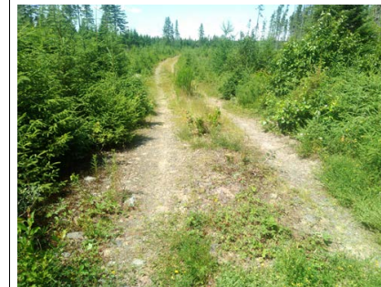
Chaussée de l'infrastructure existante
