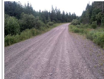
Chaussée de l'infrastructure existante
