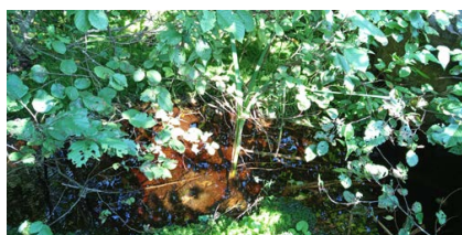
Vue amont de l'infrastructure existante
