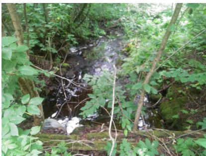
Vue aval de l'infrastructure existante
