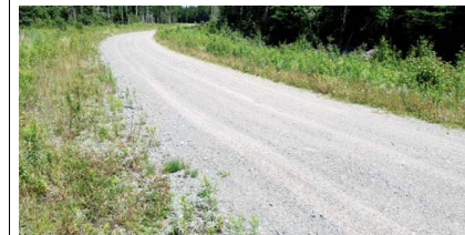
Chaussée de l'infrastructure existante
