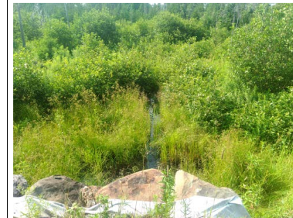
Vue aval de l'infrastructure existante
