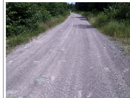
Chaussée de l'infrastructure existante
