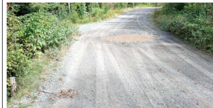
Chaussée de l'infrastructure existante
