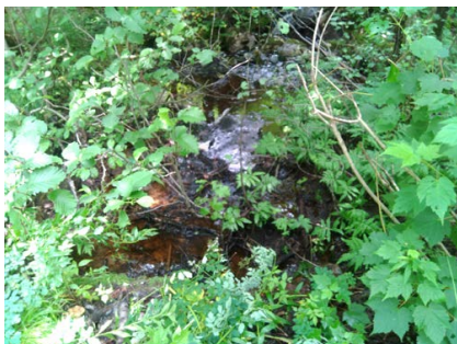
Vue amont de l'infrastructure existante
