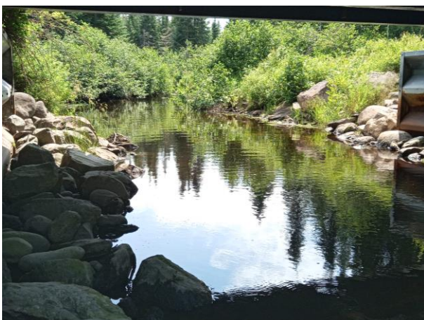
Photo 25. Pont à la station SHPV051
