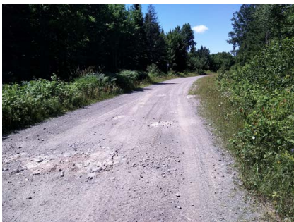
Chaussée de l'infrastructure existante
