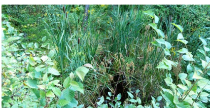
Vue aval de l'infrastructure existante
