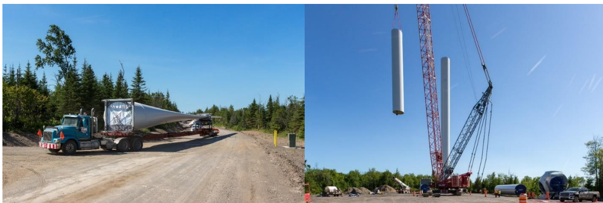
Figure 2. Transport par camion d'une pale et assemblage d'une tour d'éolienne
