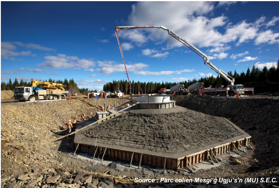
Figure 11. Construction d'une fondation d'éolienne
