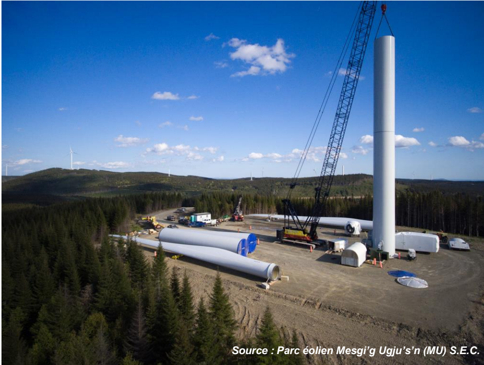
Figure 12. Assemblage d'une tour d'éolienne par section
