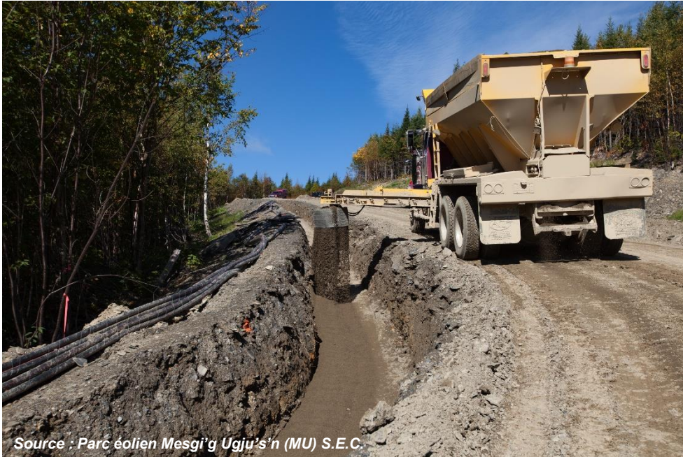
Figure 14. Installation d'un réseau collecteur souterrain
