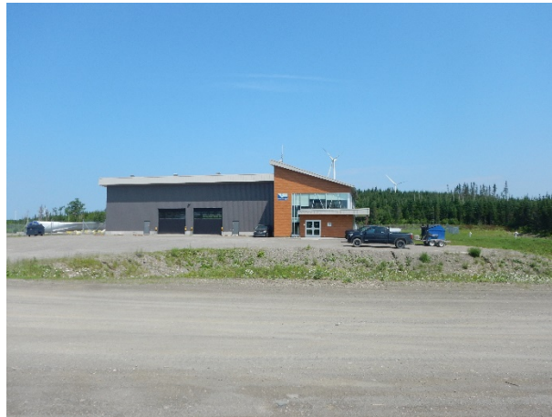
Photo 35. Bâtiment des opérations (prise en 2023)
