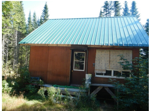
Photo 31. Bâtiment, identifiant 140290 (prise en 2012) et aucun bâtiment pour l'identifiant 140291
