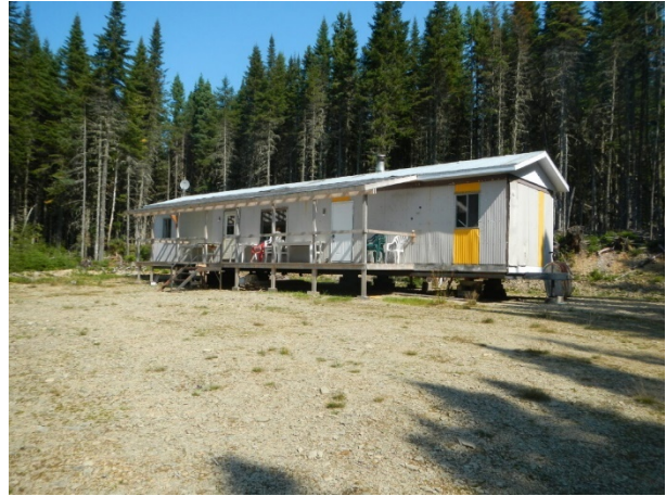
Photo 17. Bâtiment, identifiant 140276 (prise en 2012)
