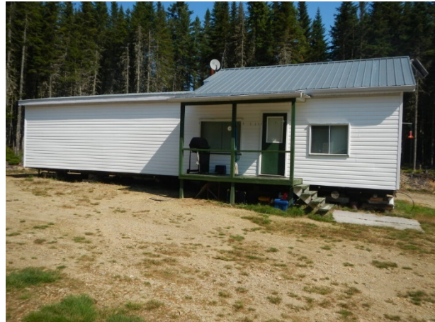
Photo 19. Bâtiment, identifiant 140277 (prise en 2012)
