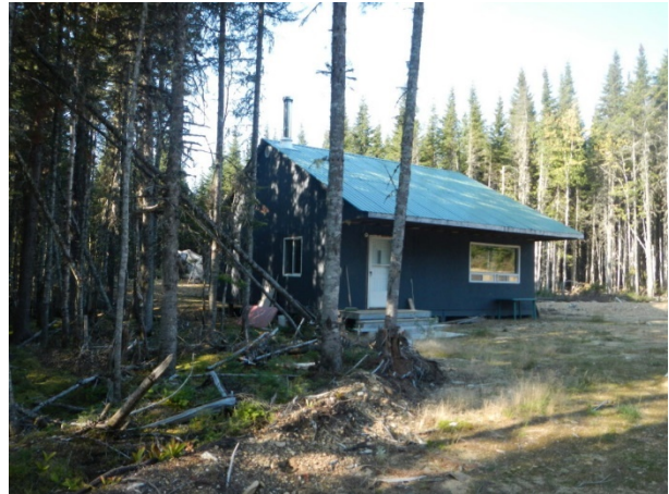
Photo 13. Bâtiment, identifiant 140273 (prise en 2012)
