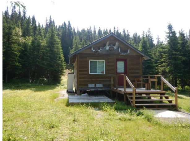
Photo 5. Bâtiment, identifiant 132028 (prise en 2023)
