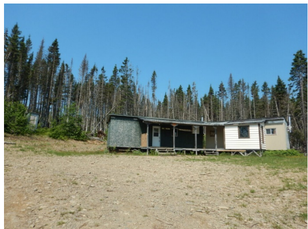
Photo 15. Bâtiment, identifiant 140275 (prise en 2023) et aucun bâtiment pour l'identifiant 140274
