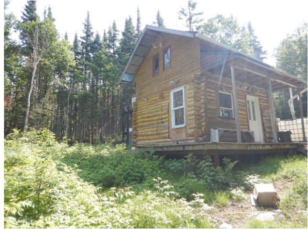
Photo 29. Bâtiment, identifiant 140289 (prise en 2023)
