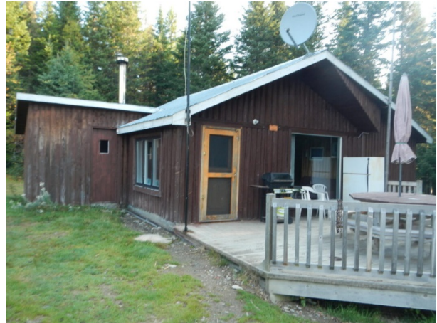
Photo 3. Bâtiment, identifiant 130777 (prise en 2012)
