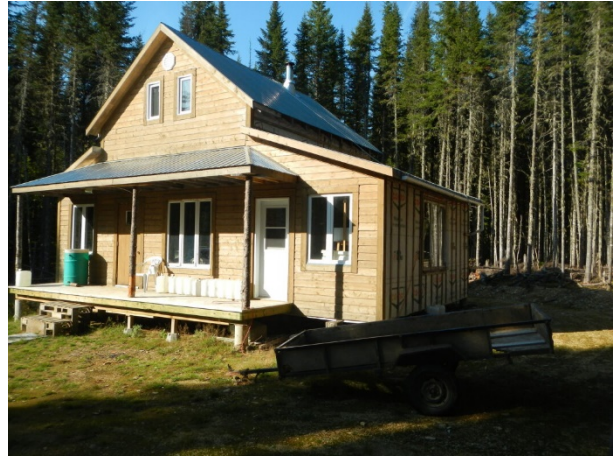
Photo 11. Bâtiment, identifiant 140272 (prise en 2012)
