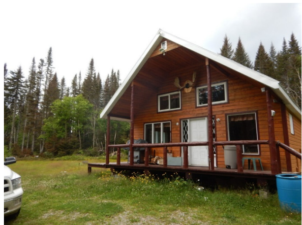
Photo 21. Bâtiment, identifiant 140278 (prise en 2017)
