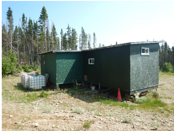
Photo 11. Chalet (id 57434) au nord-ouest du site à l'étude, vue arrière
