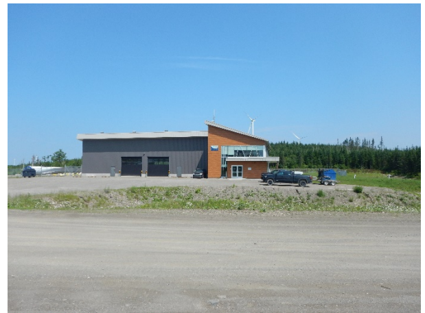
Photo 12. Bâtiment d'opération du parc éolien existant
