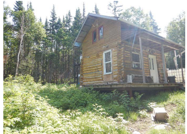
Photo 6. Chalet (id 57451) au nord du site à l'étude, vue vers le nord-est
