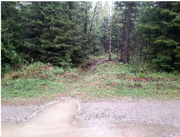
Photo 17 : Fossé de drainage creusé, côté nord du chemin à la station ST09
