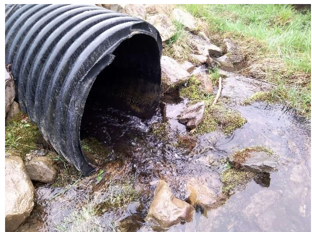
Photo 8. Ponceau simple dans le cours d'eau, vue vers l'aval
