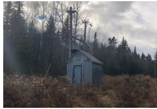
Figure 3. Station de pompage acéricole présente à proximité de l'emprise du projet
