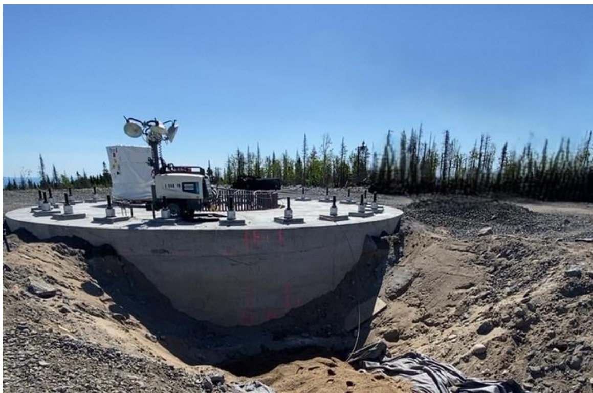
Figure 6.5 Fondation de béton
