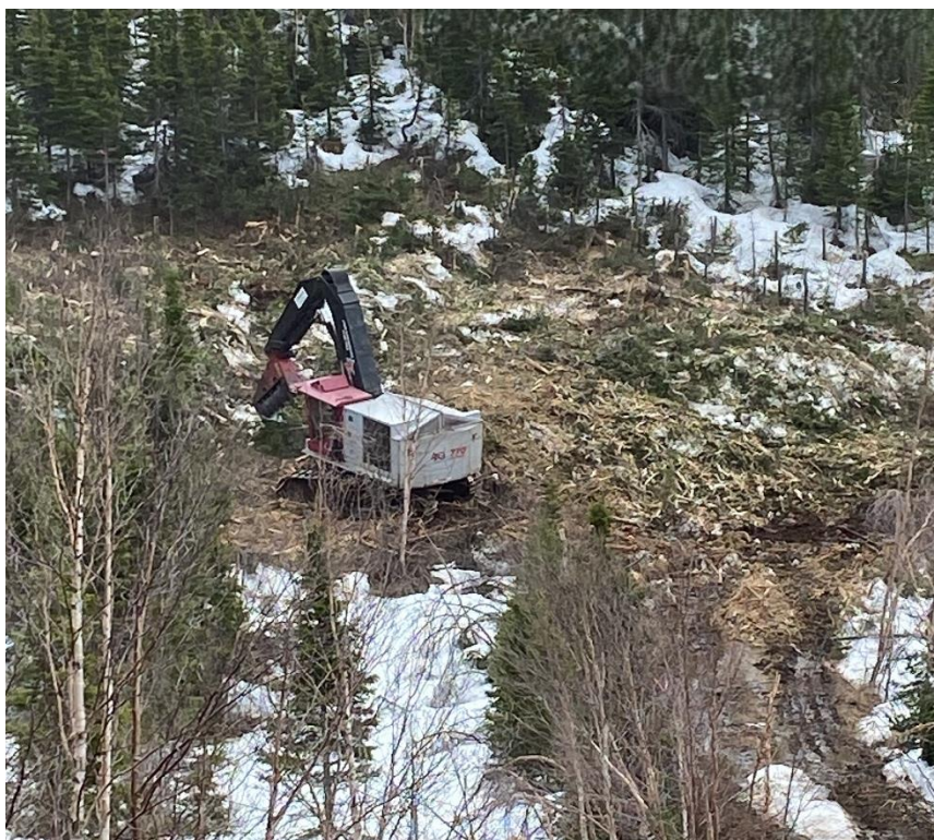
Figure 6.1 Travaux de déboisement – broyeur en activité
