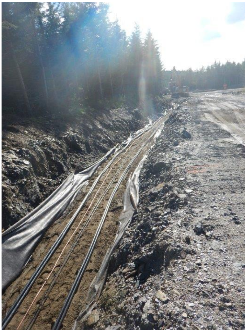
Figure 6.7 Installation d'un réseau collecteur
