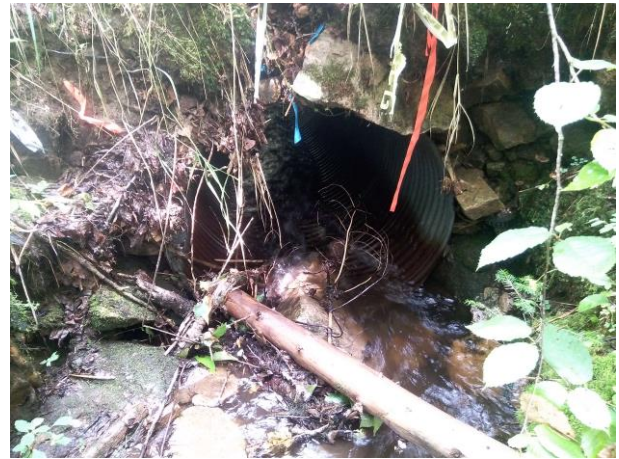
Photo 20. CE003, ponceau simple en acier (SH102)
