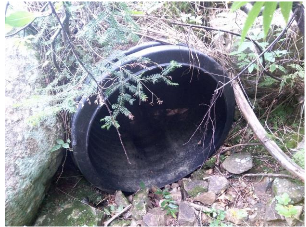
Photo 14. CE097, ponceau simple en plastique (SH286)
