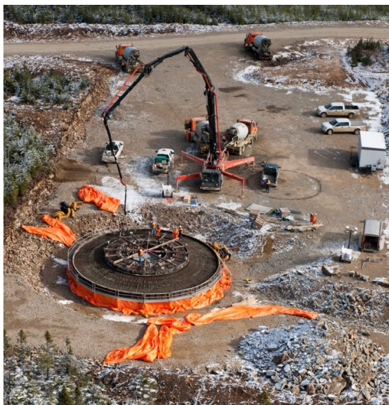
Figure 3.3 Construction d'une fondation circulaire
