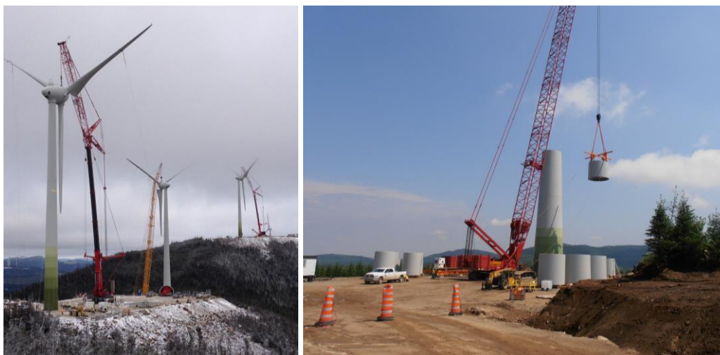
Figure 3.4 Assemblage d'une tour d'éolienne par section
