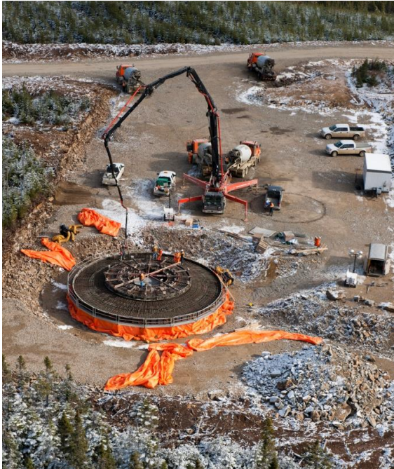
Figure 3.3 Construction d'une fondation circulaire
