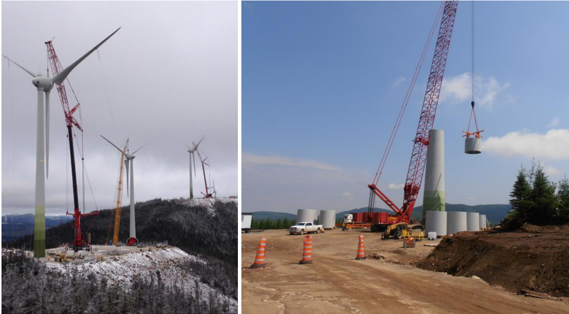
Figure 3.4 Assemblage d'une tour d'éolienne par section
