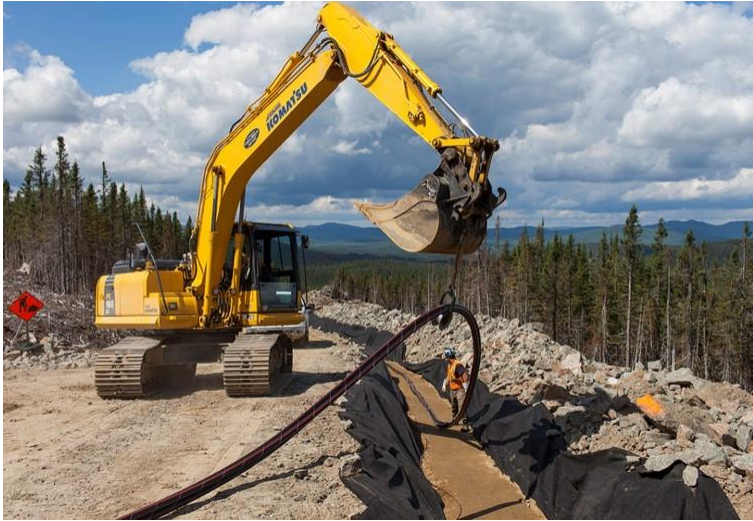
Figure 3.5 Installation d'un réseau collecteur souterrain
