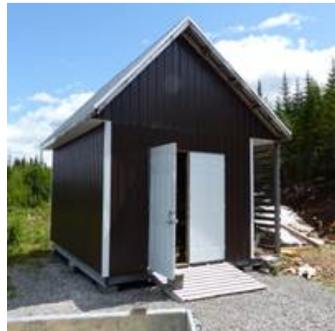
Photo 10. Remise sur le même terrain que le chalet situé sur le site à l'étude (lac du Chicot)
