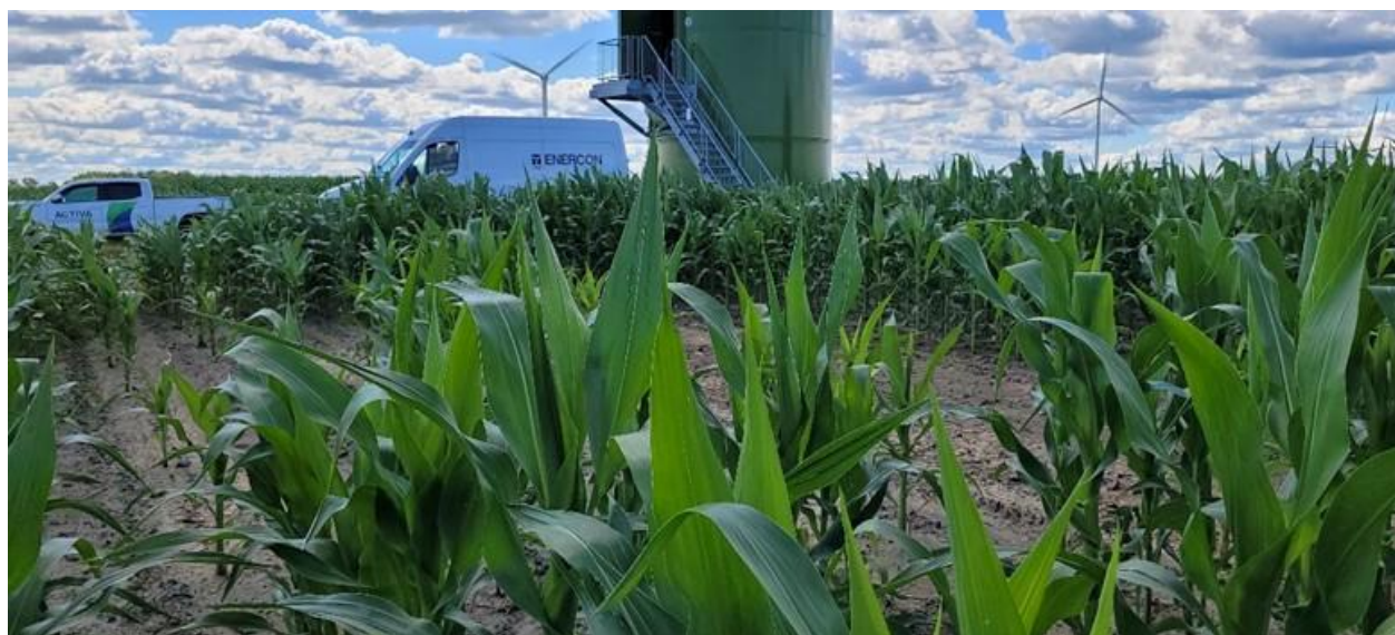
Figure 6. Éolienne T1 – Cuvette au sud-ouest de l’éolienne – Parcelle FY-2 (07/2025)
