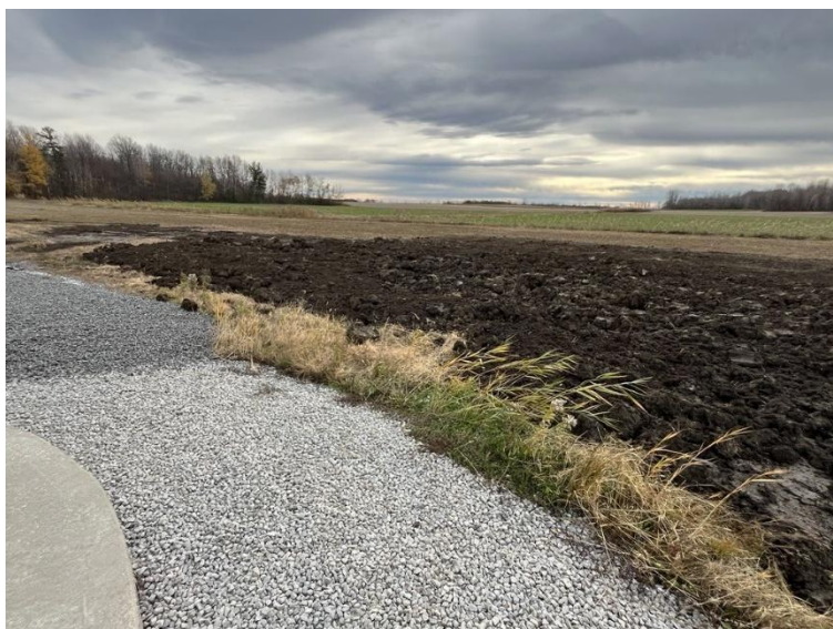
Figure 11. Éolienne T6 – Travaux de drainage effectué – Parcelle JMH-3 (11/2025)
