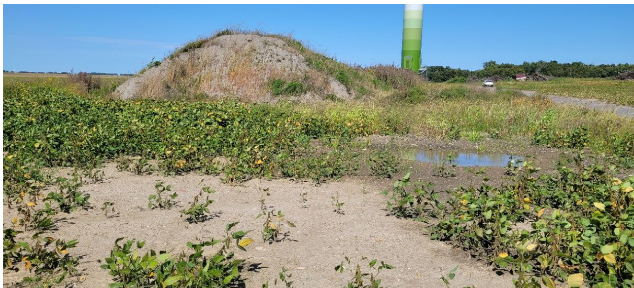
Figure 7. Éolienne T4 – Décompaction inefficace et amas de déblai – Parcelle TYD-2 (09/24)
