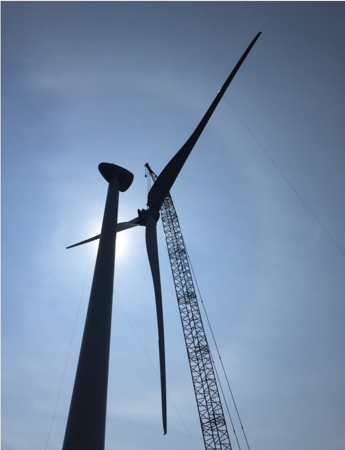
Figure 2-10 Installation du rotor d'une éolienne
