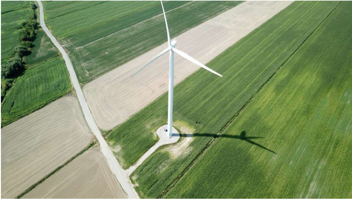
Photo de drone de la PS09 (11 août 2025) – OPSIS, Solutions Écoénergétiques
