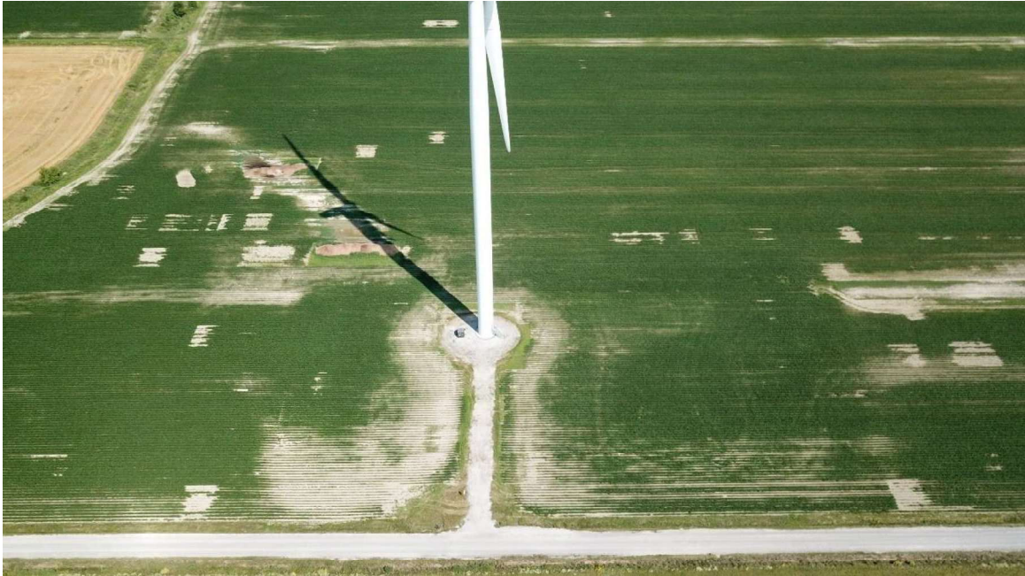
Photo de drone de la PS05 (11 août 2025) – OPSIS, Solutions Écoénergétiques
