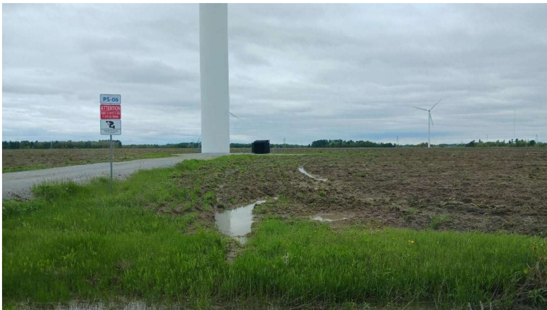
Photo 1 – Accumulation d'eau autour de la PS06 (09 juin 2025)
