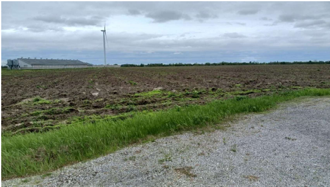
Photo 2 – Accumulation d'eau autour de la PS06 (09 juin 2025)
