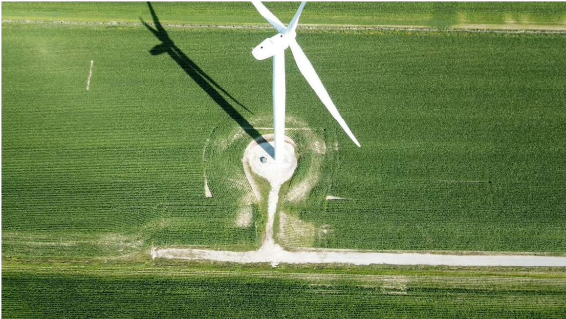
Photo de drone de la PS01 (11 août 2025) – OPSIS, Solutions Écoénergétiques
