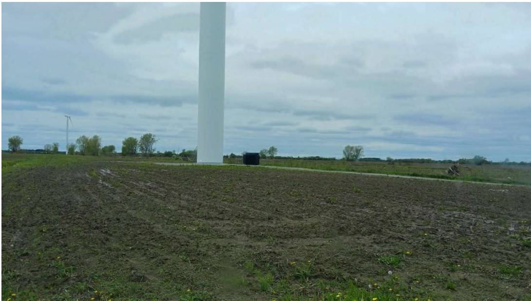
Photo 1– Zone en avant de la PS11 (09 juin 2025) – légère accumulation d’eau.
