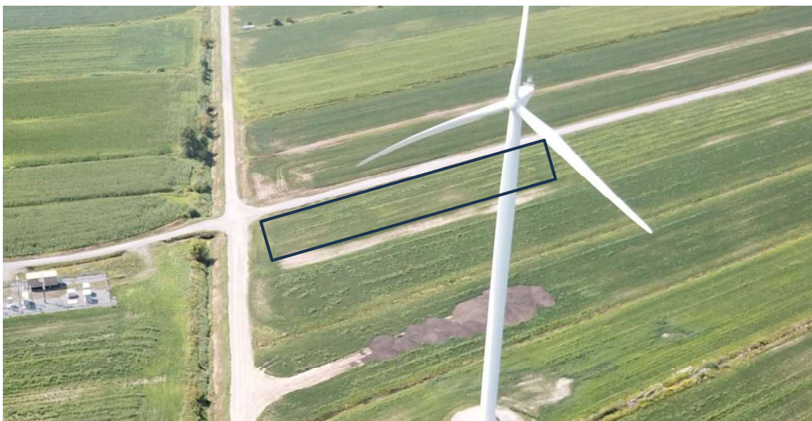
Photo de drone du stationnement (08 août 2024) – OPSIS, Solutions Écoénergétiques
