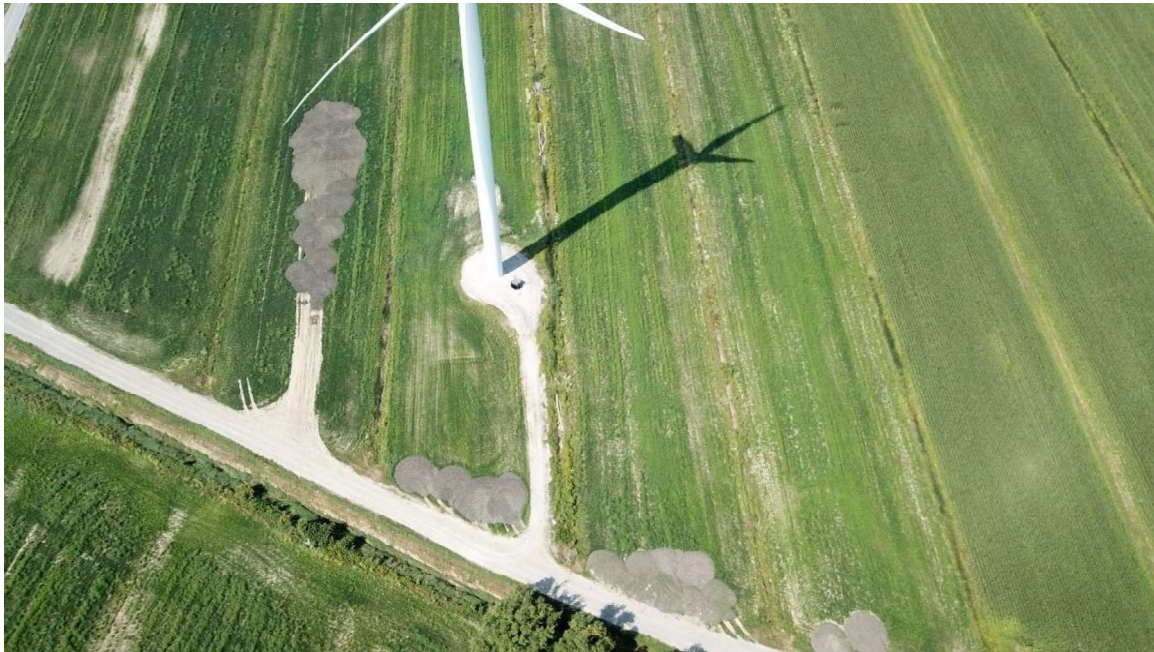
Photo de drone de la PS11 (11 août 2025) – OPSIS, Solutions Écoénergétiques
