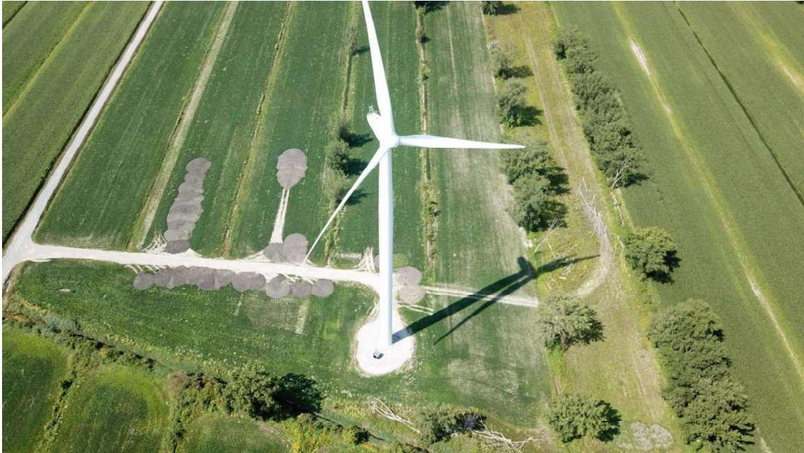
Photo de drone de la PS04 (11 août 2025) – OPSIS, Solutions Écoénergétiques
