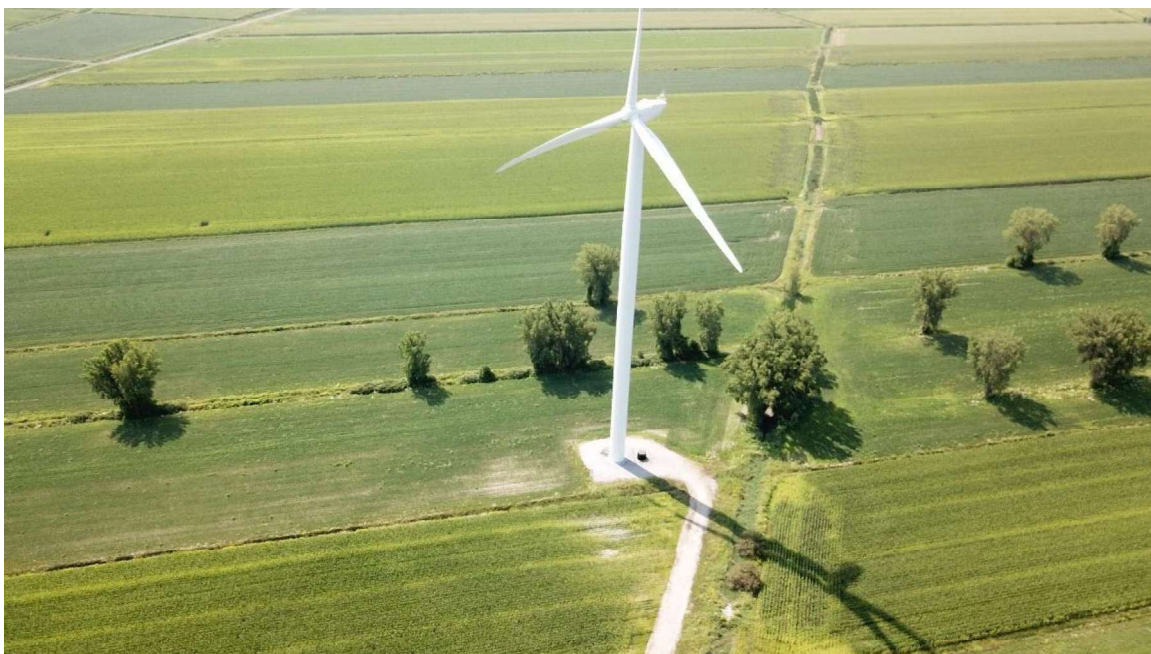
Photo de drone de la PS12 (11 août 2025) – OPSIS, Solutions Écoénergétiques
