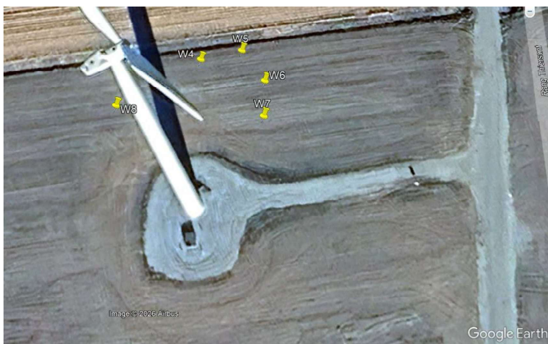
Photo 5 – zone avec des plants sont manquants autour de la PS09 – zone la plus touchée (15 octobre 2025)
