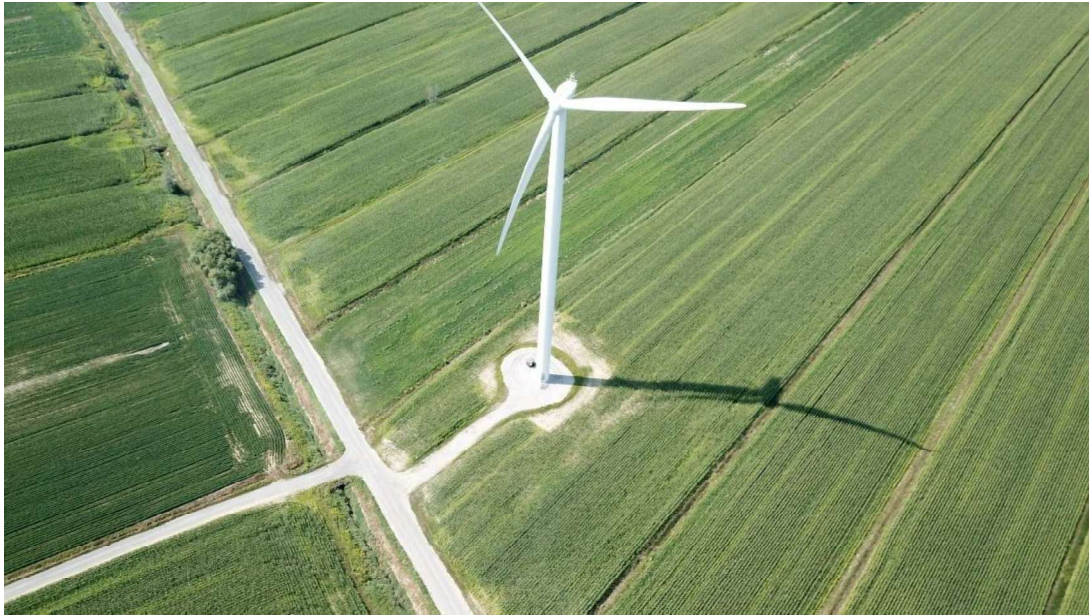
Photo de drone de la PS10 (11 août 2025) – OPSIS, Solutions Écoénergétiques
