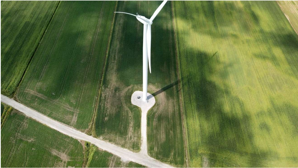
Photo de drone de la PS10 (08 août 2024) – OPSIS, Solutions Écoénergétiques
