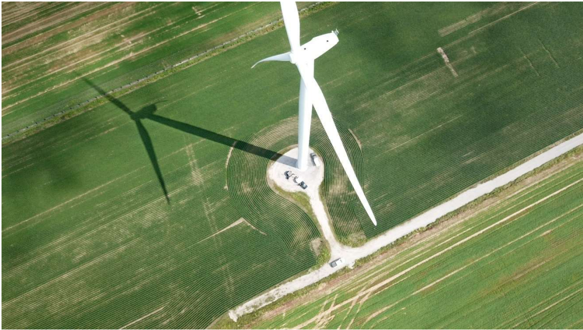
Photo de drone de la PS01 (08 août 2024) – OPSIS, Solutions Écoénergétiques
