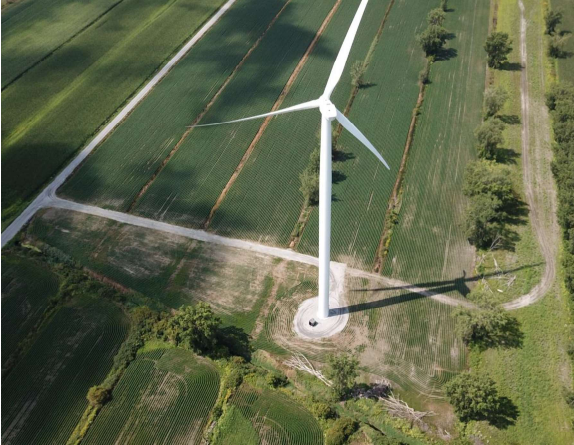
Photo de drone de la PS04 (12 août 2024) – OPSIS, Solutions Écoénergétiques
