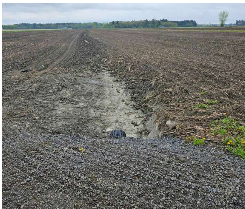
Photo 2 – Correction du ponceau du chemin en allant vers la PS12, (16 mai 2024) – champ près du chemin Brouillard
