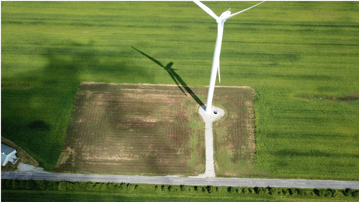
Photo de drone de la PS05 (08 août 2024) – OPSIS, Solutions Écoénergétiques
