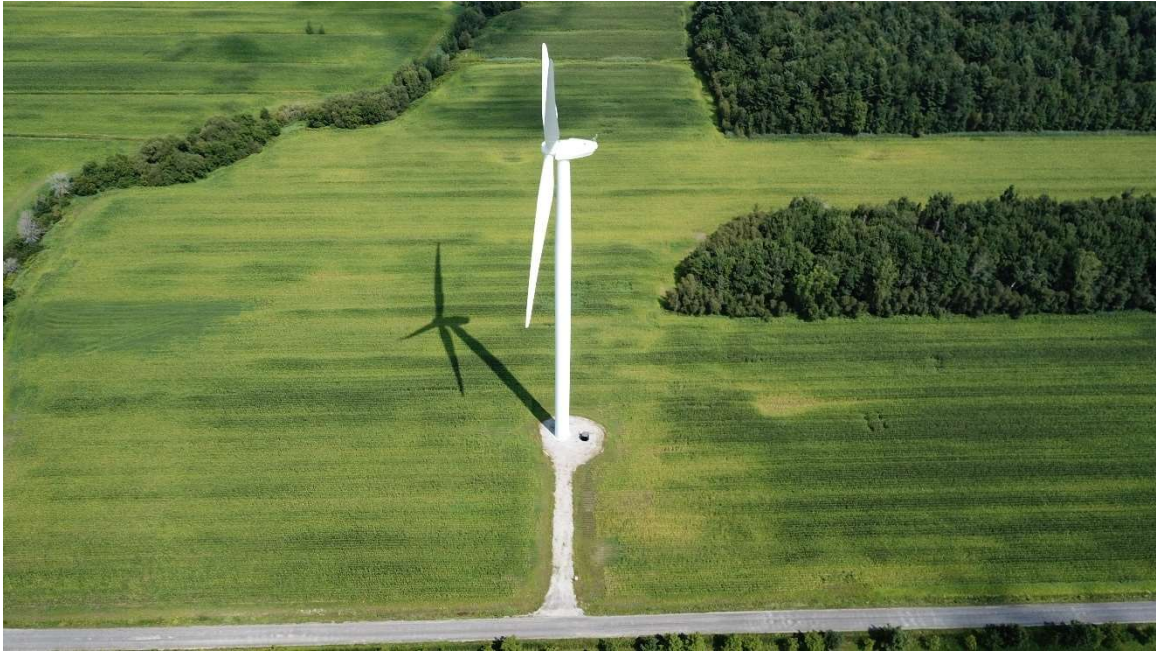
Photo de drone de la PS07 (08 août 2024) – OPSIS, Solutions Écoénergétiques
