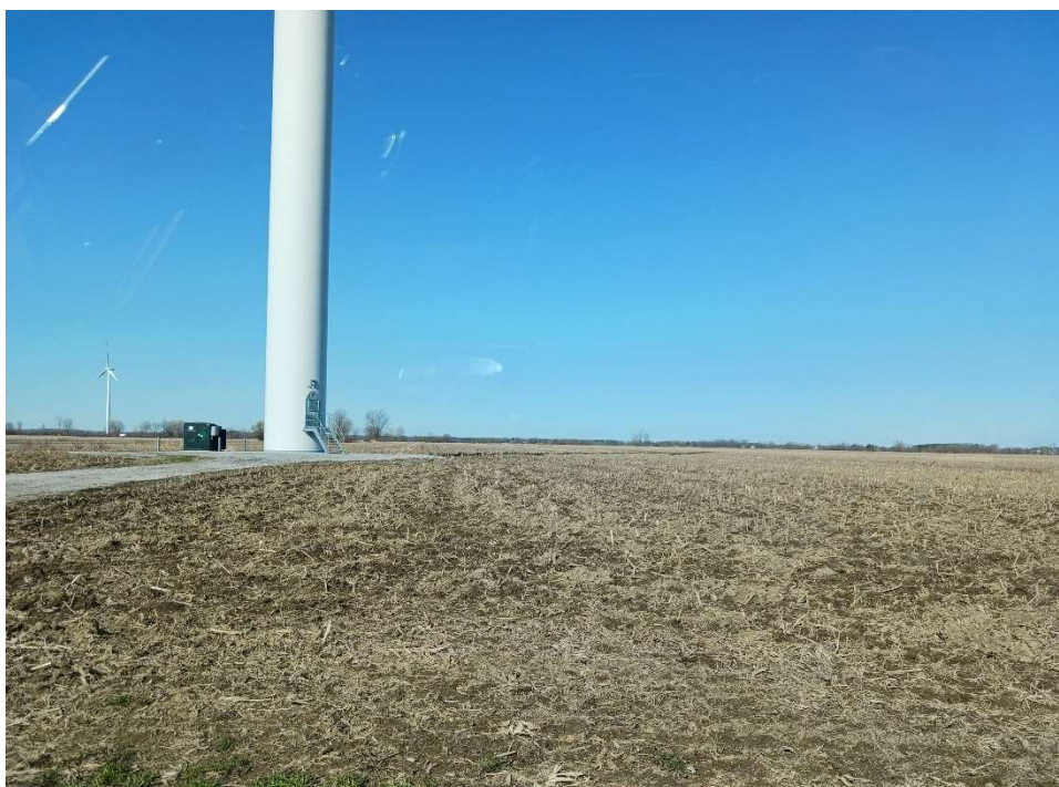
Photo 1 – Aucune accumulation d'eau au printemps autour de la PS10 (26 avril 2024)
