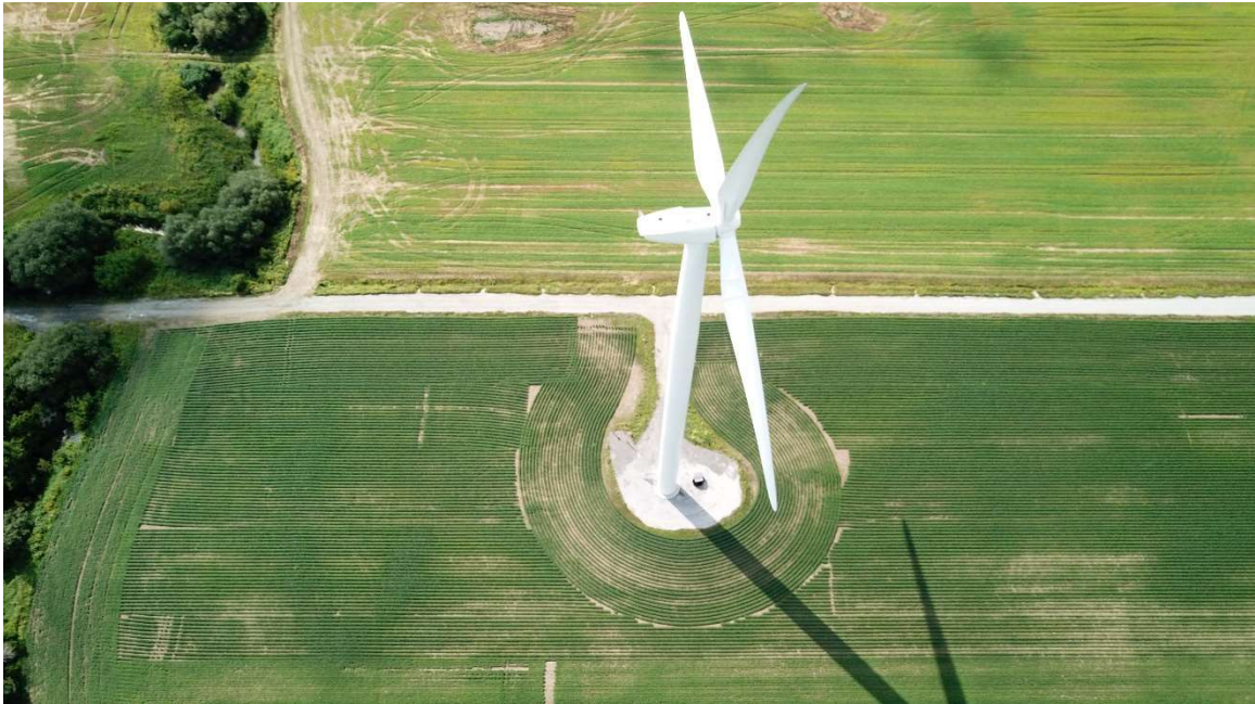
Photo de drone de la PS02 (08 août 2024) – OPSIS, Solutions Écoénergétiques
