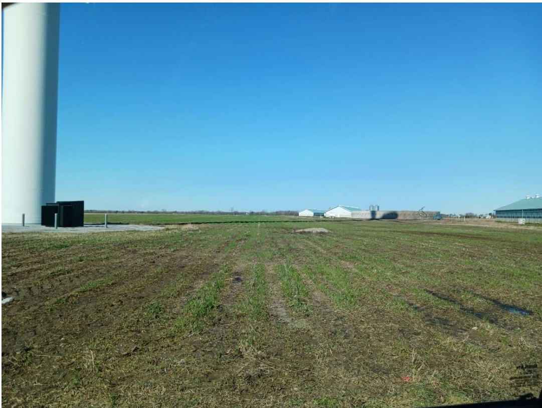
Photo 3 – Légère accumulation d'eau à l'extrémité droite de la PS08 (26 avril 2024)
