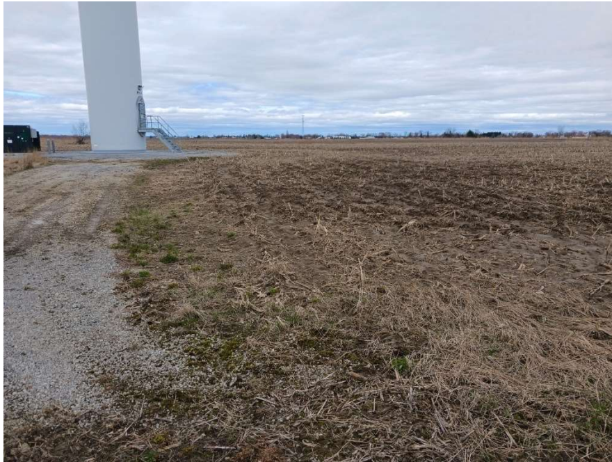
Photo 1 – Parcelle autour de la PS03 (16 avril 2024) – pas d'accumulation d'eau
