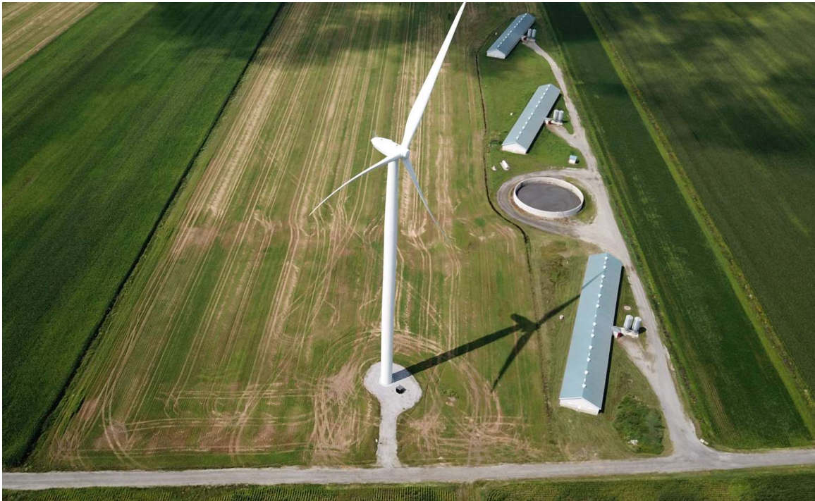
Photo de drone de la PS08 (8 août 2024) – OPSIS, Solutions Écoénergétiques
