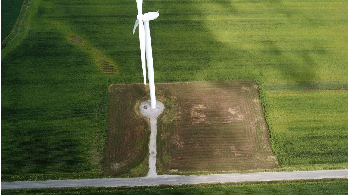
Photo de drone de la PS05 (08 août 2024) – OPSIS, Solutions Écoénergétiques
