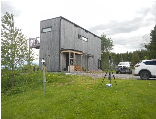
Photo 3. Vue dans la direction sud
