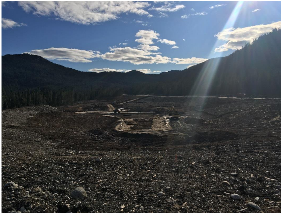
PHOTO 5 Masseku (18-09-2018) : Remblai de la surexcavation de 500 mm (en cours) de la limite supérieure du marécage (él. 249 m) jusqu'à la limite 247,4 m du marais par un déblai/remblai depuis la zone de dépôt de matériaux (amont) vers le marécage en contrebas
