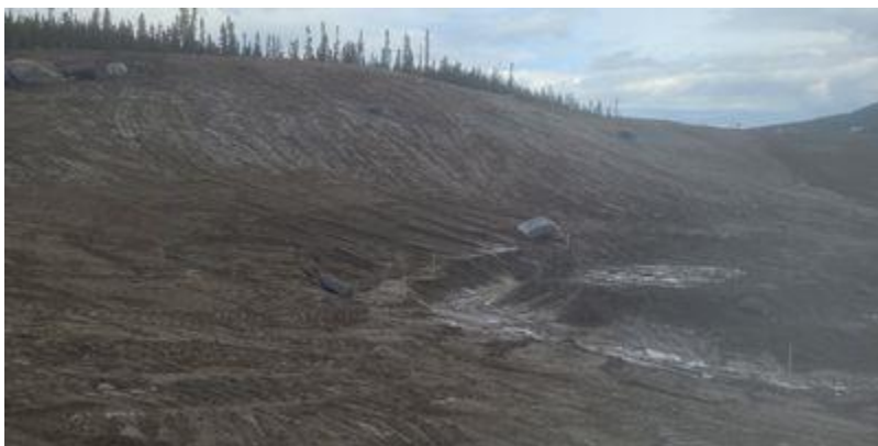
PHOTO 4 Till (14-06-2022) : excavation pour capter l'eau de la montagne pour garder zone 3 au sec
