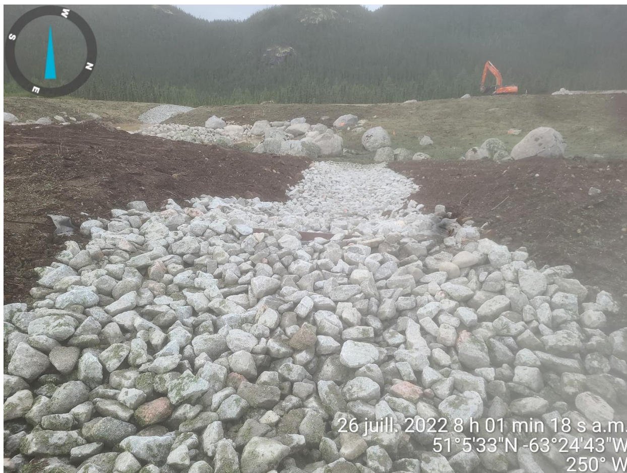
PHOTO 2 Étang du Till (26-07-2022): Déversoir en enrochement no 2 entre zone 2 et 1, fini à 100% avec plaque d'acier
