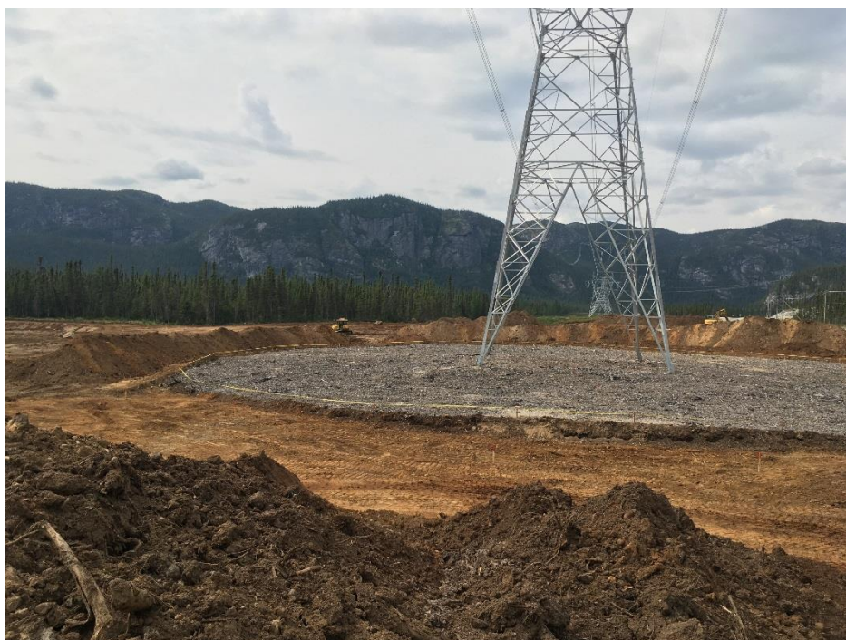
PHOTO 12 Mista (21-08-2018) : Respect du rayon de protection de 30 m autour du pylône et des élévations maximales des déblais dans l'emprise de la ligne de transport d'énergie
