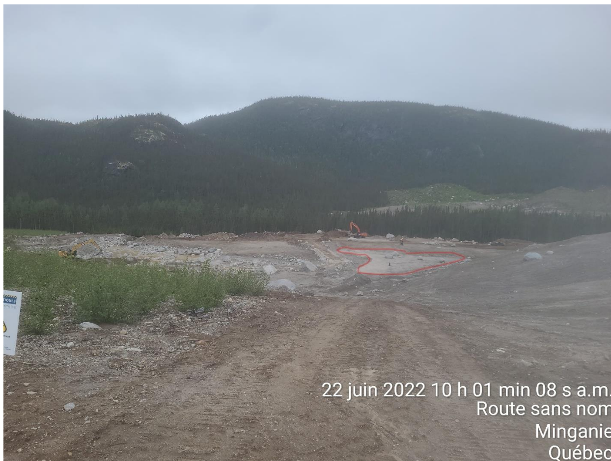
PHOTO 8 Étang du Till (22-06-2022): Observation de la zone 2 fini à 75% avant la mise en place de la terre végétale. Zone 2 délimitée en rouge (vue sud).
