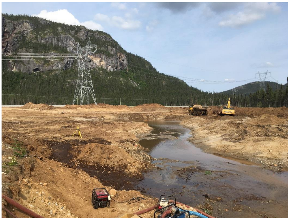
PHOTO 15 Mista (21-08-2018) : Excavation et profilage du plan d'eau peu profonde sud en cours
