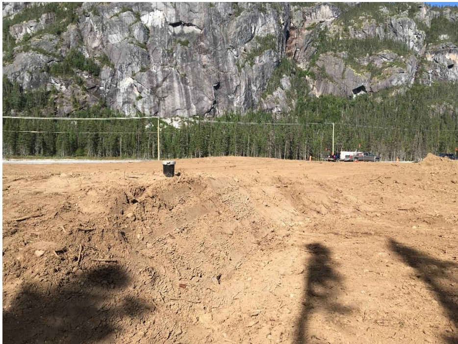
PHOTO 10 Mista (04-09-2018) : Terrassement autour du piézomètre P53-PO-1F
