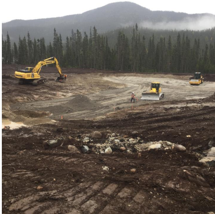
PHOTO 1 Maseku (29-09-2018) : Mise en place et compactage d'une couche de 500 mm de till provenant du dépôt RO3-5C-Est pour étanchéiser le marais de la zone humide 2 (vue sud-est)
