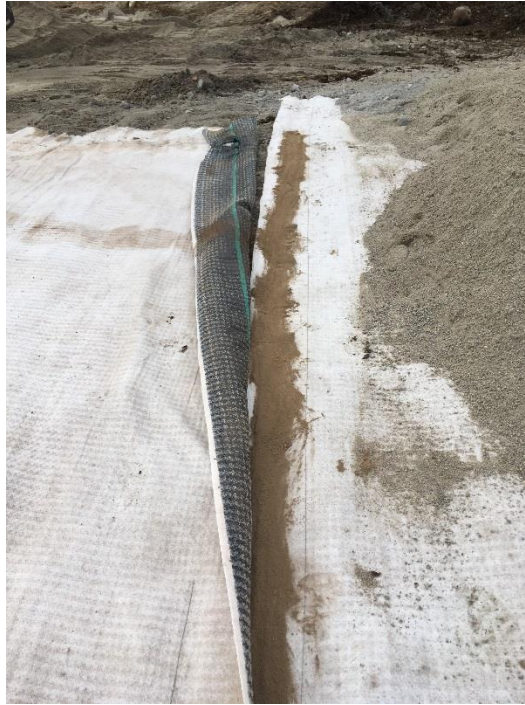
PHOTO 13 Masseku (19-09-2018) : Scellement des joints du géocomposite bentonitique avec de la bentonite sèche
