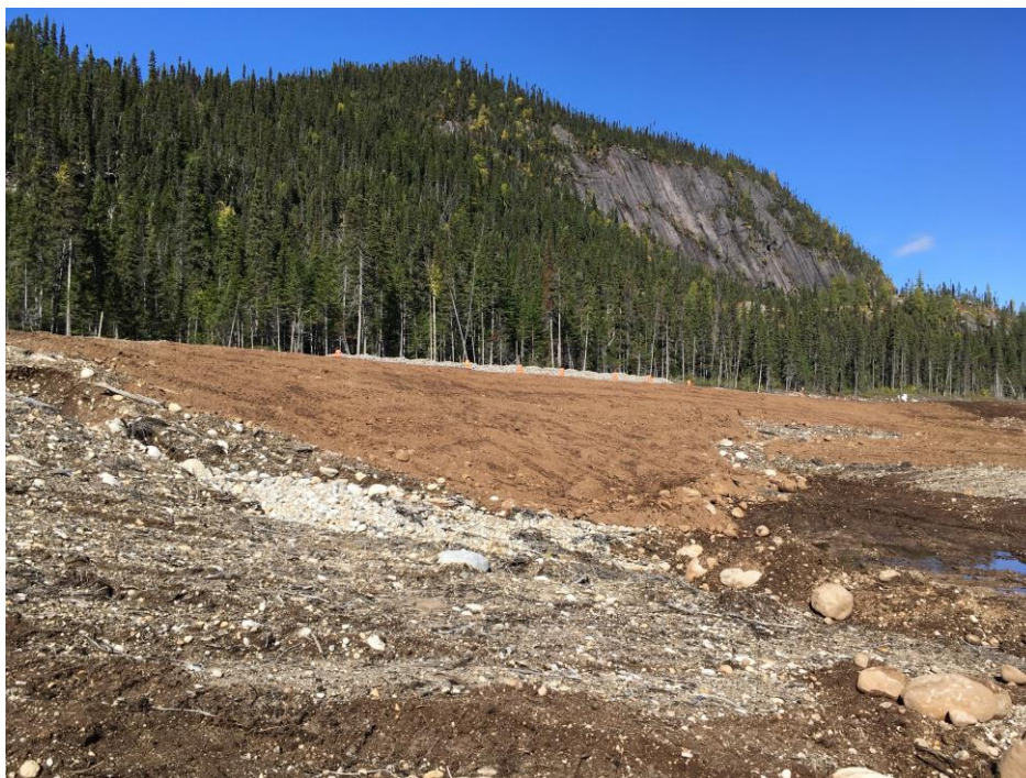
PHOTO 10 Masseku (27-09-2018) : Nivelage des talus des zones de dépôt des matériaux à l'ouest de la zone
