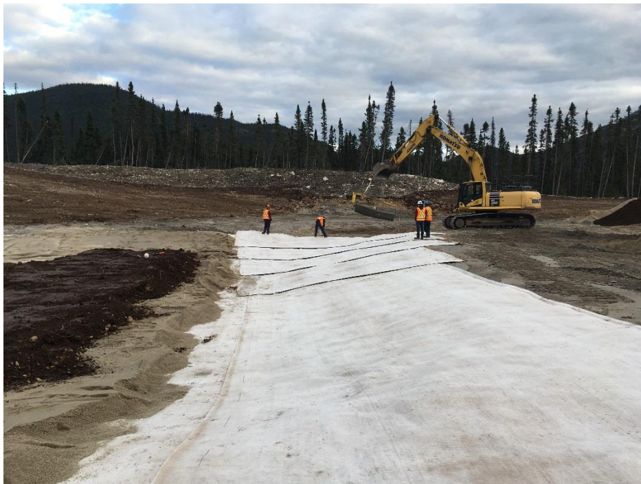
PHOTO 14 Masseku (19-09-2018) : Sable à béton utilisé pour la couche de protection du géocomposite bentonitique et terre végétale de recouvrement (zone 1)
