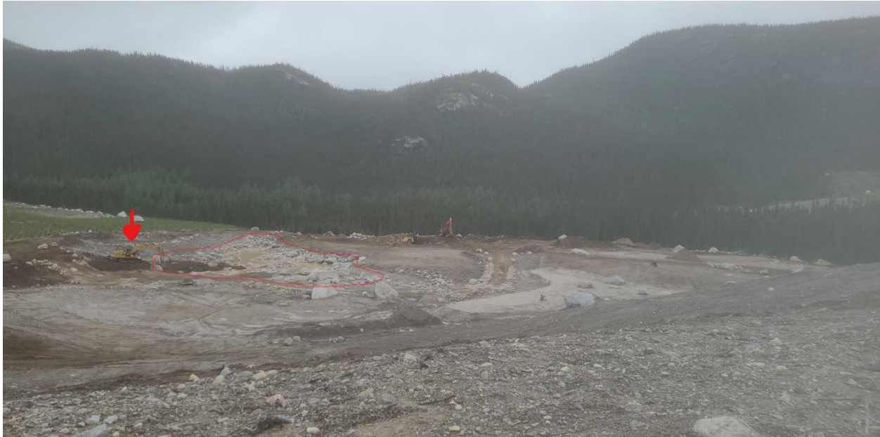
PHOTO 1 Étang du Till (22-06-2022) : Zone 1, sud-est. Travaux pour enlever les pierres de moins d'un mètre en cours (à gauche de la photo). Photo prise vers le Sud. Zone 1 délimitée en rouge et flèche pointant la machinerie effectuant les travaux en cours.
