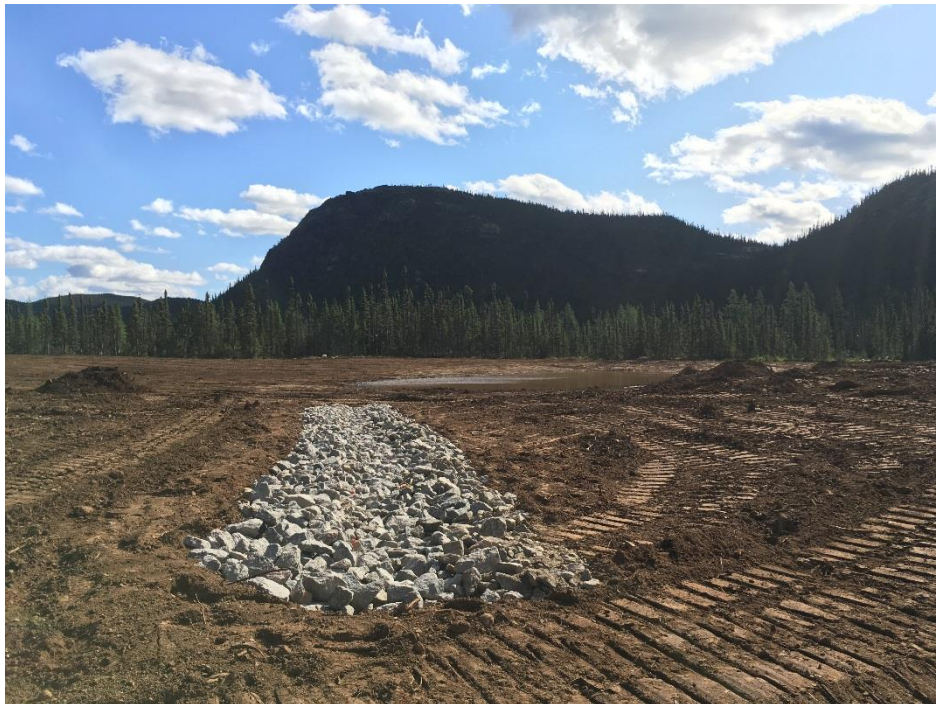
PHOTO 2 Mista (04-09-2018) : Aménagement du canal de débordement entre les plans d'eau nord et sud
