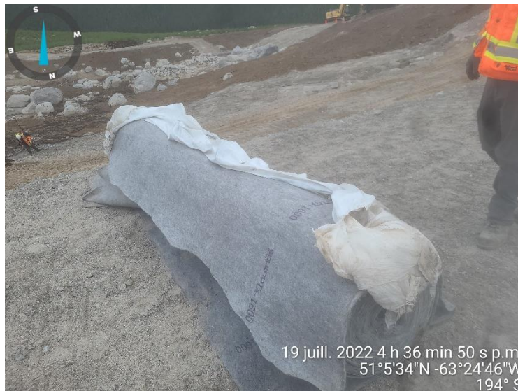
PHOTO 2 Étang du Till (20-07-2022): Géotextile selon les normes du devis
