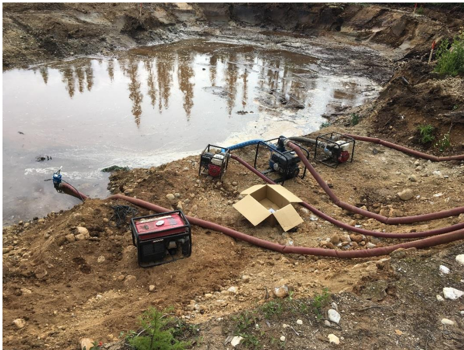
PHOTO 5 Mista (21-08-2018) : Assèchement des excavations pour le profilage du plan d'eau sud. Le surveillant a recommandé à l'entrepreneur de mettre des bassins sous les équipements en bordure du point d'eau puisque les eaux de pompage sont rejetées dans l'environnement
