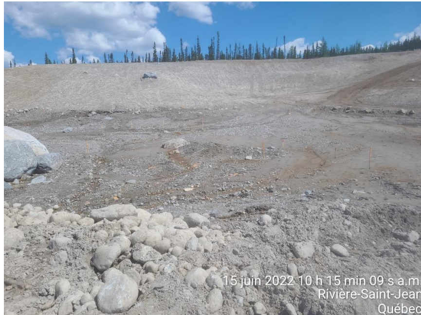
PHOTO 1 Étang du Till (15-06-2022) : Zone 2, Nord-Est, terre végétale enlevée. Futures zones d'excavation délimitées par les piquets.
