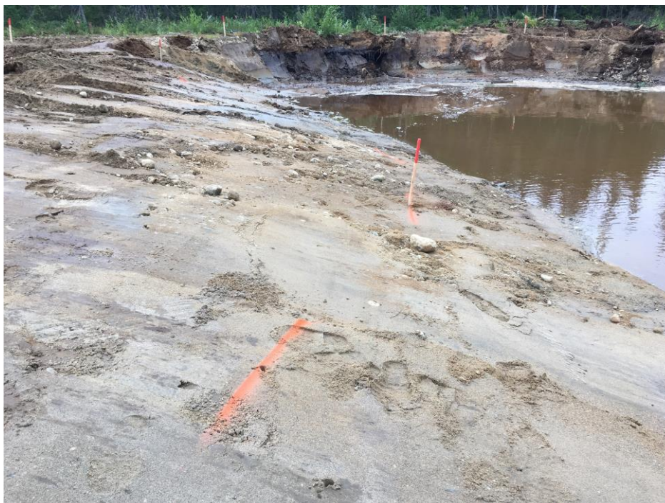
PHOTO 19 Mista (22-08-2018) : Marquage des élévations et des contours pour l'excavation du plan d'eau sud
