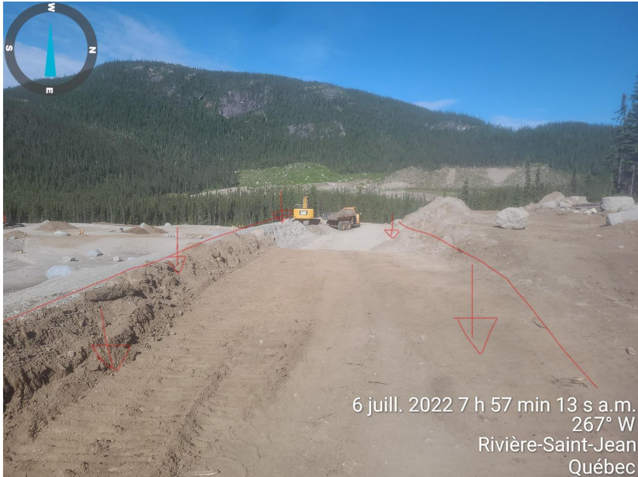
PHOTO 1 Étang du Till (07-06-2022) : excavation du matériel d'un ancien chemin d'accès au nord des zones 2 et 3 pour la mise en forme des remblais des zones 2, 3 et 4
