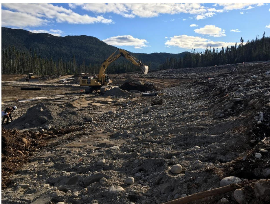
PHOTO 4 Masseku (18-09-2018) : Surexcavation non conforme de 500 mm ayant été réalisée jusqu'à la limite supérieure du marécage (él. 249 m) de la zone 1
