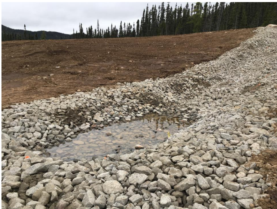
PHOTO 7 Masseku (03-10-2018) : Aménagement du canal empierré et de la fosse d'affouillement entre les zones humides 2 et 4 (enrochement, membrane de type II)
