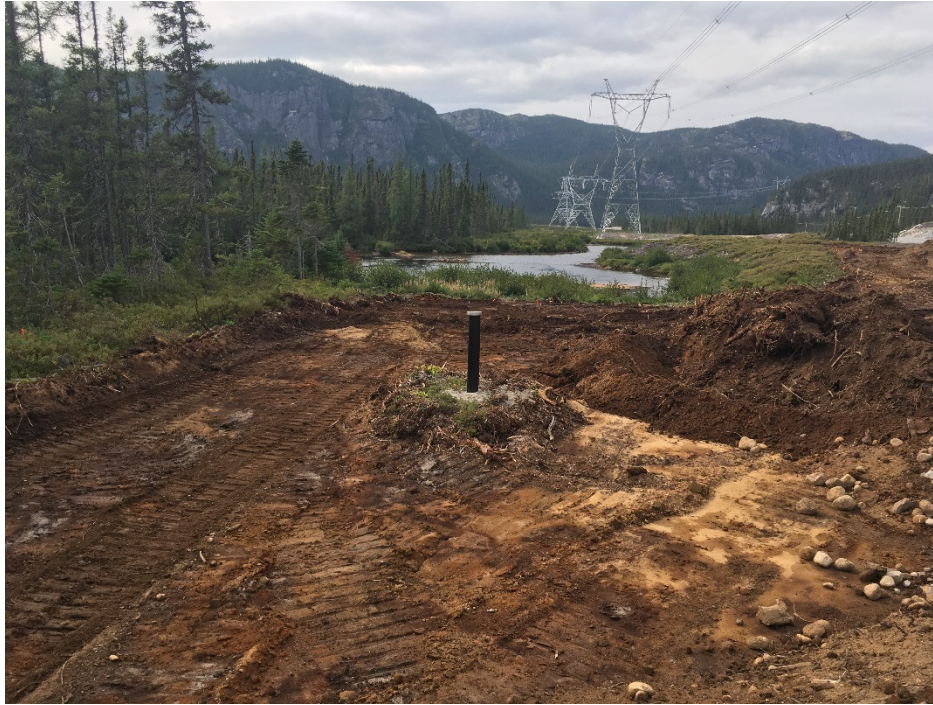
PHOTO 9 Mista (29-08-2018) : Protection du piézomètre P53-PO-1F
