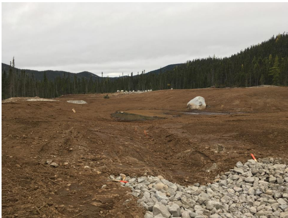
PHOTO 9 Masseku (03-10-2018) : Aménagement du canal ensemené entre les zones humides 1 et 2 (vue sud-ouest vers la zone 2)
