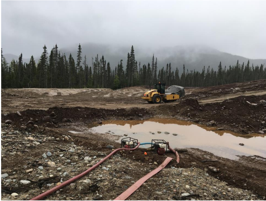
PHOTO 5 Masseku (26-09-2018) : Assèchement de la zone 2 en préparation pour l'excavation du mort-terrain; évacuation de l'eau de pompage vers des fosses excavées pour les matériaux de la digue
