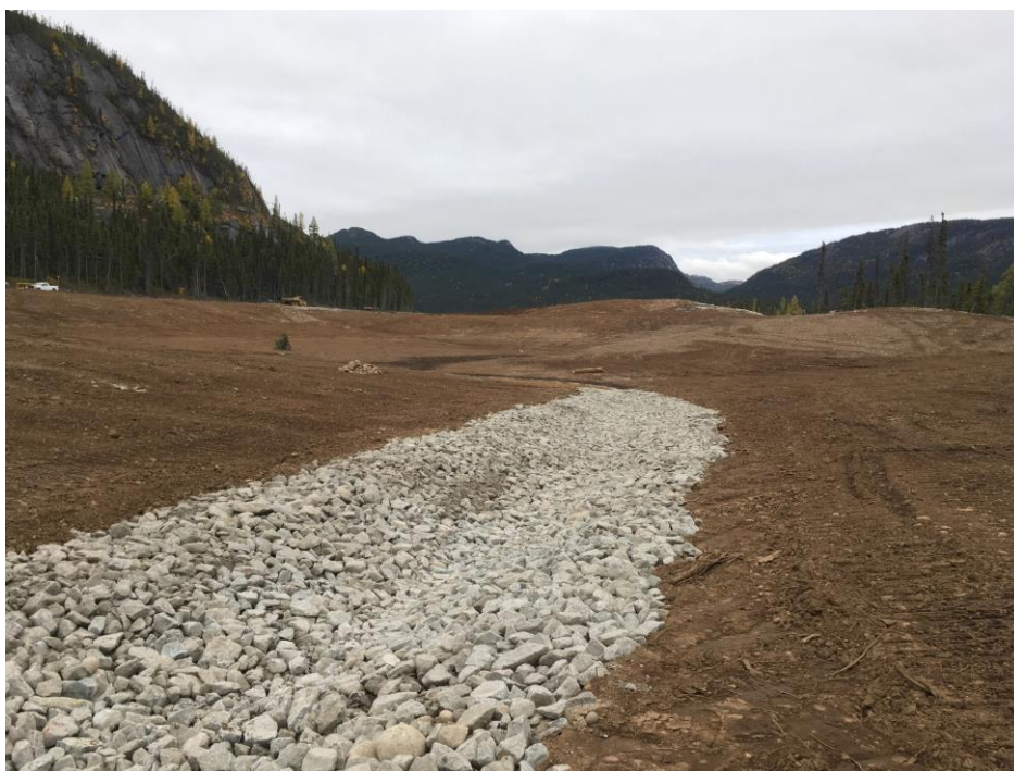
PHOTO 8 Masseku (03-10-2018) : Aménagement du canal empierré entre les zones humides 1 et 2 (enrochement, membrane de type II) (vue nord vers la zone 1)
