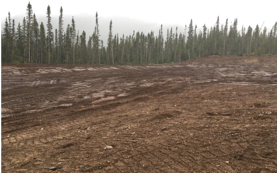
PHOTO 6 Masseku (26-09-2018) : Le mort-terrain (infra) est mis en forme et la T.V. épanchée sous l'élévation 250 m dans la zone 3
