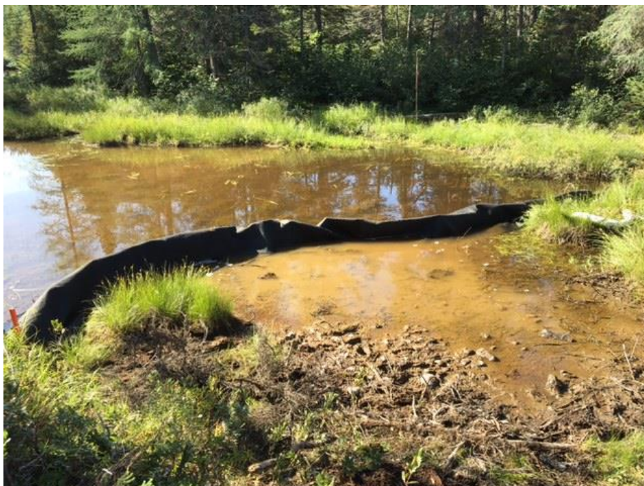
PHOTO 23 Mista (01-09-2018) : Barrières à sédiments installées lors de l'excavation du canal sud
