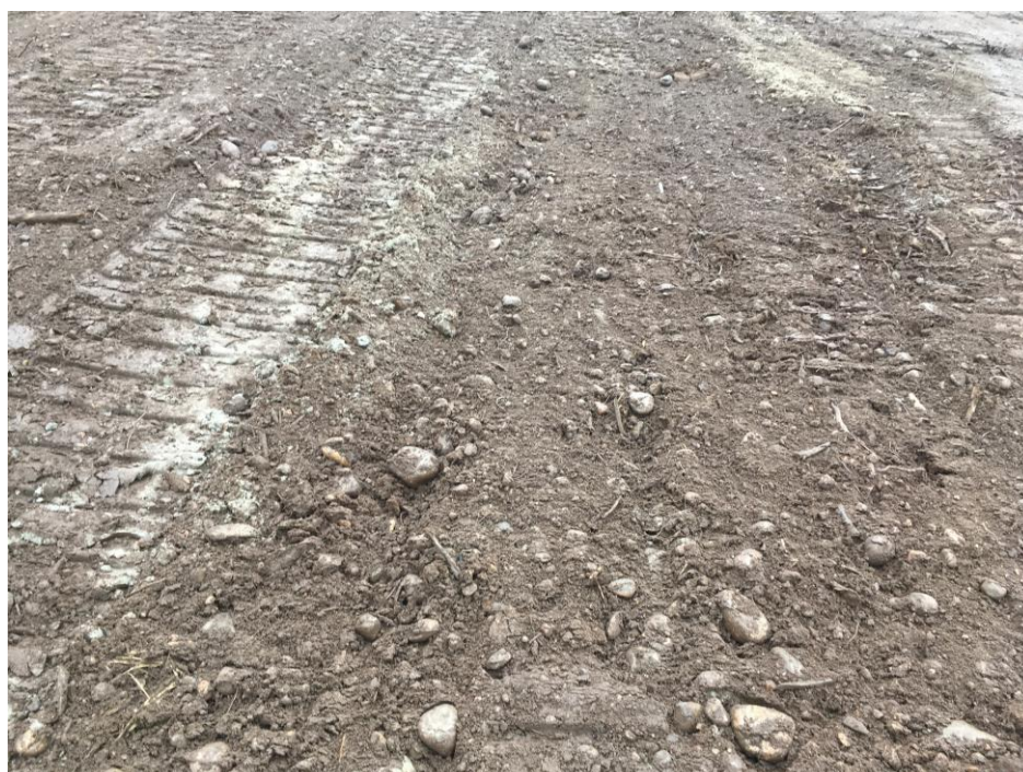
PHOTO 8 Masseku (26-09-2018) : Les zones de dépôt de matériaux au-dessus de l'élévation 250 m qui comporte suffisamment de matière organique (6-30 %) ont été nivelées au T.N. seulement pour conserver la T.V. de qualité pour les milieux humides et hydriques sous la barre du 250 m
