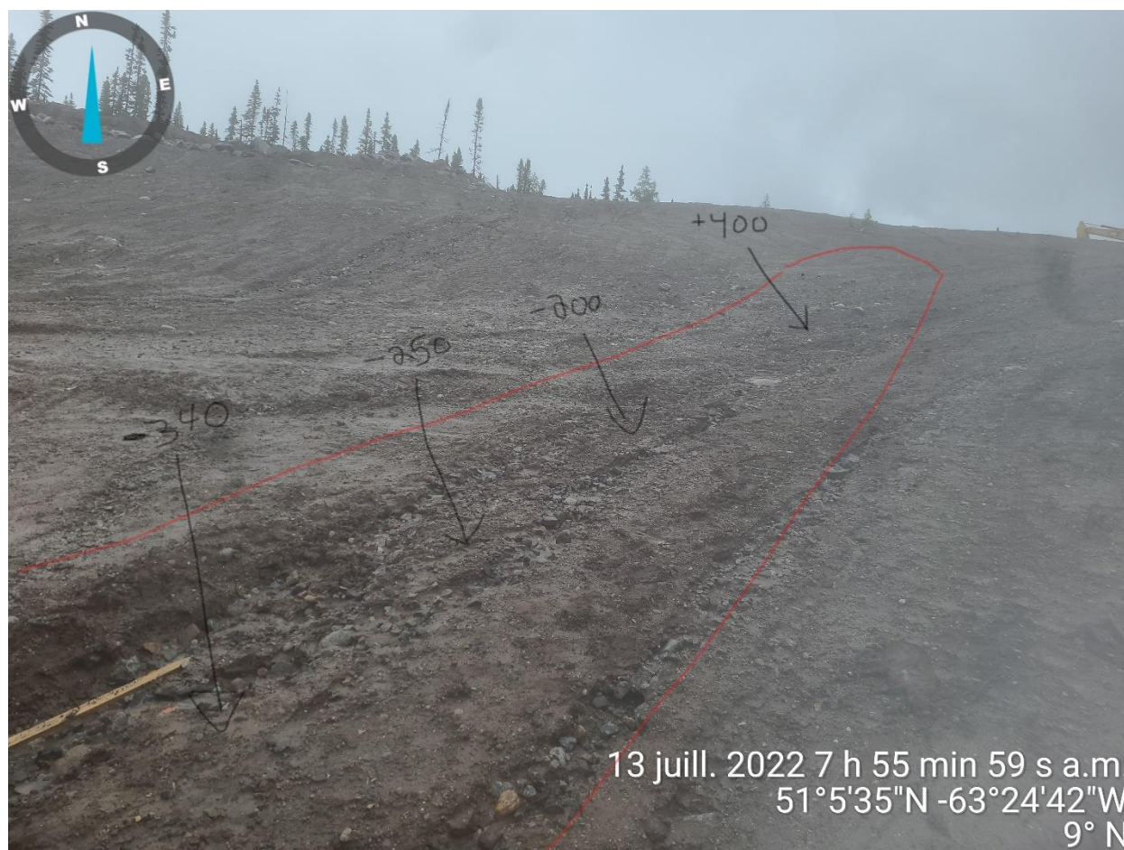
PHOTO 2 Till (13-07-2022) : Canal d'enrochement G au nord de la zone 2, remblais et déblais nécessaire pour respecter le devis
