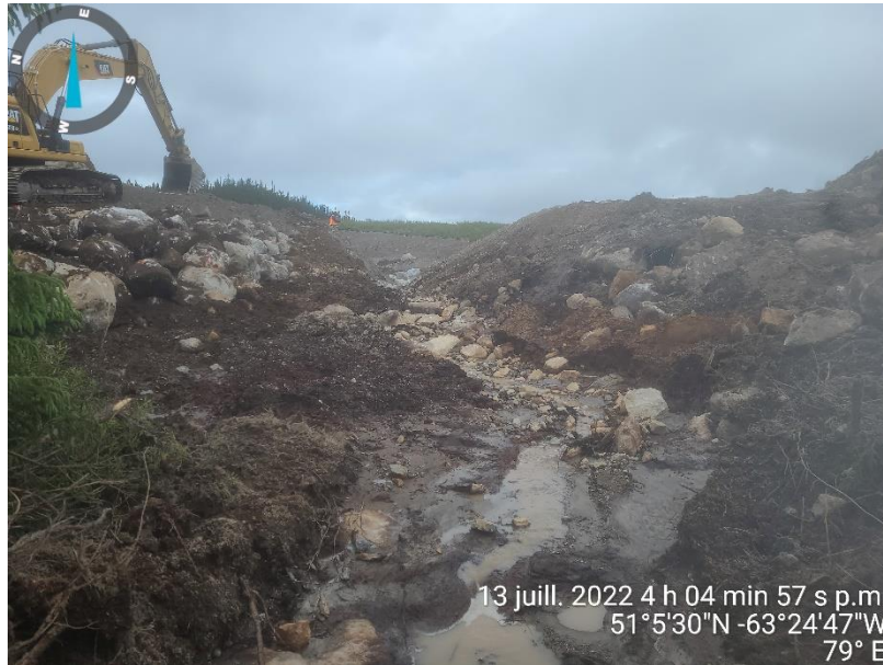
PHOTO 17 Till (13-07-2022): Travaux d'excavation du déversoir B
