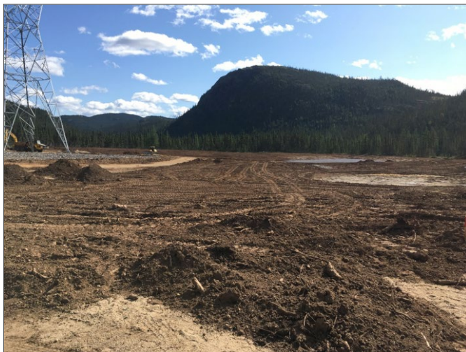
Photo 1 Étang du Mista (04-09-2018) – Épandage de la terre végétale autour du plan d'eau nord
