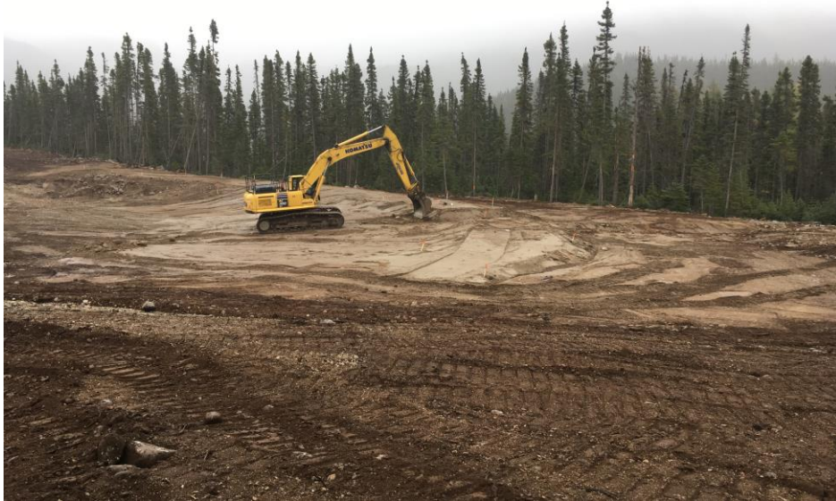
PHOTO 1 Masseku (26-09-2018) : Infra de la zone de remblai ou digue de la zone 2 terminée
