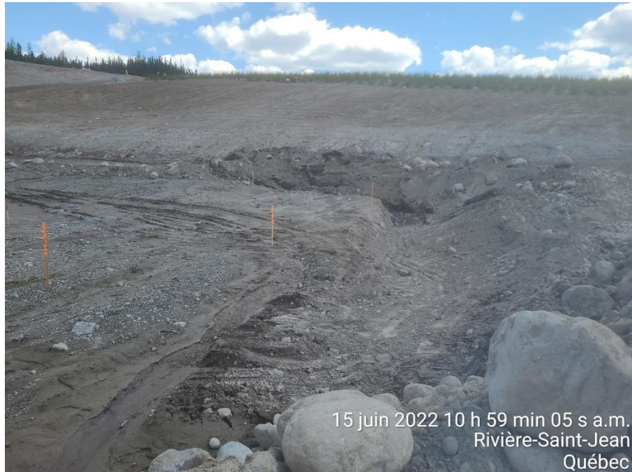
PHOTO 5 Étang du Till (15-06-2022) Canal temporaire excavé pour drainer l'eau du plateau de la zone 2
