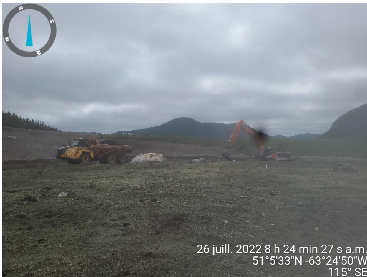
PHOTO 4 Étang du Till (26-07-2022) Épandage de la terre végétale entre les zones 4 et 3
