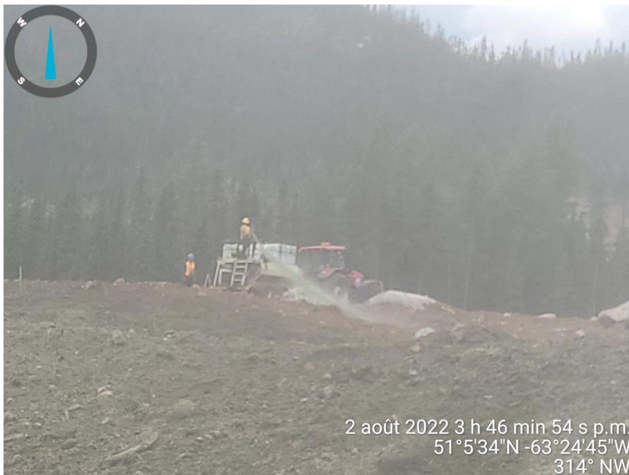
PHOTO 18 Étang du Till (03-08-2022) Finition de l'hydro-ensemencement de l'étang du Till. Encensement fini à 100% d'ici le 8 aout
