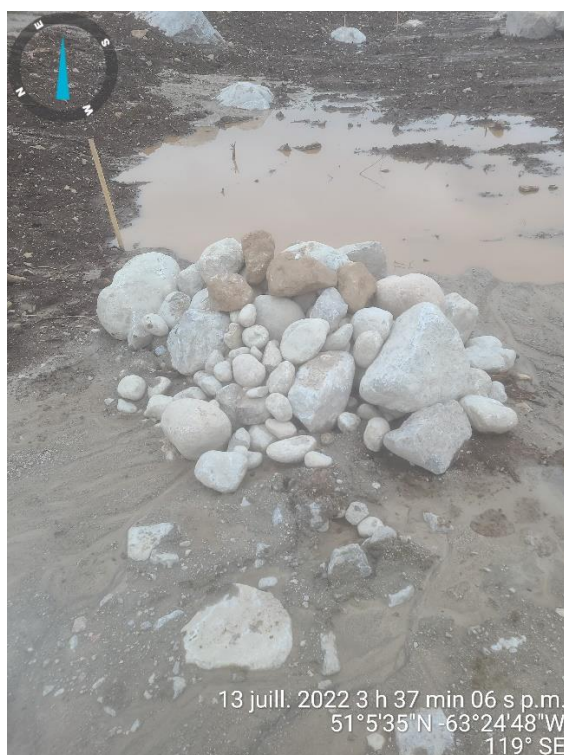
PHOTO 10 Till (13-07-2022): Amas de pierres zone 3, Nord-ouest près de l'amas de branches. Dimensions conformes de 60 cm de haut et 2 m de diamètre.
