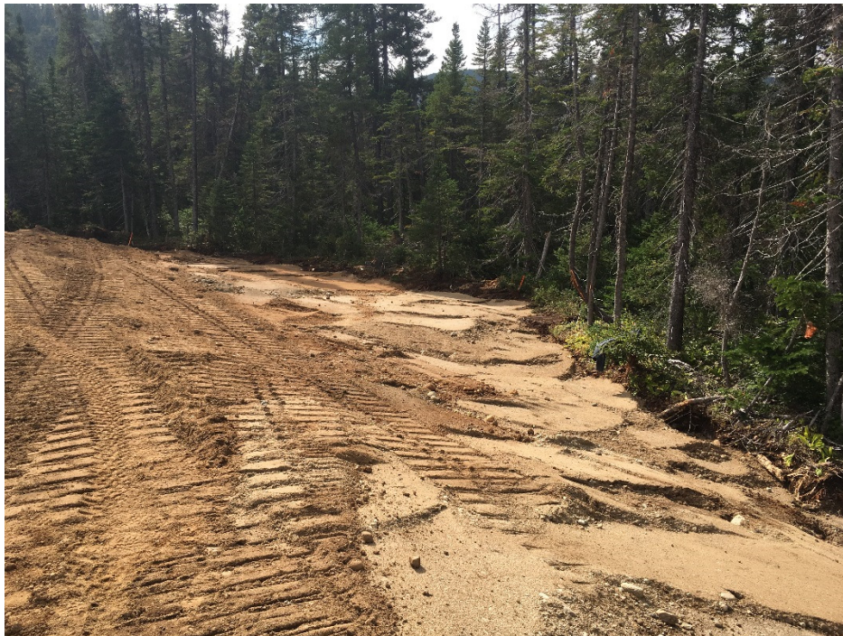
PHOTO 6 Mista (29-08-2018) : Ajustement des talus afin de se marier au T.N. existant pour ne pas déboiser là où les aménagements devaient être implantés à l'extérieur de la zone déboisée dans les coins sud-ouest (sur environ 150 m); la zone tampon de 3 m avec le boisé n'a pas été respectée dans ces secteurs pour des raisons évidentes; l'entrepreneur a pris soin d'exécuter les travaux en minimisant les dommages causés aux boisés
