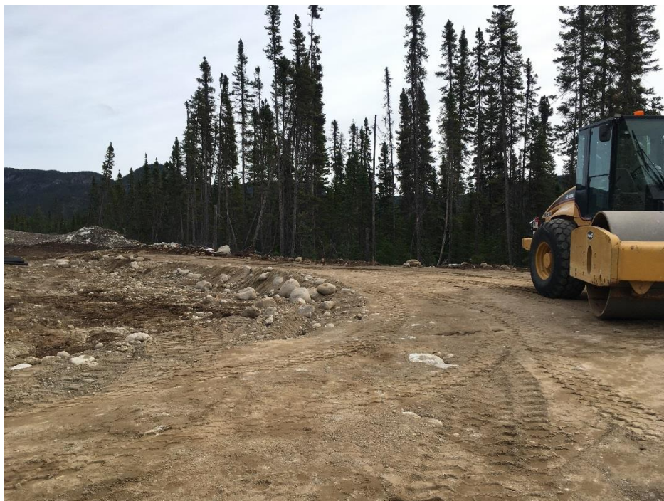
PHOTO 15 Masseku (19-09-2018) : Préparation de l'assise de la zone de remblai (digue) (zone 2)
