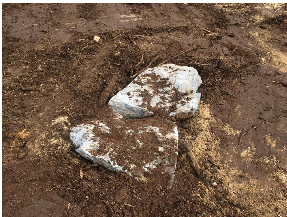
PHOTO 20 Mista (06-09-2018) : Enfouissement des pierres plates jusqu'au niveau du sol fini
