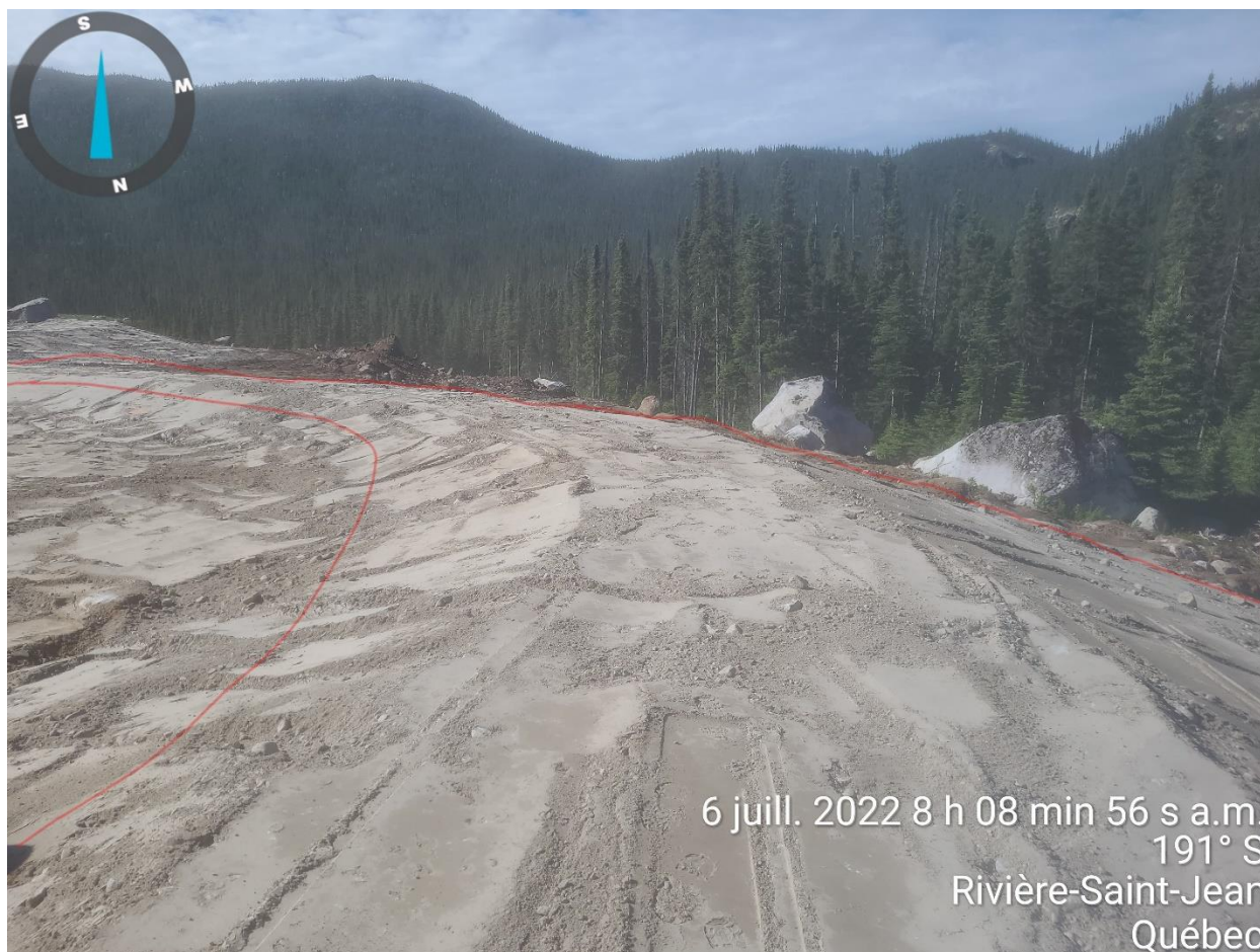
PHOTO 4 Étang du Till (07-06-2022) : Digue (remblai) zone 4 presque terminée
