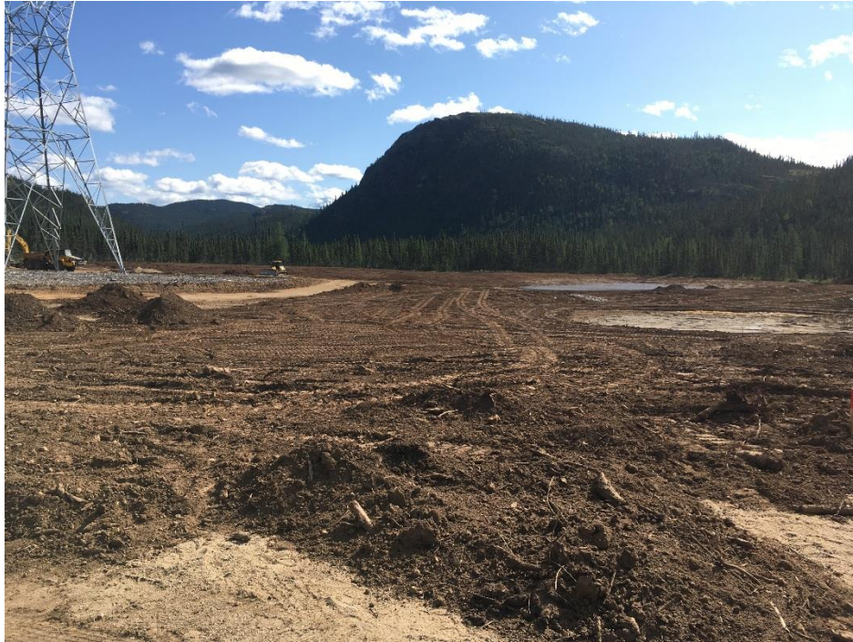
PHOTO 1 Mista (04-09-2018) : Épandage de la terre végétale autour du plan d'eau nord
