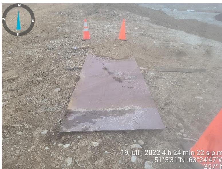
PHOTO 3 Étang du Till (20-07-2022) Plaque d'acier de 9,52 mm d'épaisseur respectant les mesures du devis pour le déversoir #1 au sud de la zone 1 et le déversoir #2 entre la zone 2 et 1.
