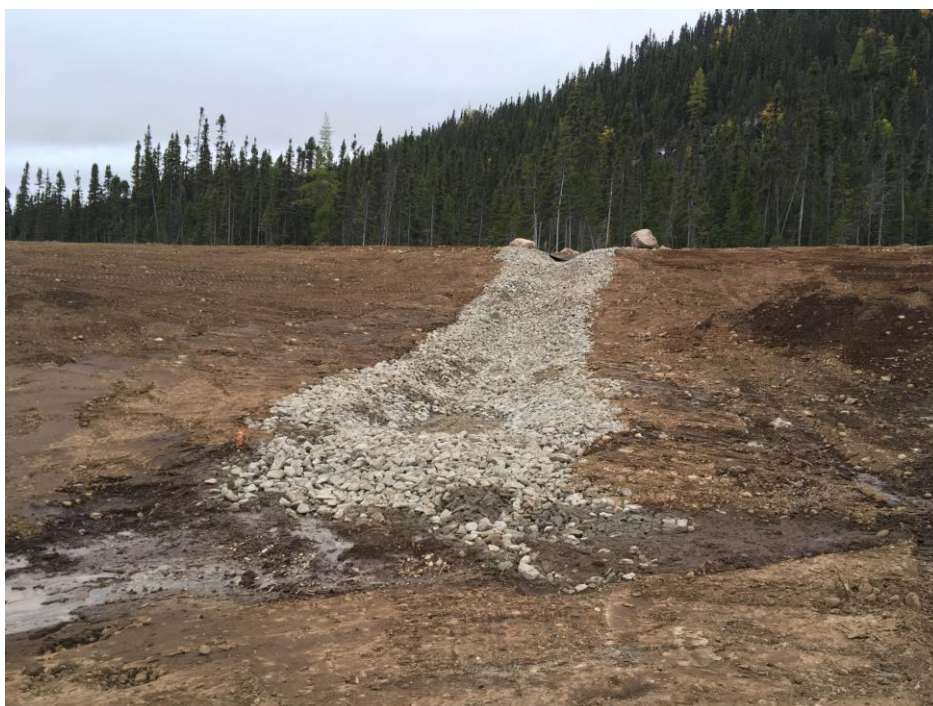
PHOTO 6 Masseku (03-10-2018) : Aménagement du canal empierré et de la fosse d'affouillement entre les zones humides 2 et 4 (enrochement, membrane de type II) (vue amont ou ouest vers la zone 4)
