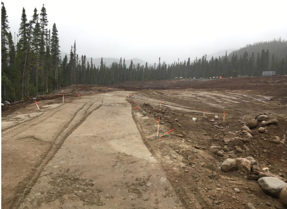
PHOTO 2 Masseku (26-09-2018) : Compactage ou rouleau compacteur par couche de 30 cm au niveau de la zone de remblai ou digue de la zone 2
