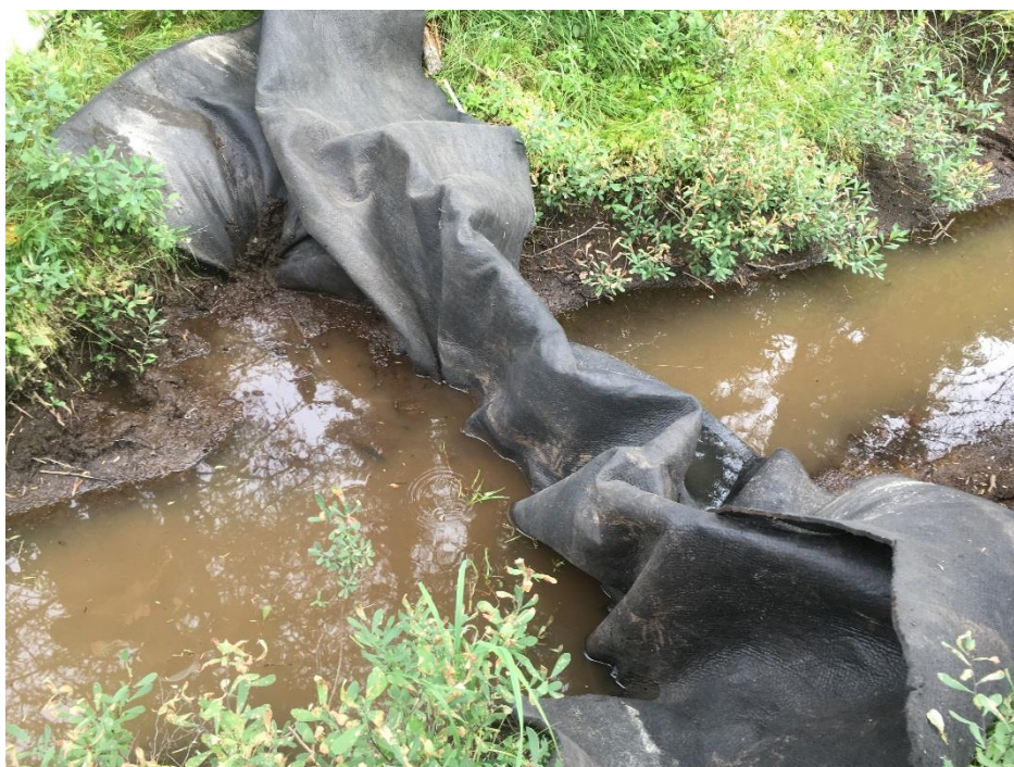
PHOTO 24 Mista (05-09-2018) : Barrière à sédiments installées pour contrer la sédimentation dans le ruisseau Mista (installation récente)
