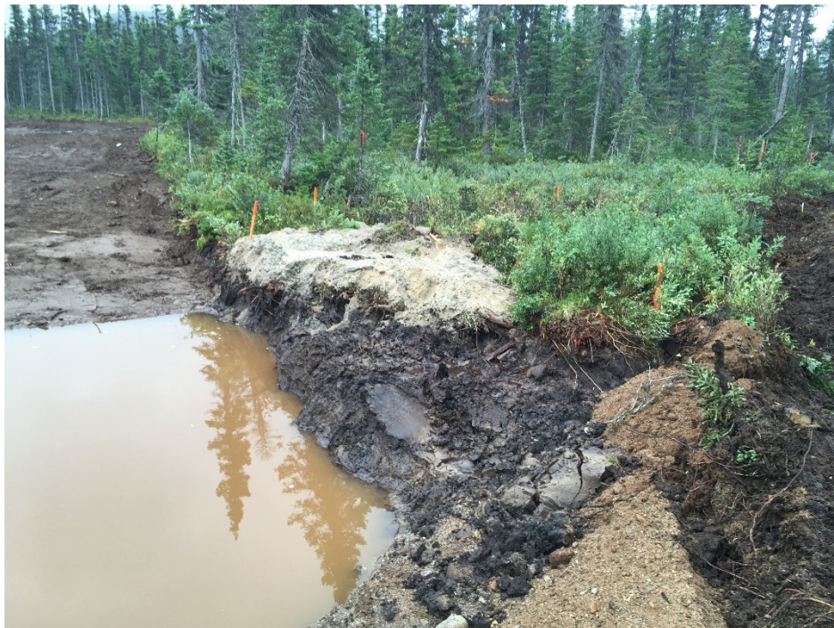
PHOTO 14 Mista (30-08-2018) : Bouchon conservé pour l'aménagement du plan d'eau sud (canal) et ce afin d'endiguer les matières en suspension et leur permettre de sédimenter
