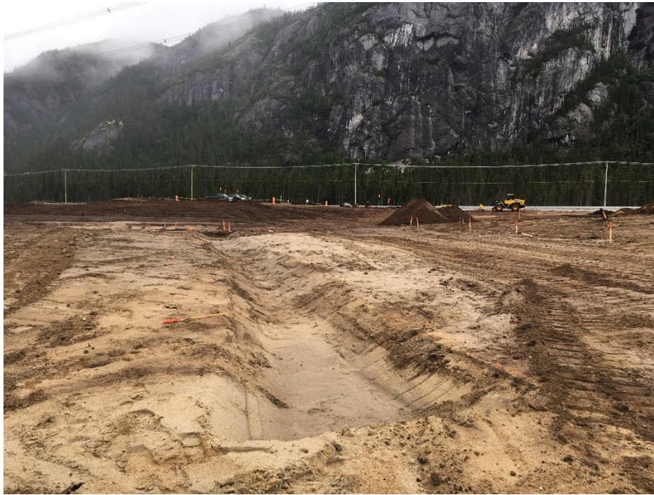
PHOTO 17 Mista (30-08-2018) : Mise en forme du canal de débordement entre les plans d'eau nord et sud
