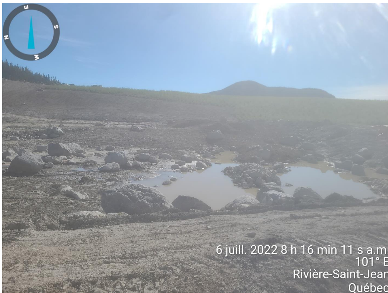
PHOTO 5 Étang du Till (07-06-2022) Excavation et enlèvement des roches de la zone 1 fini à 80% avant terre végétale.
