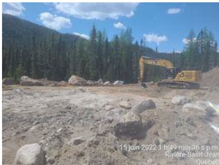
PHOTO 3 Étang du Till (15-06-2022) : ajout d'une deuxième pelle mécanique afin d'effectuer les travaux de décapage de la zone 3 et 4 simultanément.
