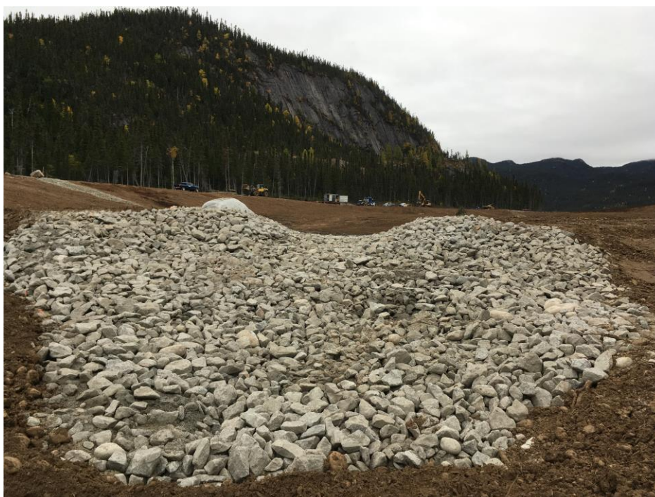
PHOTO 16 Masseku (03-10-2018) : Vue nord-ouest montrant la zone de remblai (zone 2) avec le déversoir empierré
