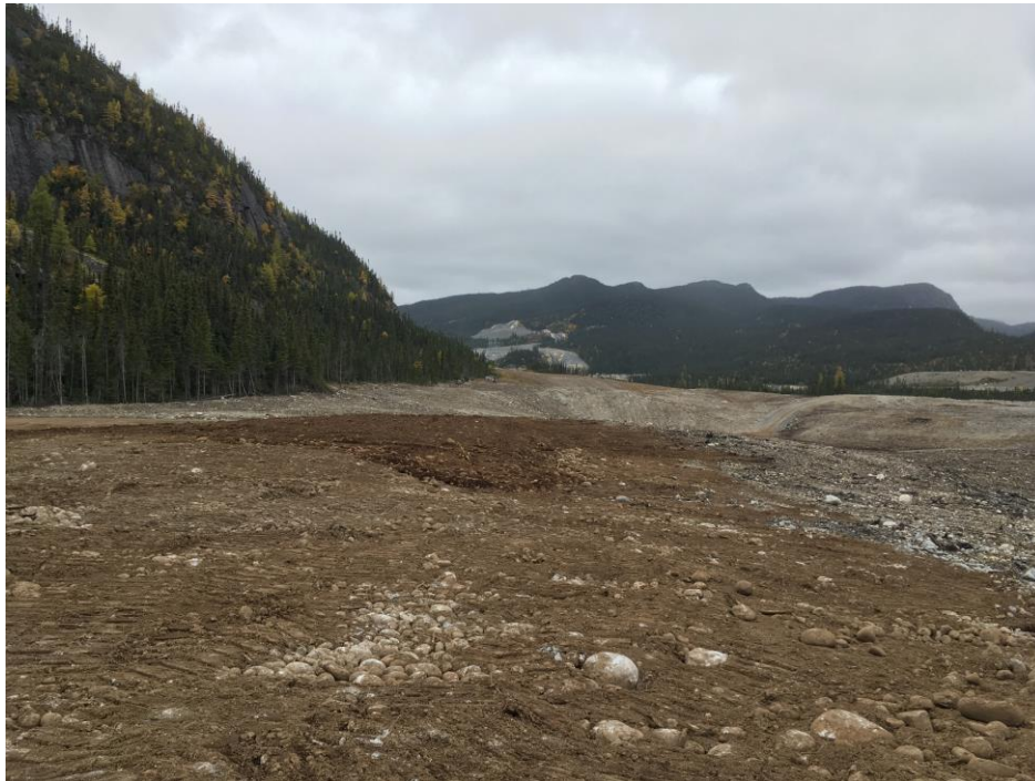
PHOTO 25 Masseku (03-10-2018) : Remise en état de la zone de dépôt des déblais excédentaires au nord par le nivelage et l'épandage des piles afin d'obtenir des pentes douces, uniformes et se mariant bien avec T.N.
