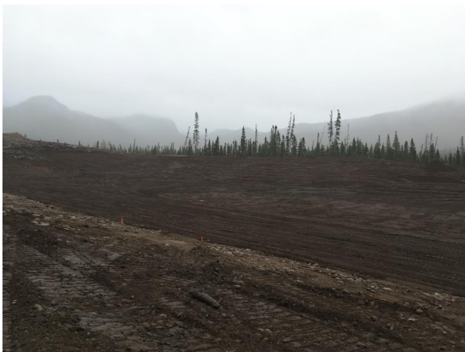
PHOTO 4 Masseku (26-09-2018) : Épandage de la T.V. au-delà de l'élévation 250 m autour du plan d'eau (zone 1)
