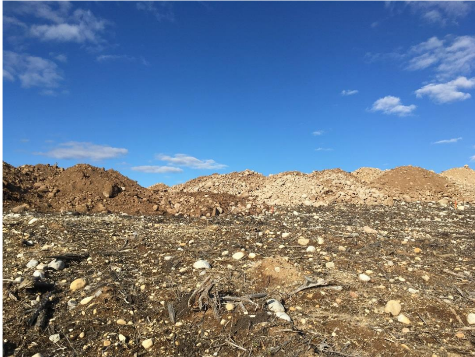
PHOTO 1 Masseku (18-09-2018) : Matériaux excédentaires placés à l'intérieur des limites du banc d'emprunt et à l'extérieur de la limite des travaux
