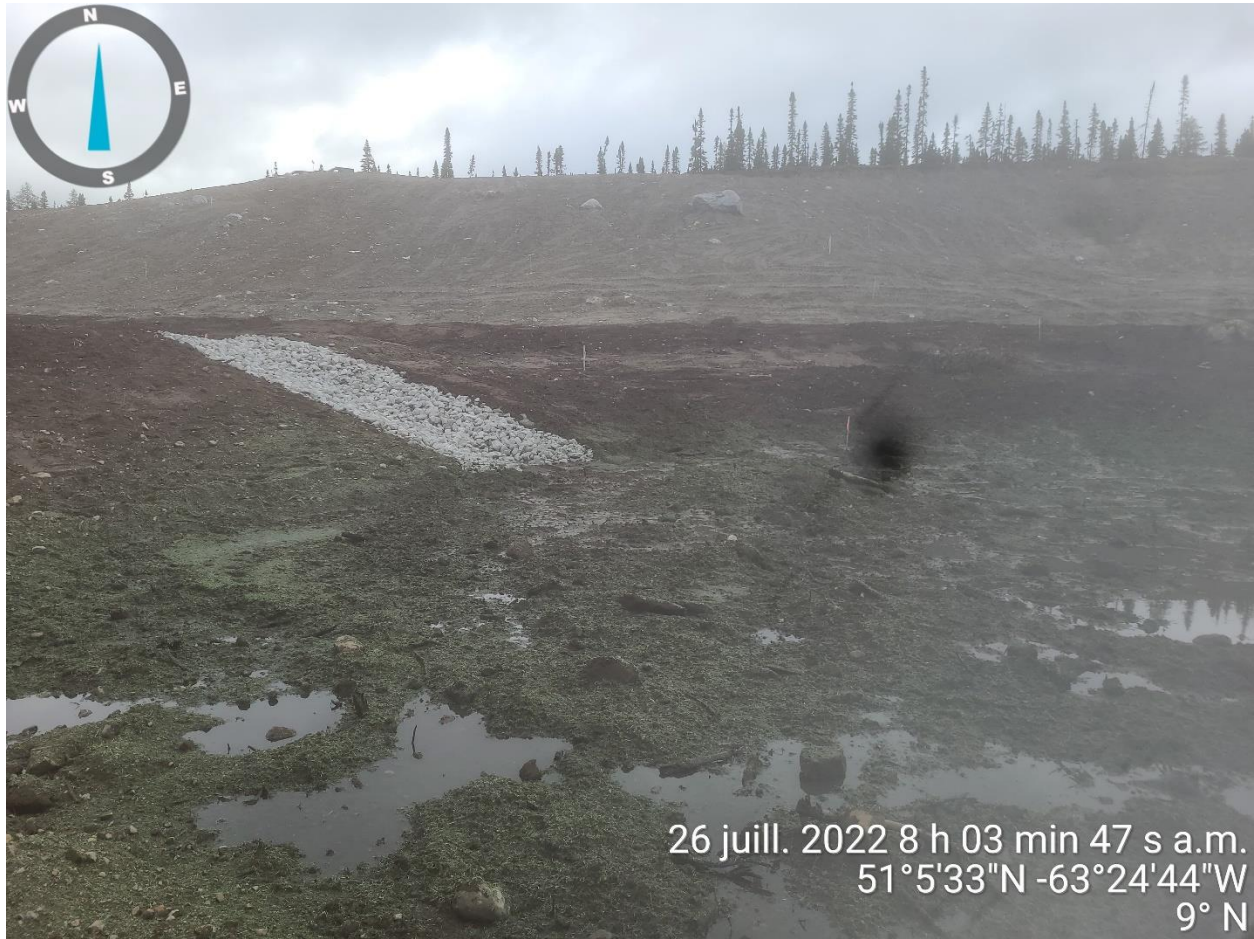
PHOTO 3 Étang du Till (26-07-2022) Déversoir en enrochement no 3 entre zone 2 et 3, fini à 100% avec plaque d'acier
