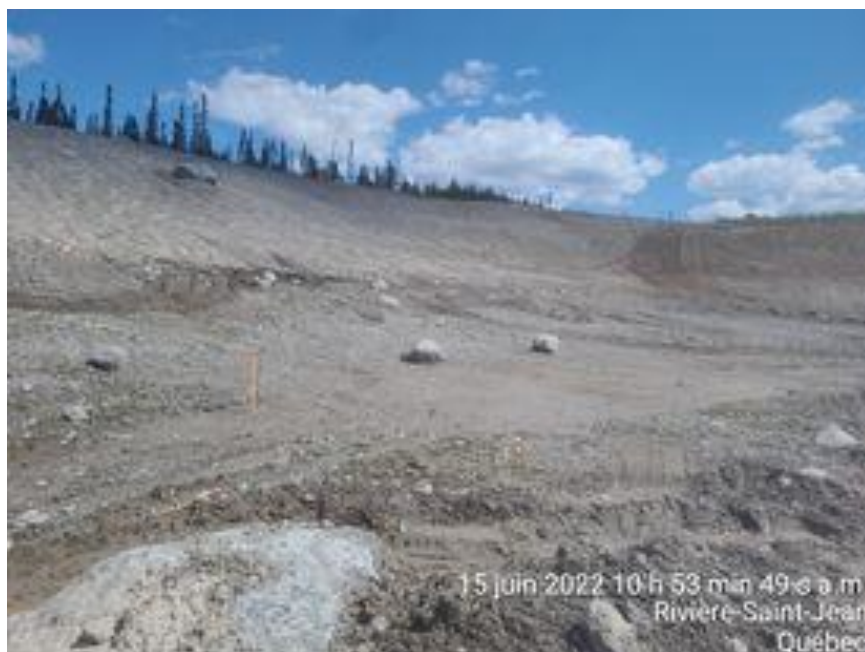
PHOTO 4 Étang du Till (15-06-2022) : plateau zone 3 trop humide. Futur drain qui devra être installé à cet emplacement pour drainer la zone
