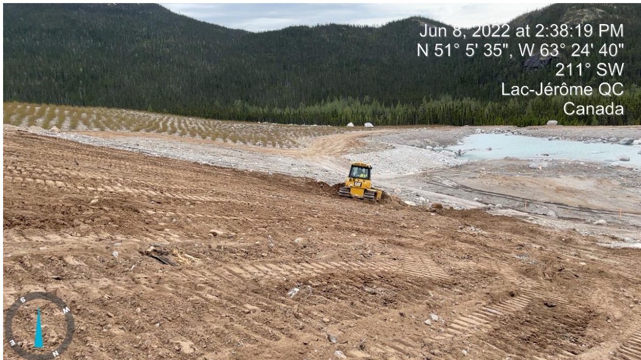
PHOTO 6 Till (08-06-2022): Reprofilage du talus Est.
