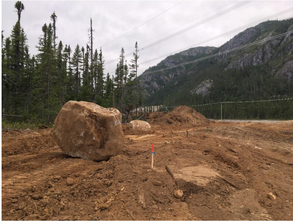
PHOTO 17 Mista (22-08-2018) : Mise de côté des blocs issus des excavations des plans d'eau. Ceux-ci pourront être réutilisés au travers les aménagements fauniques du site
