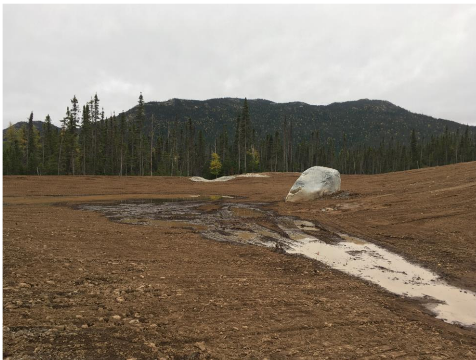
PHOTO 15 Masseku (03-10-2018) : Vue générale sud-est du site montrant l'épandage de la T.V. terminé sur les talus et les dépressions de la zone 2, incluant la zone de remblai avec le déversoir au centre de l'image
