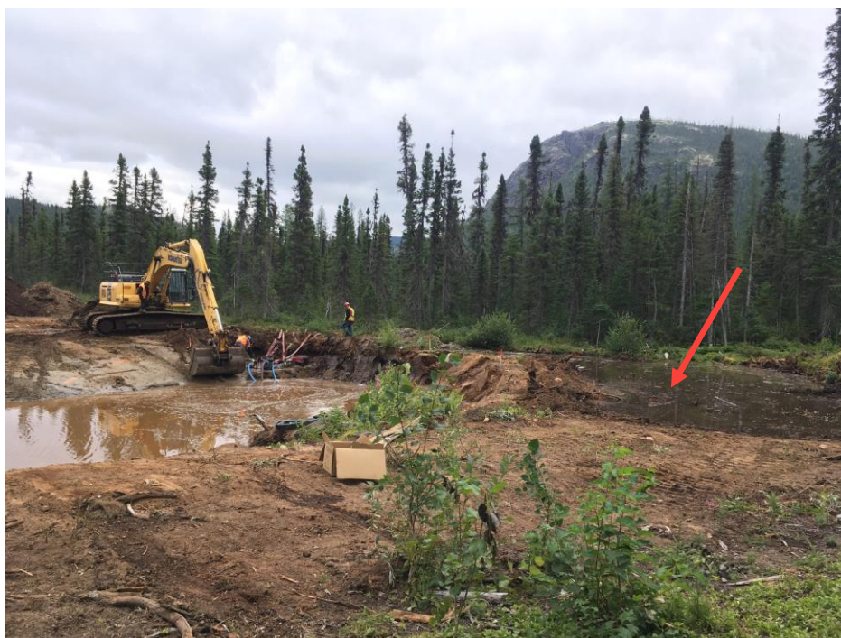
PHOTO 20 Mista (22-08-2018) : Déplacement des rejets des eaux de pompage en raison du retour d'eau dans l'excavation du plan d'eau sud
