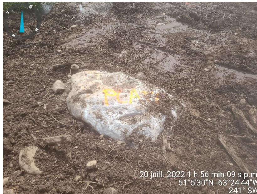
PHOTO 6 Étang du Till (20-07-2022) Roche plate de 1200 mm de diamètre par 700 de haut. Conforme selon les normes.
