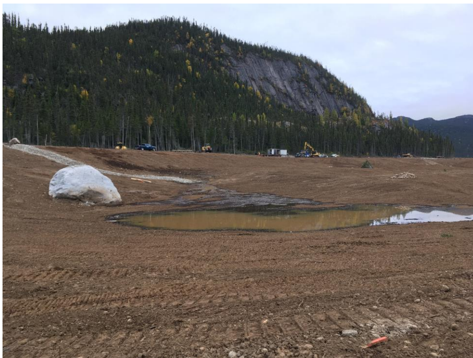
PHOTO 14 Masseku (03-10-2018) : Vue générale nord-ouest du site montrant l'épandage de la T.V. terminé sur les talus et des dépressions de la zone 2
