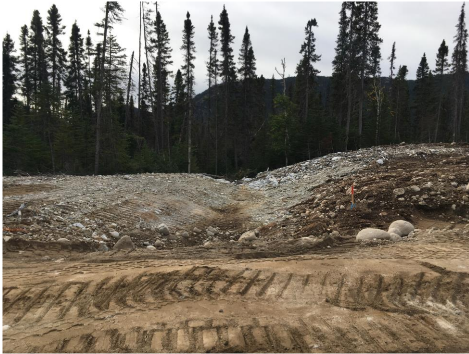
PHOTO 17 Masseku (19-09-2018) : Fossé de décharge en aval du déversoir (zone 2)
