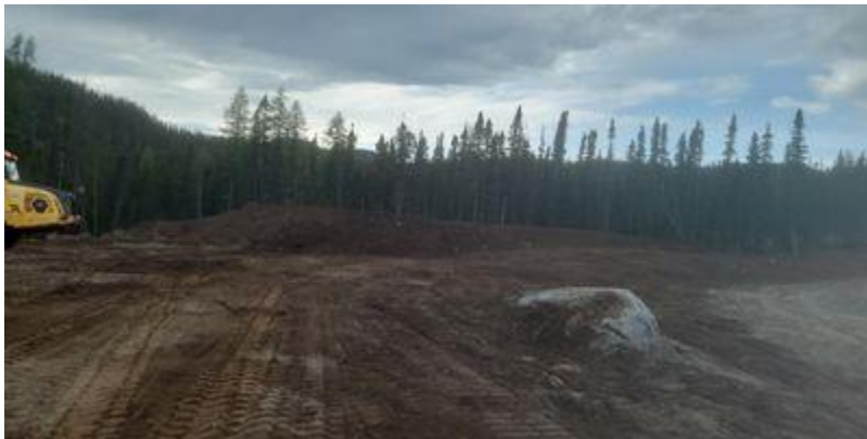
PHOTO 2 Till (14-06-2022) : Zone 4, nord-ouest. Terre végétale enlevé et début d'excavation pour les élévations
