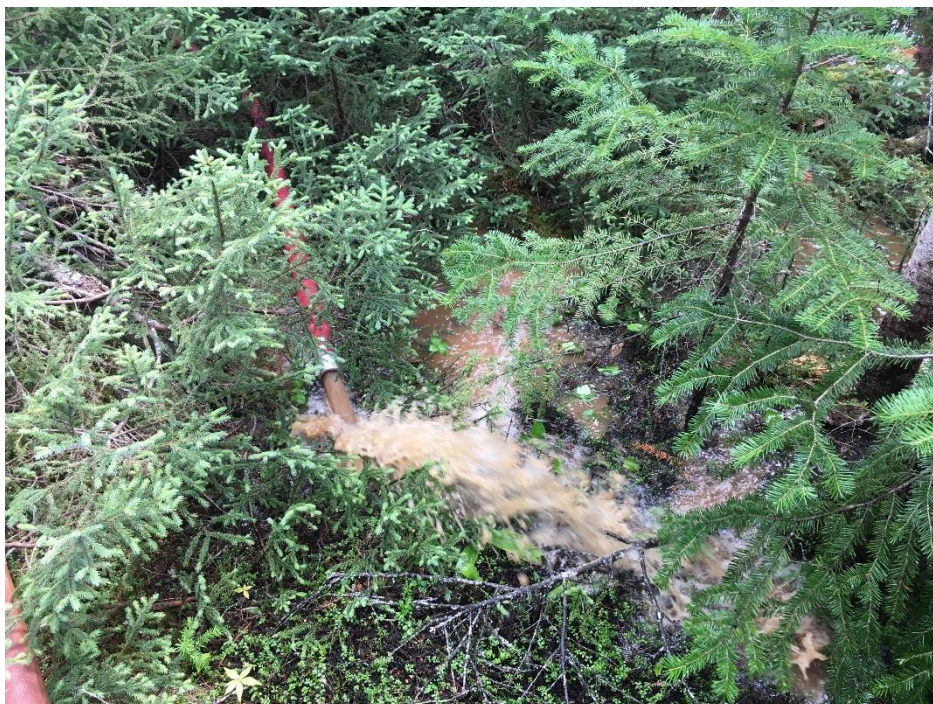
PHOTO 7 Mista (21-08-2018) : Rejet des eaux de pompage (assèchement des excavations) dans la litière forestière à plus de 20 m du ruisseau Mista (photo 8)
