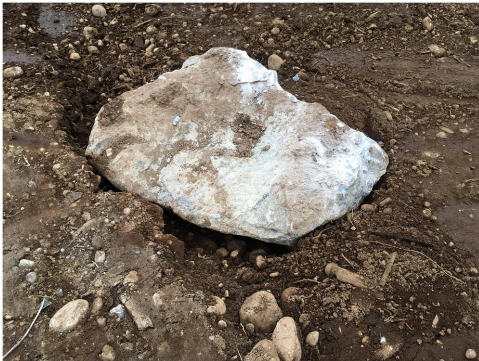
PHOTO 21 Masseku (03-10-2018) (aménagements fauniques) : Pierres naturelles enfouies au niveau du sol fini et ayant 700 à 1 200 mm de diamètre et environ 400 à 600 mm d'épaisseur
