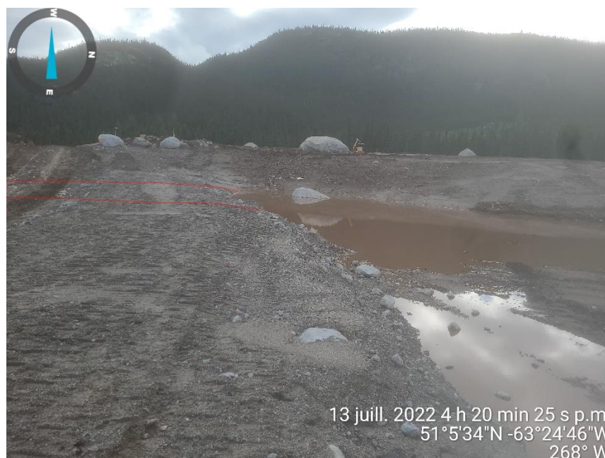
PHOTO 20 Till (13-07-2022): Emplacement d'un futur déversoir temporaire pour assécher la zone afin de continuer les travaux dans la zone 3 après les nombreux jours de pluie
