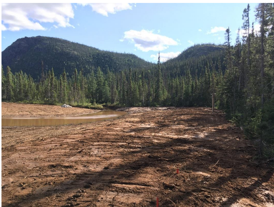
PHOTO 4 Mista (04-09-2018) : Épandage de la terre végétale à l'ouest du plan d'eau sud
