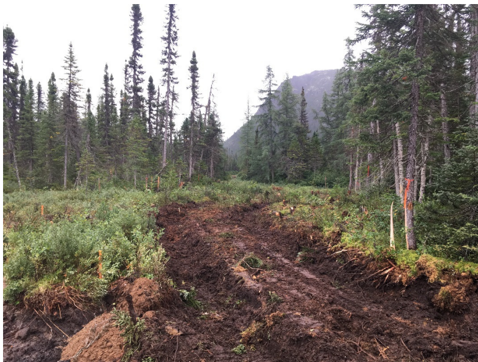
PHOTO 15 Mista (30-08-2018) : Circulation sur le centre ligne du canal sud pour le débardage du bois afin de préserver la végétation en rive
