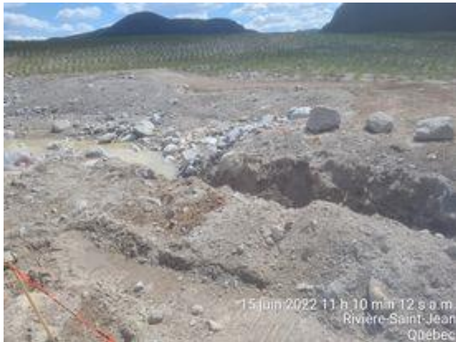
PHOTO 6 Étang du Till (15-06-2022): Canal effectué pour drainer la zone 1, Sud-Ouest
