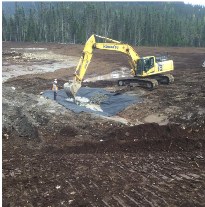
PHOTO 2 Maseku (29-09-2018) : Aménagement du canal empierré et de la fosse d'affouillement entre les zones humides 2 et 4 (enrochement, membrane de type II) (vue aval ou est vers la zone 2)
