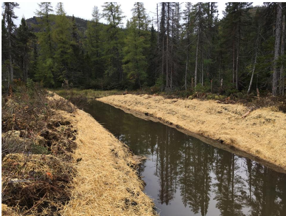
PHOTO 26 Mista (03-10-2018) : Matelas de contrôle de l'érosion posé sur les talus du canal sud vers la fin septembre
