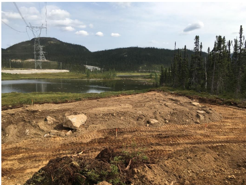
PHOTO 11 Mista (21-08-2018) : Mise et forme et profilage du dépôt de matériel provenant de l'excavation des plans d'eau à l'est du site en cours
