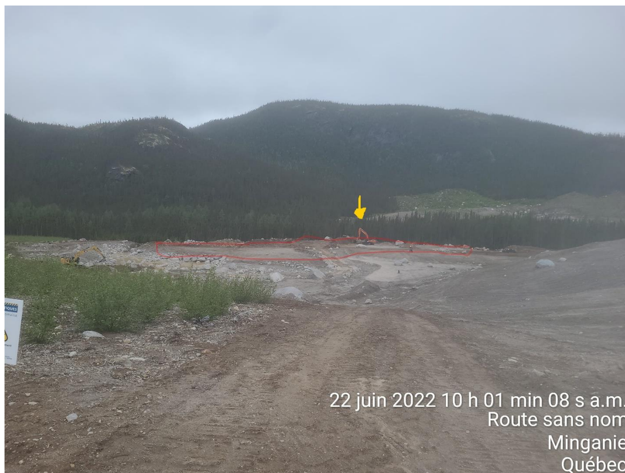
PHOTO 2 Étang du Till (22-06-2022) : Zone 4, travaux de remblais vers l'arrière de la zone 4 pour avoir les élévations requises, Photo prise vers l'ouest. Zone 4 délimitée en rouge, flèche jaune pointant la machinerie exécutant les travaux en cours.
