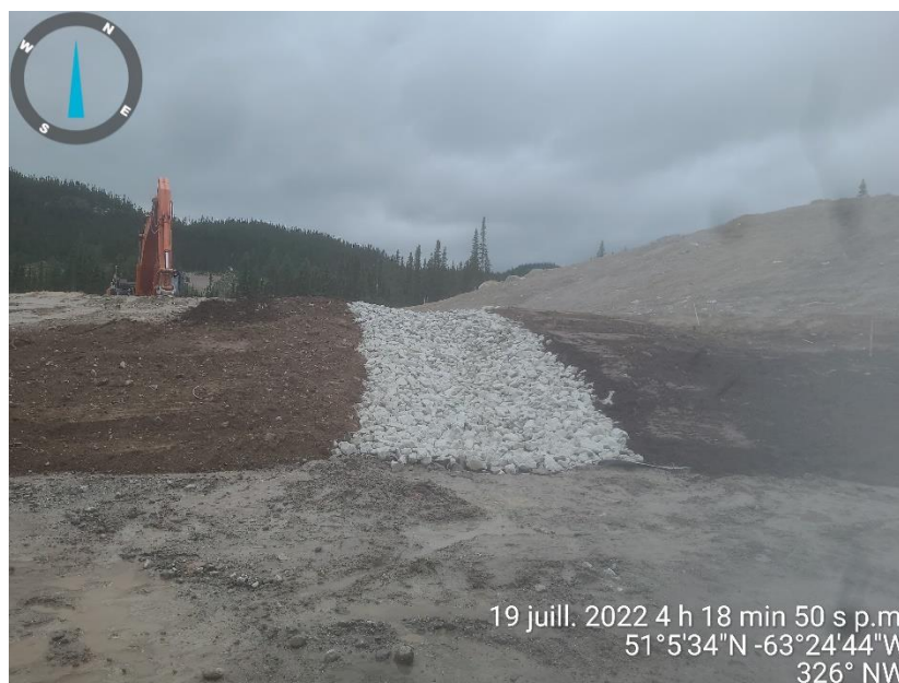
PHOTO 4 Étang du Till (20-07-2022) Déversoir #2 en enrochement coupe D entre zone 2 et 1, respectant les normes du devis. Avec plaque d'acier.
