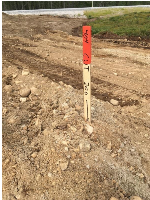
PHOTO 14 Mista (21-08-2018) : Arpentage pour le respect des élévations fourni par l'entrepreneur et validé par Hydro-Québec
