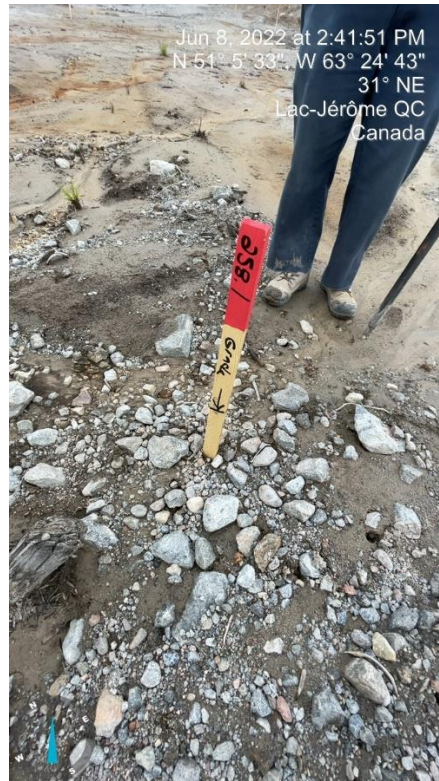
PHOTO 17 Till (08-06-2022) : Arpentage pour le respect des élévations fourni par l'entrepreneur et validé par Hydro-Québec
