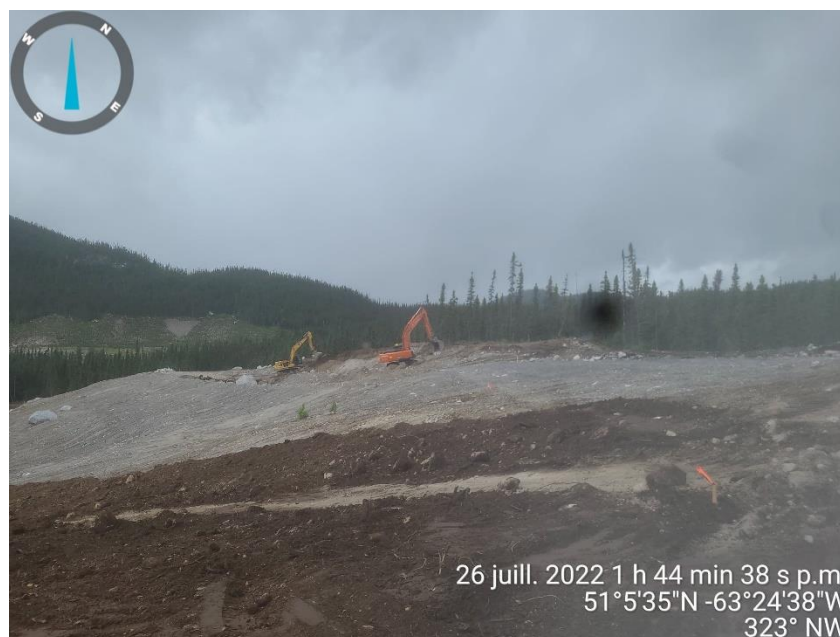
PHOTO 25 Étang du Till (26-07-2022) Excavation sur l'ancien chemin d'accès afin d'avoir le bon nivelage selon les plans, Talus Nord
