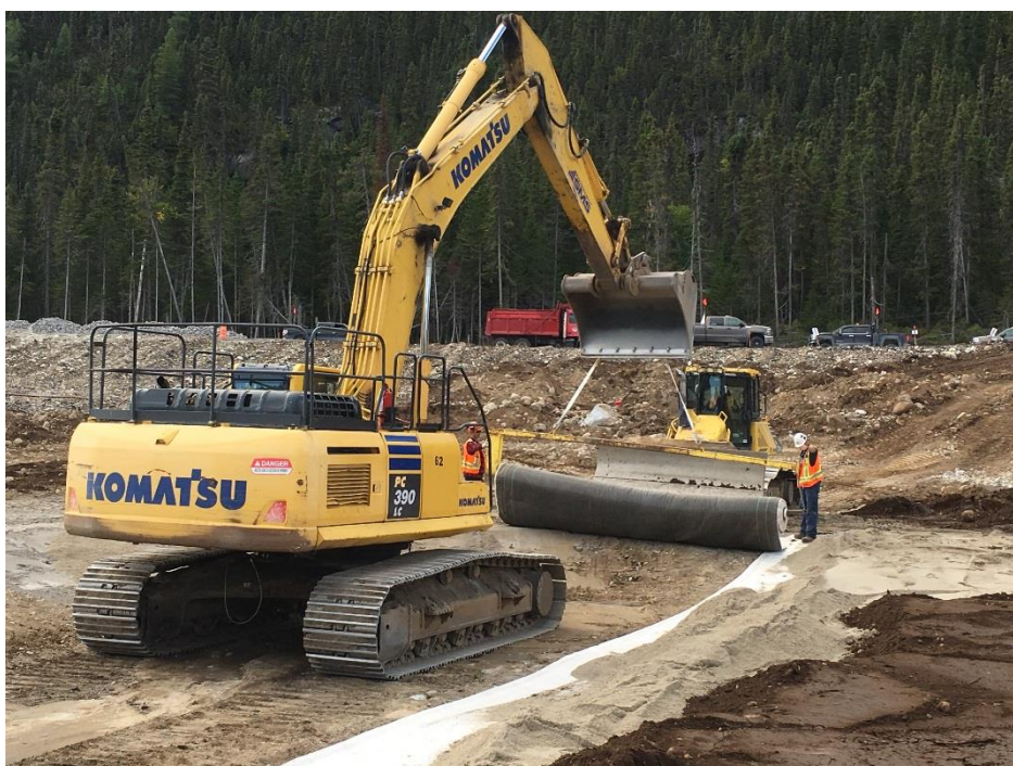
PHOTO 12 Masseku (19-09-2018) : Le géocomposite bentonitique pour imperméabiliser le fond de la zone d'eau 1 est déroulé et mis en place de façon à assurer un contact continu avec l'infra sans tension ni effort ou pli; l'alignement des rouleaux permet un chevauchement minimal de 150 mm longitudinal et 300 mm transversal (bout à bout)
