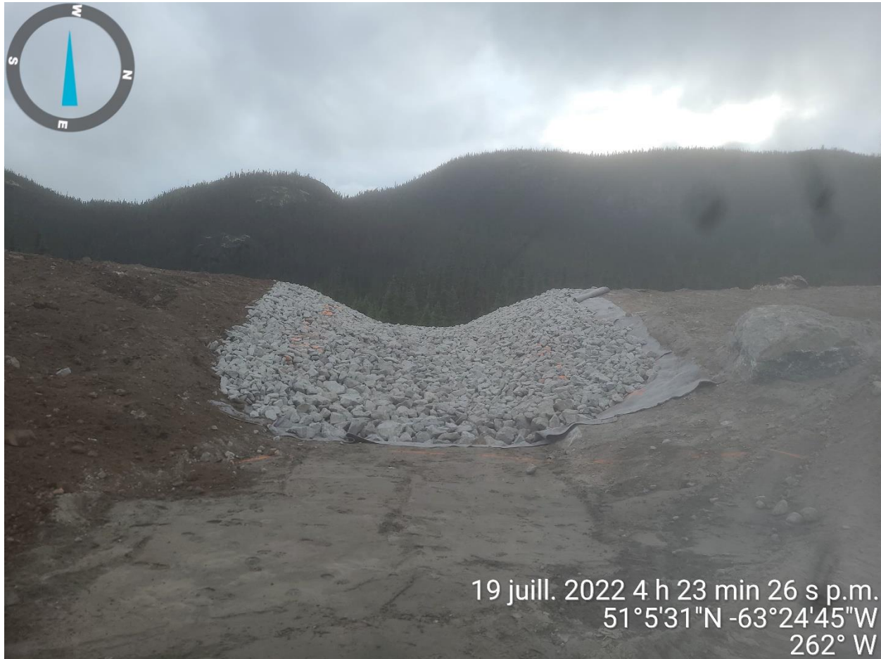
PHOTO 1 Étang du Till (26-07-2022) : Déversoir en enrochement no 1, fini à 100% avec plaque d'acier
