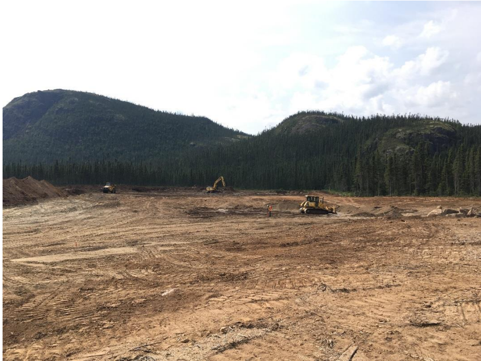
PHOTO 1 Mista (21-08-2018) : Excavation et profilage des plans d'eau peu profonde nord et sud en cours
