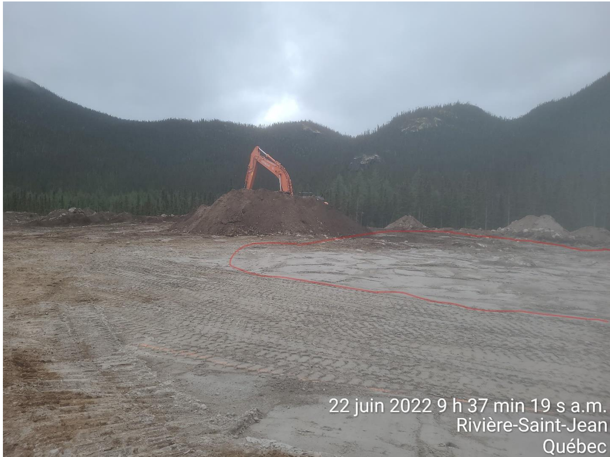
PHOTO 5 Étang du Till (22-06-2022) Observation du compactage fini de la prairie humide dans la zone 4 (délimité en rouge).
