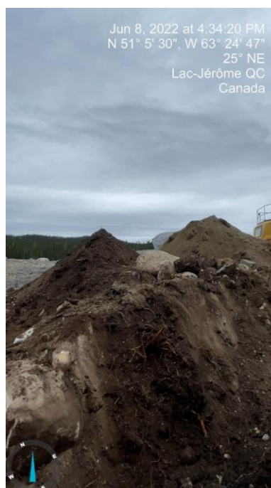
PHOTO 8 Till (08-06-2022) : Mise en réserve de terre végétale (à proximité du déversoir de la zone 1) provenant de la surexcavation du déversoir
