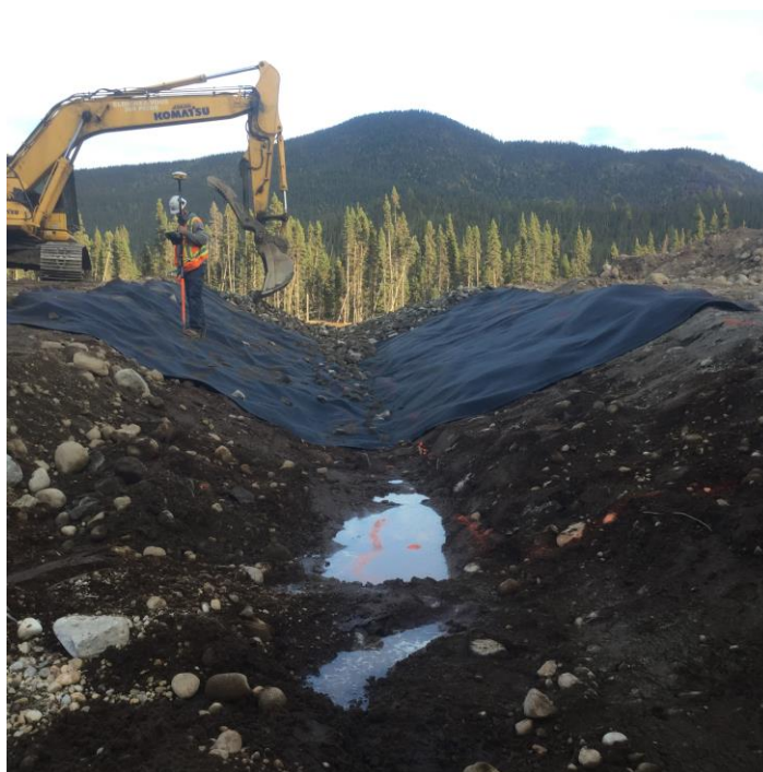
PHOTO 4 Masseku (29-09-2018) : Enlèvement du ponceau temporaire endommagé et aménagement du canal empierré en travers du chemin d'accès RO3-5A-Sud, entre les zones humides 2 et 4 (enrochement, membrane de type II)
