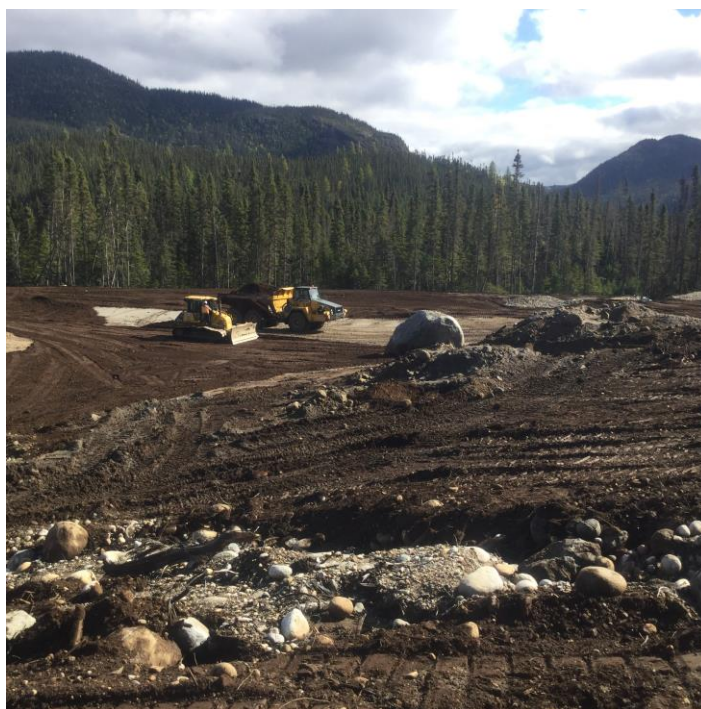
PHOTO 10 Masseku (29-09-2018) : Mise en forme du mort-terrain et épandage de la T.V. autour et au niveau de la zone humide 2
