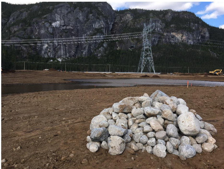
PHOTO 15 Mista (04-09-2018) : Amas de pierres d'une hauteur minimale de 0,5 m et un diamètre minimal de 2 m
