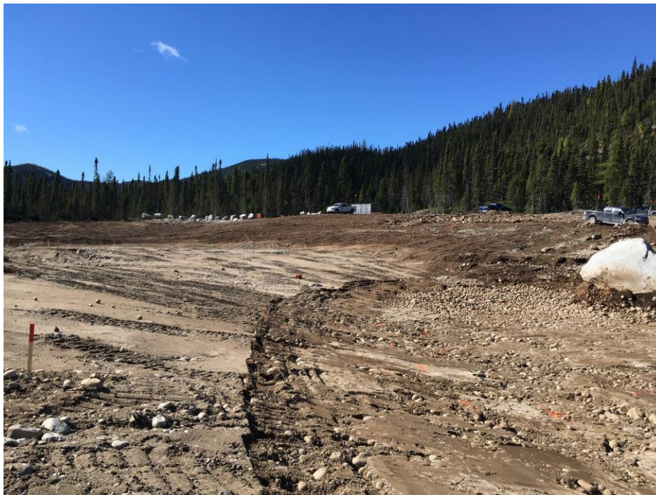
PHOTO 9 Masseku (27-09-2018) : Préparation de l'infra pour la mise en place du till dans le marais (jusqu'à l'élévation 248,5 m) de la zone 2 (en amont de la zone de remblai ou digue)
