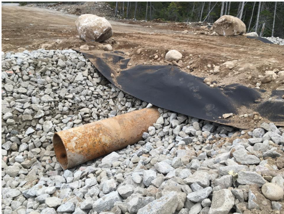
PHOTO 5 Masseku (03-10-2018) : Construction d'un nouveau ponceau temporaire et facilement rétractable par-dessus le fond conformément aménagé du canal empierré en travers du chemin d'accès RO3-5A-Sud, entre les zones humides 2 et 4
