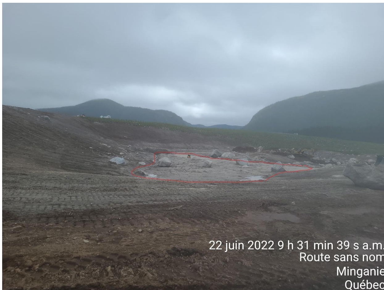
PHOTO 4 Étang du Till (22-06-2022) : 100% de l'excavation et du compactage effectué dans la zone 3. Prêt pour l'épandage de la terre végétale. Photo prise vers l'est. Zone 3 délimitée en rouge
