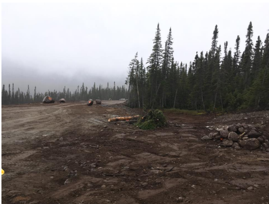
PHOTO 24 Masseku (04-10-2018) : Nivelage de la surface autour du marécage de la zone humide 4 qui comporte beaucoup d'inégalités et de roches (photo 24)
