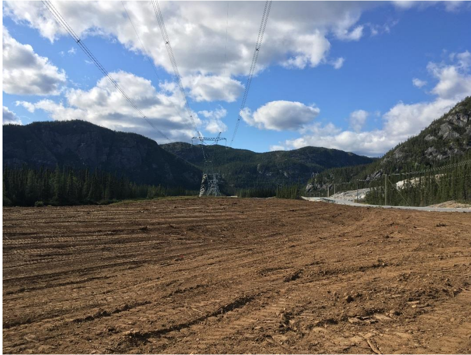
PHOTO 9 Mista (04-09-2018) : Épandage de la terre végétale dans le secteur nord-ouest
