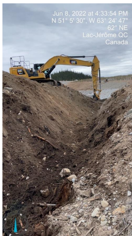
PHOTO 7 Till (08-06-2022) : Surexcavation du déversoir de la zone 1
