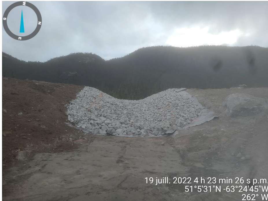
PHOTO 1 Étang du Till (20-07-2022) : Déversoir #1 en enrochement - coupe B, fini à 100% avec plaque d'acier
