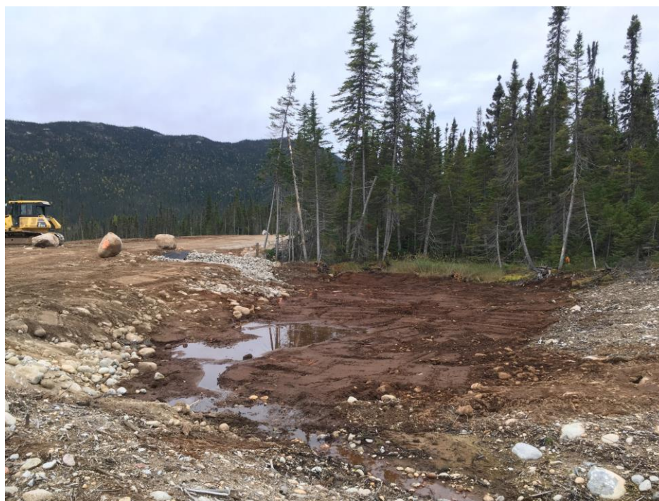
PHOTO 12 Masseku (03-10-2018) : Mise en forme du mort-terrain et épandage de la T.V. au niveau du marais de la zone 4
