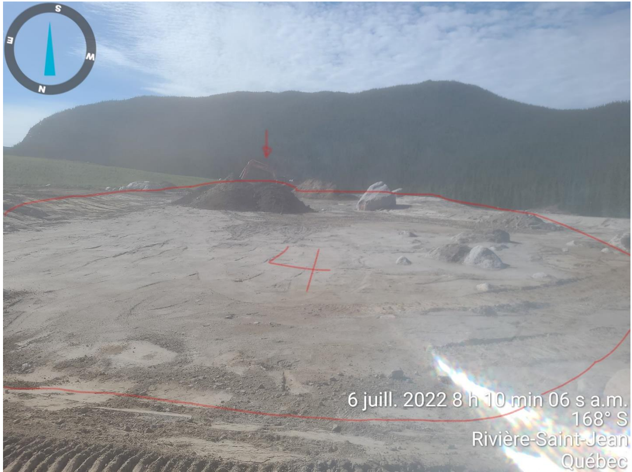
PHOTO 3 Étang du Till (07-06-2022) : Zone 4, excavation et décapage de la zone 4 complétées à 100% avant terre végétale. Finition de la digue indiquée par la flèche sur la pelle mécanique.
