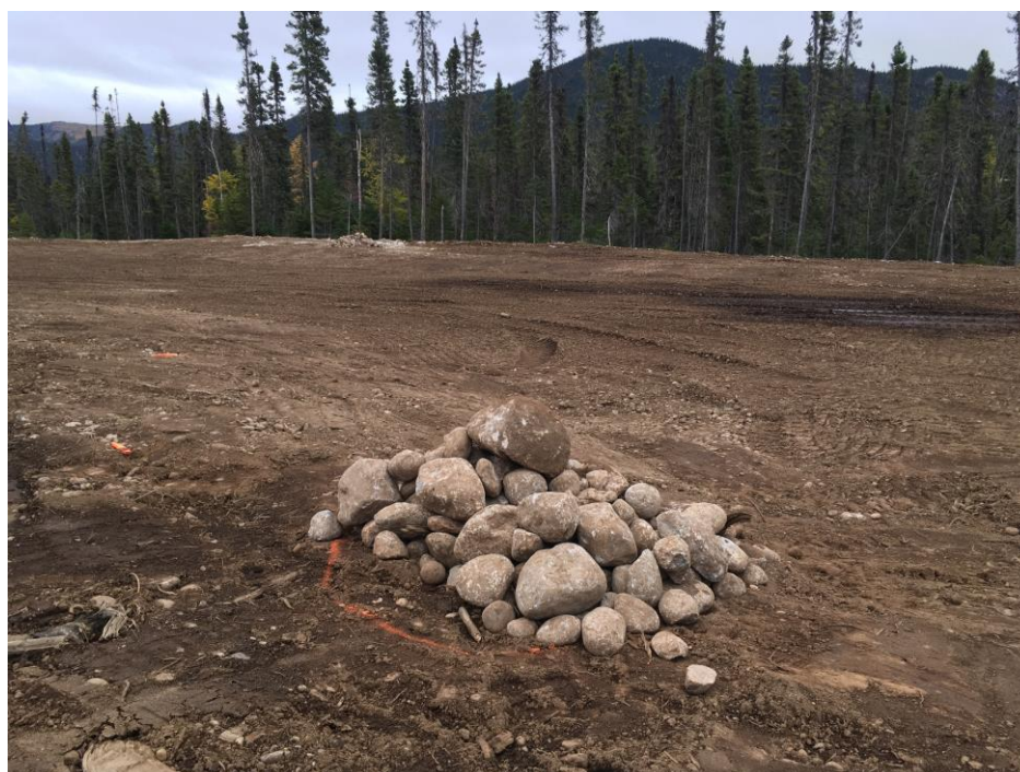
PHOTO 20 Maseku (03-10-2018) (aménagements fauniques) : Amas constitués de pierres de diamètre variable de l'ordre de 200 à 400 mm pour la majorité d'entre elles avec une hauteur min. de 0,5 m et un diamètre min. de 2 m
