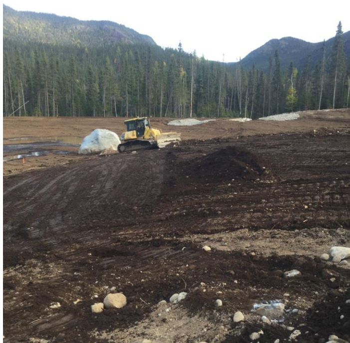
PHOTO 11 Masseku (29-09-2018) : Mise en forme du mort-terrain et épandage de la T.V. autour et au niveau de la zone humide 2
