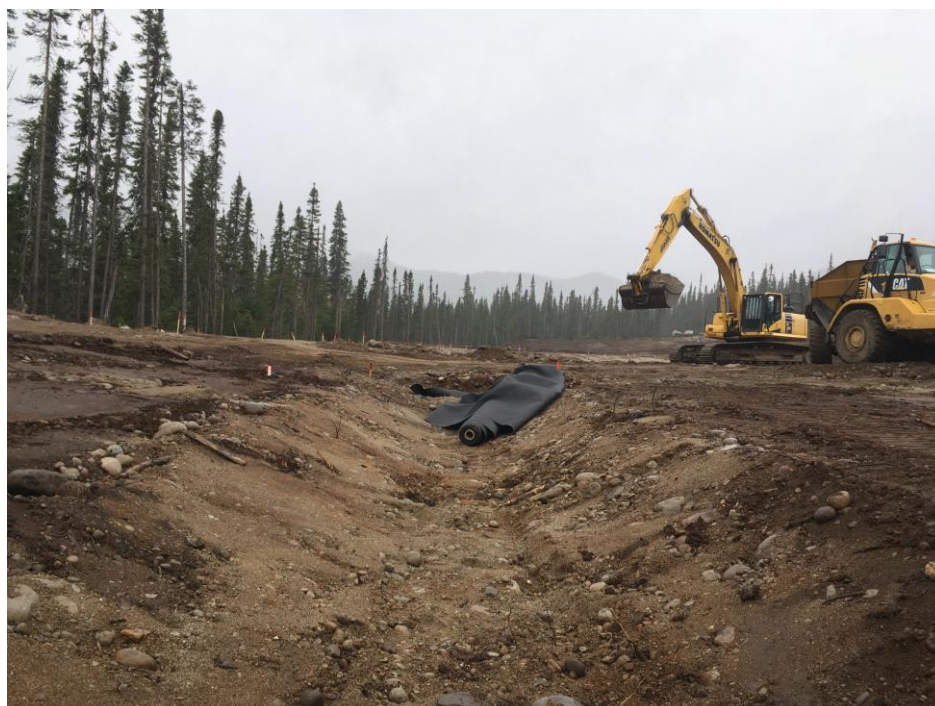
PHOTO 7 Masseku (26-09-2018) : Pose de la membrane type II dans les canaux en enrochement
