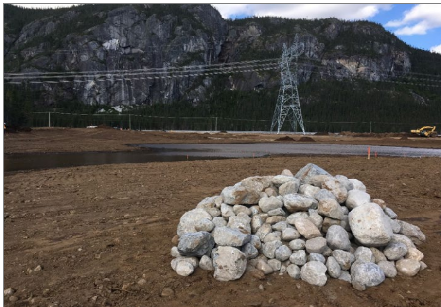
Photo 16 Étang du Mista (04-09-2018) – Amas de pierres d'une hauteur minimale de 0,5 m et un diamètre minimal de 2 m
