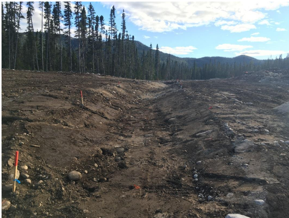
PHOTO 2 Masseku (18-09-2018) : Aménagement du canal de débordement entre les zones 1 et 2
