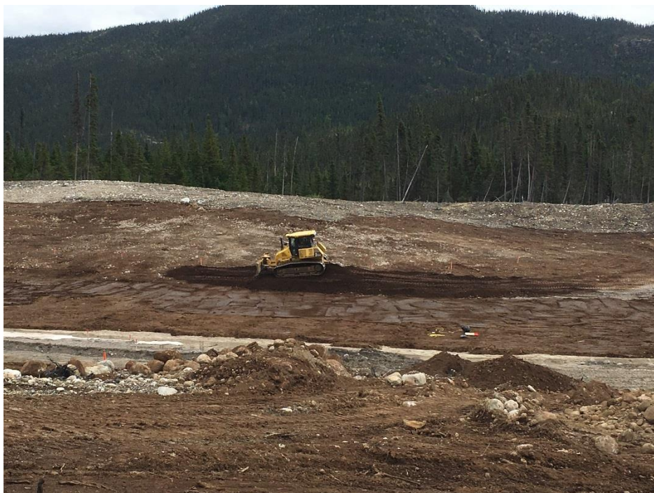
PHOTO 3 Masseku (20-09-2018) : Épandage de la T.V. jusqu'à 250 m autour du plan d'eau (zone 1)
