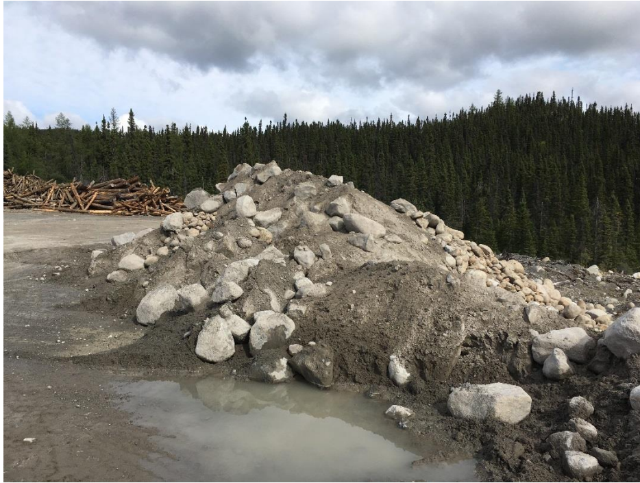
PHOTO 9 Masseku (19-09-2018) : Les blocs non conformes aux exigences du chapitre « Construction des remblais » ont été enlevés du till lors de l'exploitation de la pile de réserve au dépôt RO3-5C-Est
