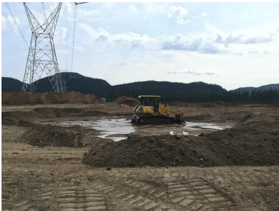
PHOTO 3 Mista (21-08-2018) : Excavation et profilage du plan d'eau peu profonde nord en cours
