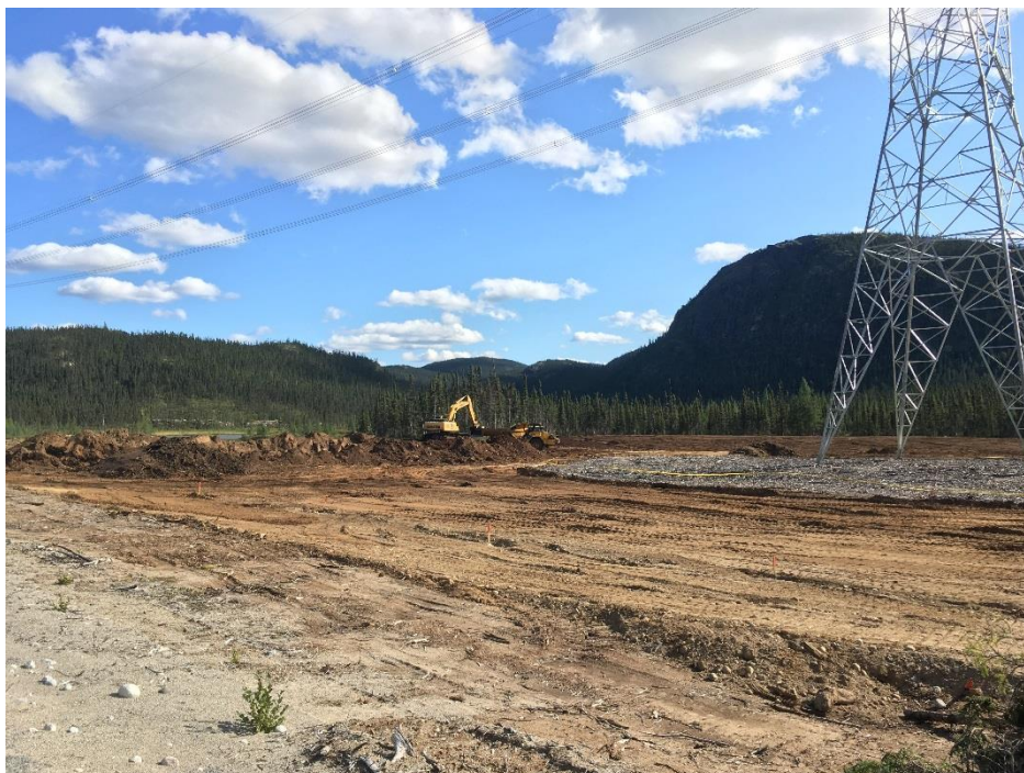
PHOTO 7 Mista (04-09-2018) : Aucune excavation ni aucuns autres travaux n'ont été réalisés dans un rayon de 30 m autour du pylône ni entravé l'accès de 24 m à celui-ci
