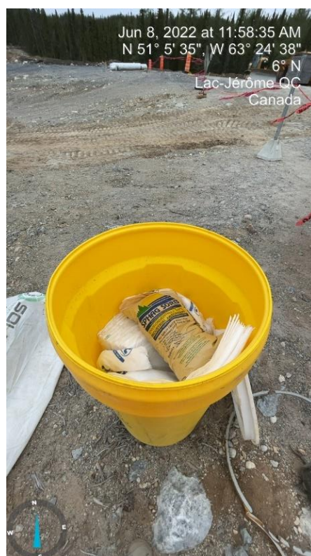
PHOTO 16 Till (08-06-2022) : Présence sur les lieux d'une trousse de récupération des hydrocarbures en cas de déversement.
