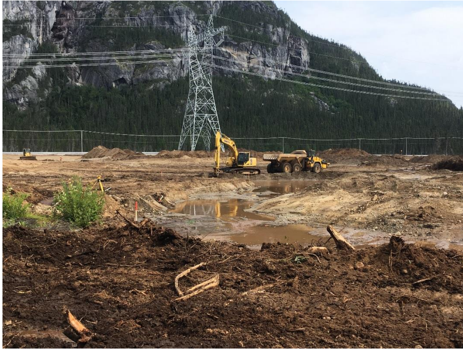
PHOTO 9 Mista (21-08-2018) : Excavation et profilage du plan d'eau peu profonde sud en cours
