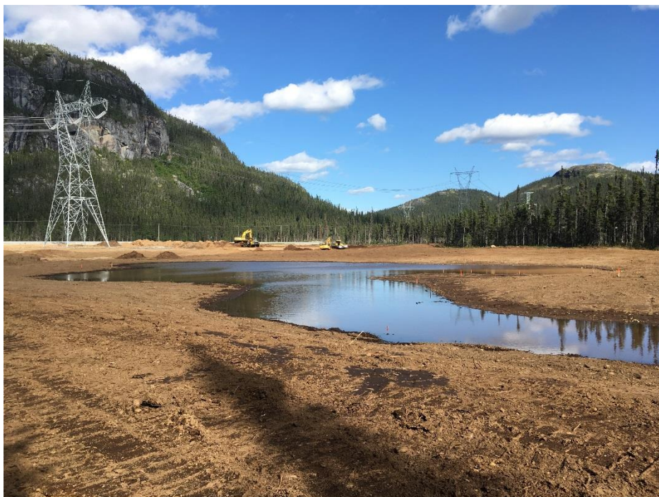
PHOTO 3 Mista (04-09-2018) : Épandage de la terre végétale autour du plan d'eau sud
