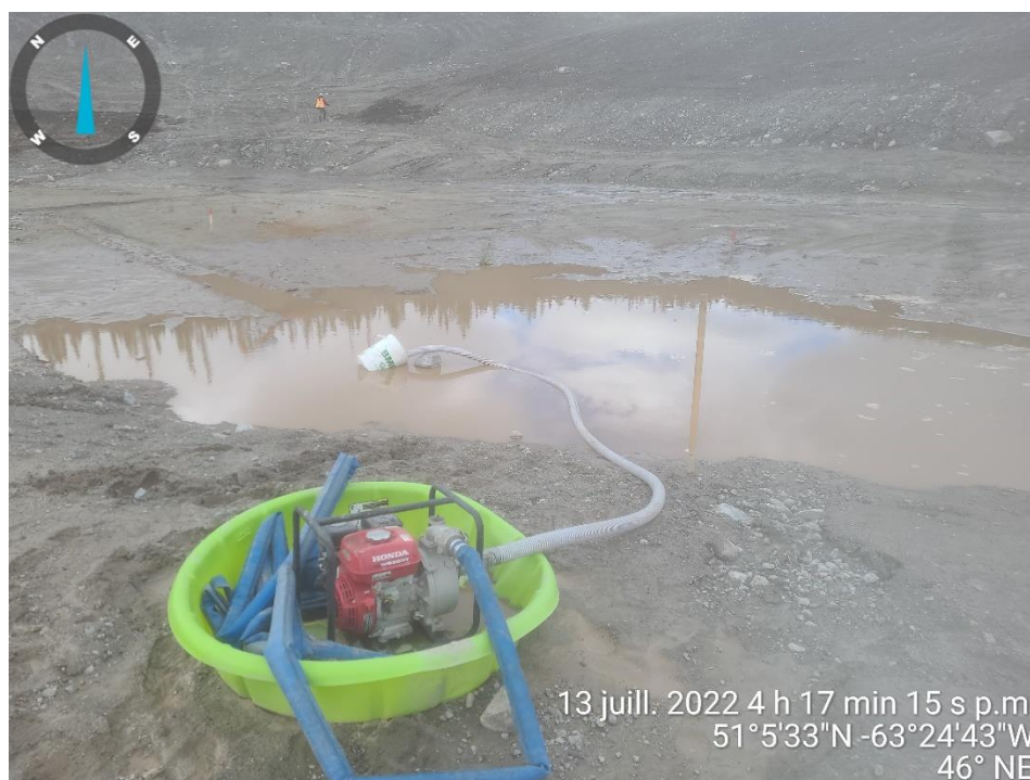
PHOTO 19 Till (13-07-2022): Pompe installée pour assécher temporairement la zone 2 afin de continuer les travaux après la pluie
