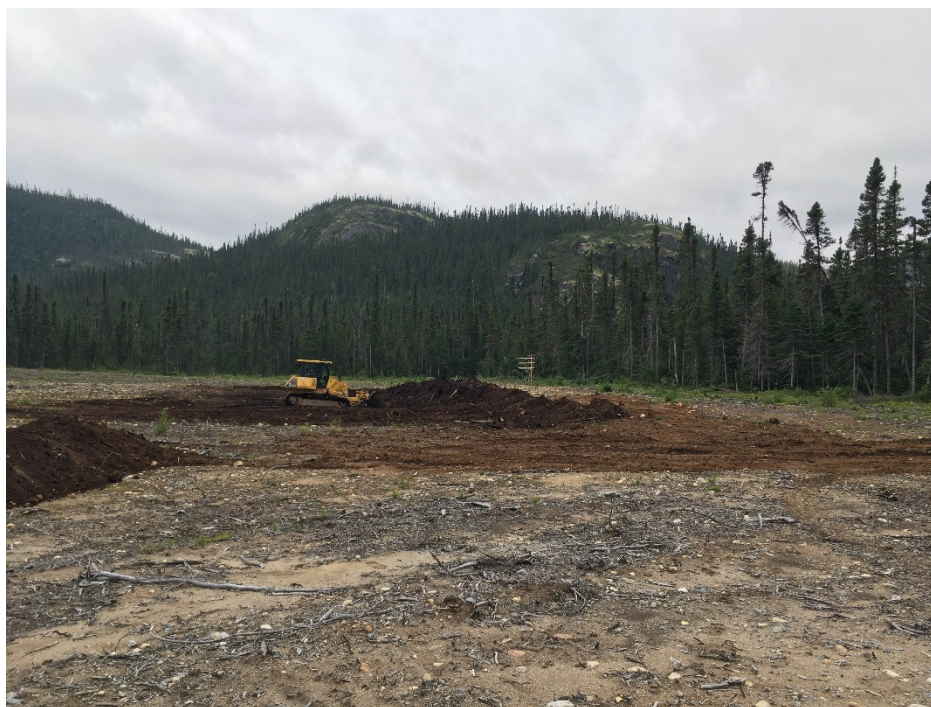
PHOTO 4 Mista : Début du décapage et de la mise en réserve de la terre végétale
