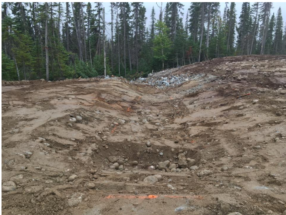
PHOTO 3 Masseku (26-09-2018) : Aménagement du parafouille au-dessous du déversoir de la zone de remblai (digue) (zone 2)
