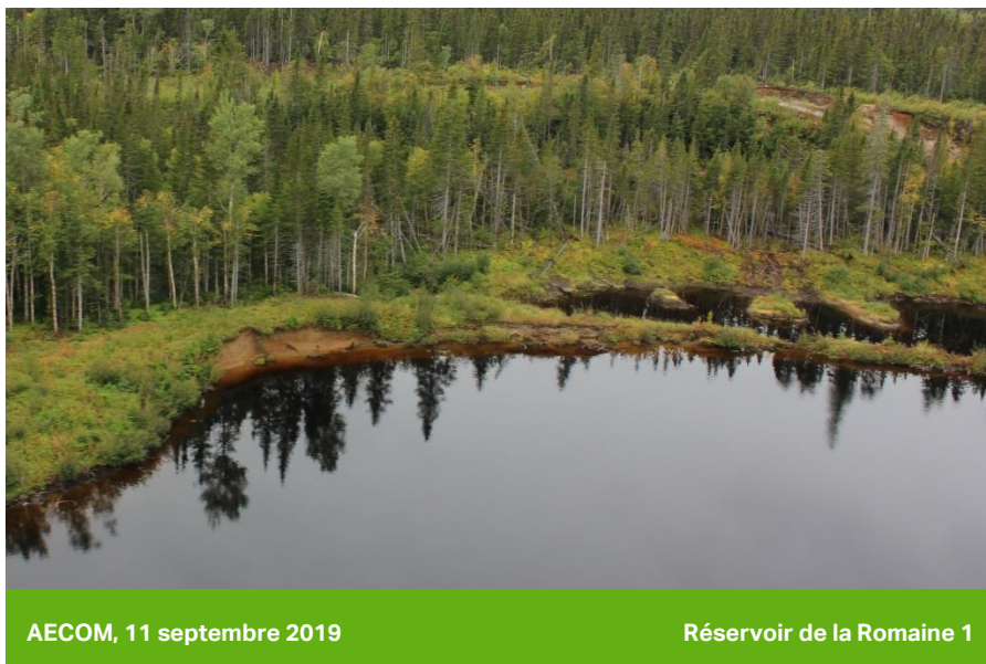
Photo 41 Nouveau talus susceptible d'érosion localisé sur la rive ouest du réservoir de la Romaine 1 (PK 62,4)
