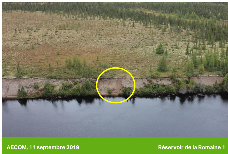
Photo 14 Talus susceptible d'érosion et où on note un petit décrochement
