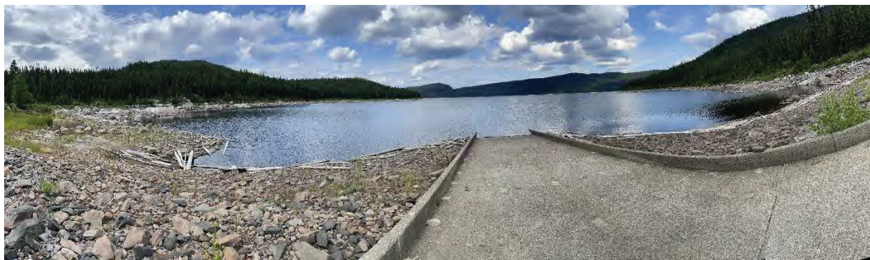
Photo 11-3 Rampe de mise à l'eau au PK 96 sur le réservoir de la Sainte-Marguerite 3
