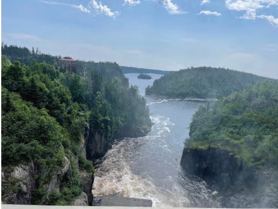
Photo 18-7 Rivière Sainte-Marguerite en aval de la centrale de la Sainte-Marguerite-2
