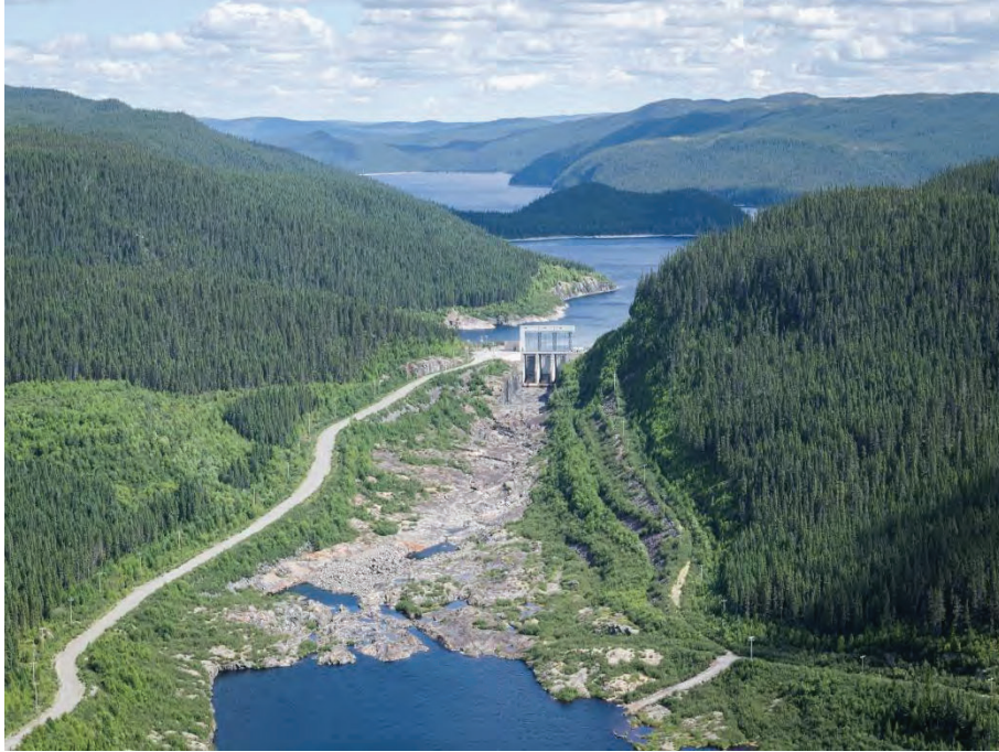
Photo 18-1 Réservoir de la Sainte-Marguerite 3 en amont de l'évacuateur
