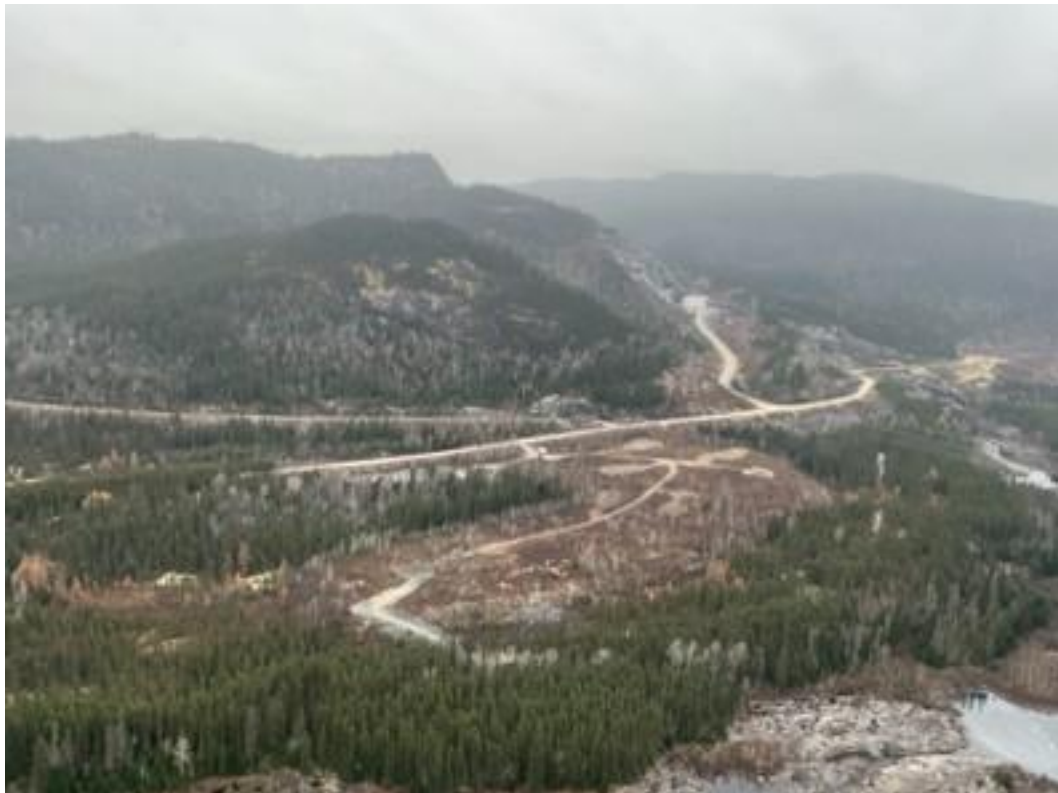
Photo 7-2 : Aire d'aménagement du campement de travailleurs et travailleuses
