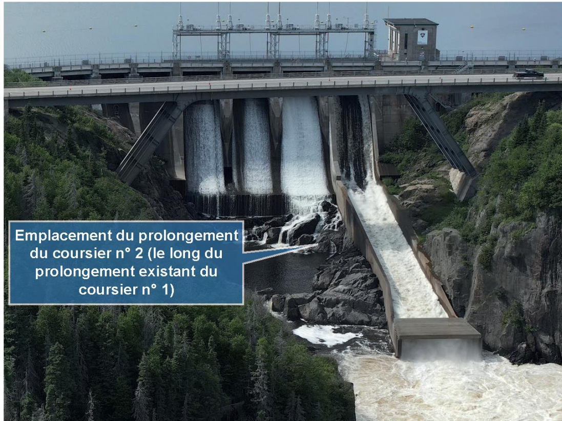
Figure 7-10 : Vue vers l'amont du coursier n° 1 (prolongé) de l'évacuateur de crues de la Sainte-Marguerite-2
