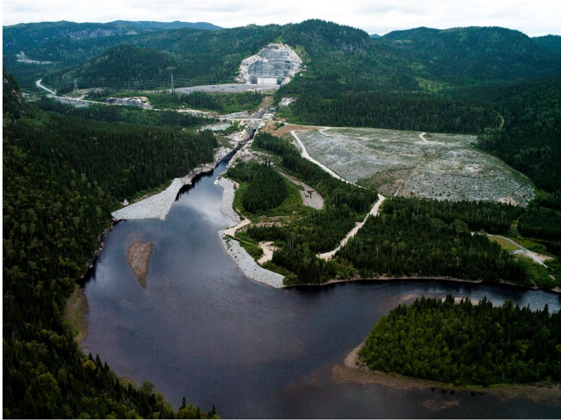
Photo 7-3 : Aire d'aménagement des installations temporaires de chantier (près du canal de fuite de la centrale)
