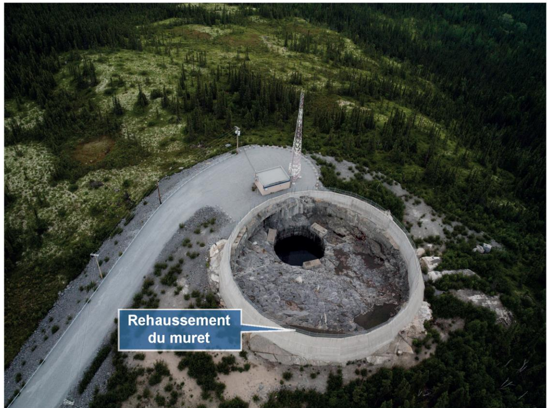
Figure 7-6 : Travaux éventuellement requis à la cheminée d'équilibre
