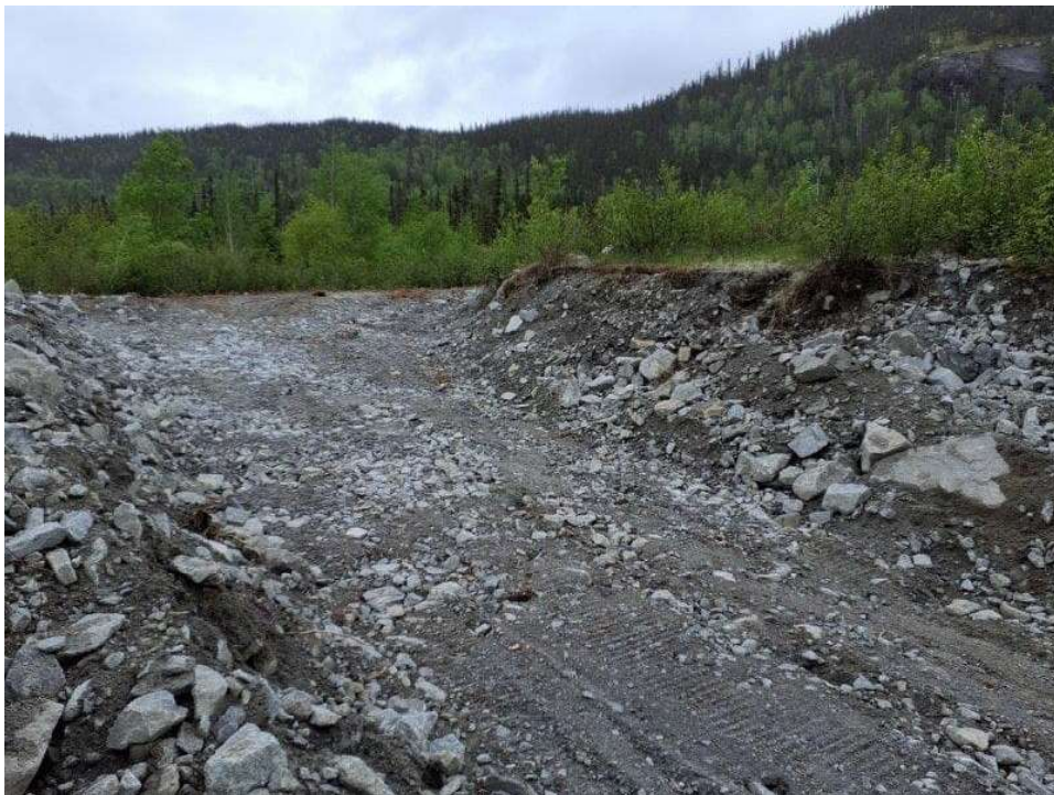
Photo 14 Descente du chemin central réaménagé
