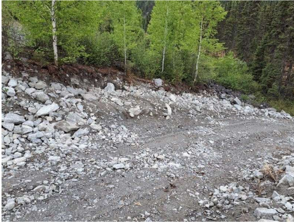
Photo 15 Descente du chemin central réaménagé
