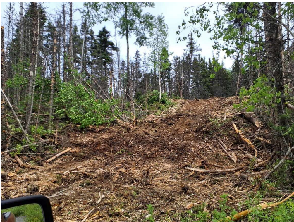
Photo 12 Chemin de pénétration pour des activités de déboisement – Vue vers l'est.
