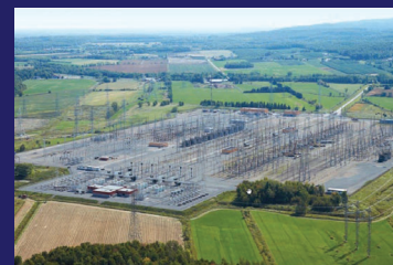
Poste Chénier à 735-315 kV, à Mirabel
