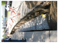
Étape 3 – Remblayage et remise en état des surfaces
