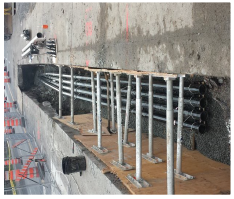
Étape 2 – Installation des conduits, coffrage et bétonnage
