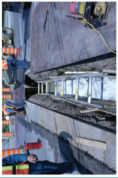
Étape 2 – Installation des conduits, coffrage et bétonnage
