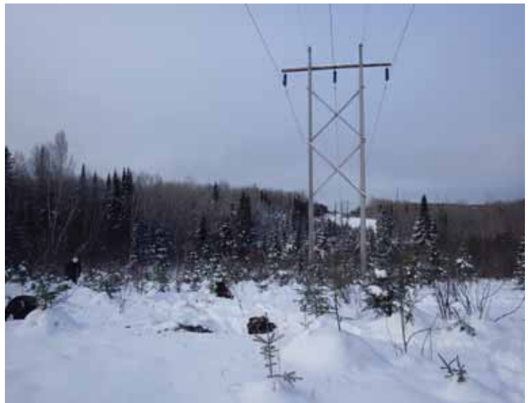
Photo 4.4 Vue générale de la zone 08.3.24.013 vers l'ouest Archéotec 2019, LAI19_CC1_007
