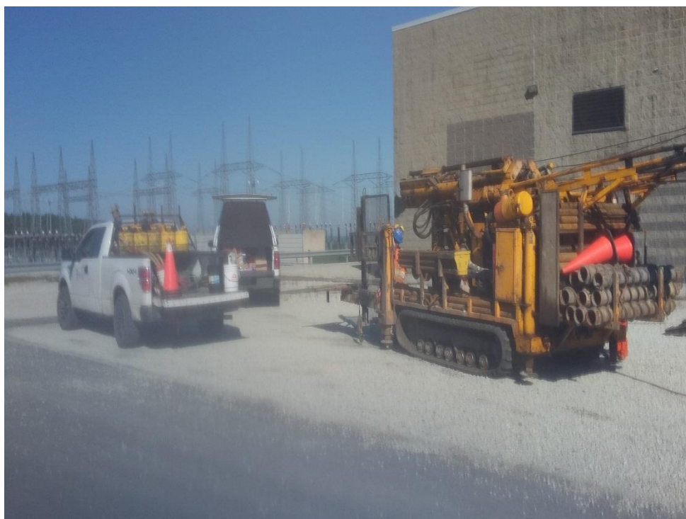
Photo 3 – Réalisation du forage F-26-18.
