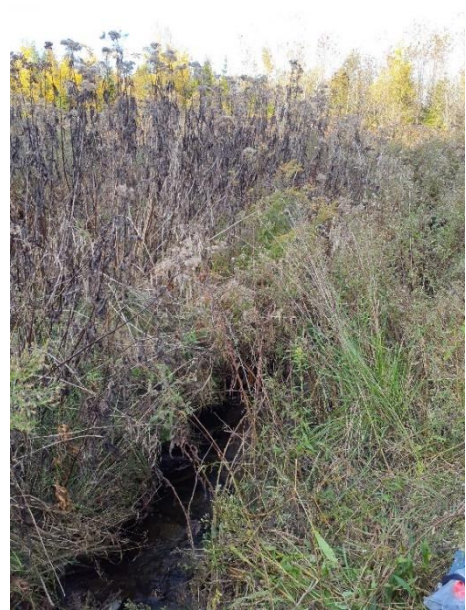
Vue vers l'aval
