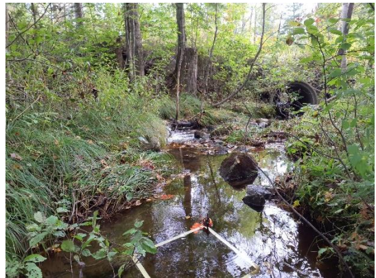
Vue vers l'aval
