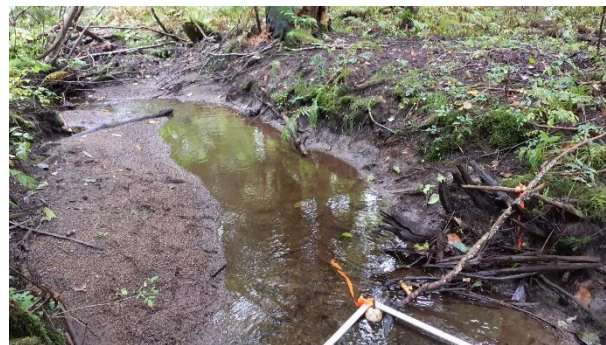
Vue vers l'aval
