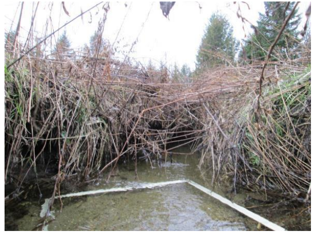
Vue vers l'aval
