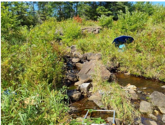
Vue vers l'amont
