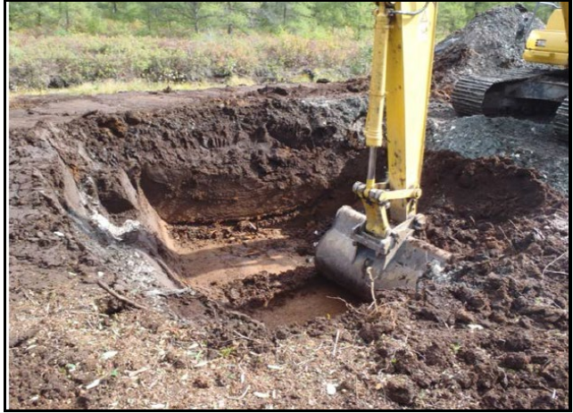
Photo 2 : Excavation d'un trou dans la tourbe
