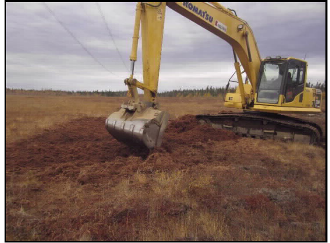
Photo 2 : Mise en place du tapis végétal récolté sur la zone à restaurer
