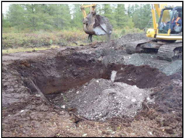
Photo 4 : Remise du matériel granulaire dans le fond de l'excavation
