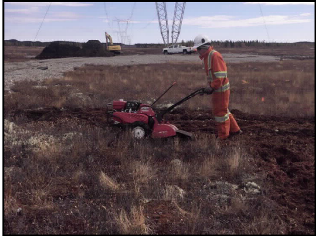
Photo 1 : Prélèvement et déchiquetage du tapis végétal au site donneur d'une tourbière située à proximité de la zone à restaurer
