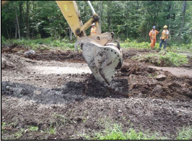
Photo 1 : Enlèvement du matériel granulaire en surface
