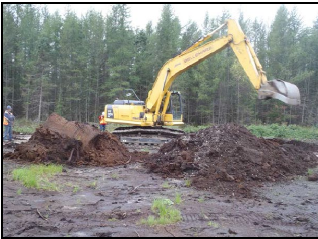
Photo 3 : Empilement de tourbe à gauche et empilement de matériel granulaire à droite
