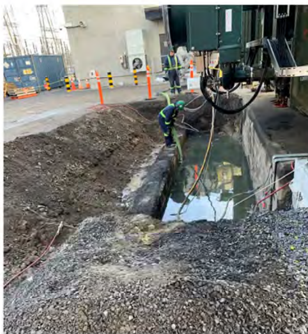
Photographie 5 Pompage de l'eau – Excavation 1
