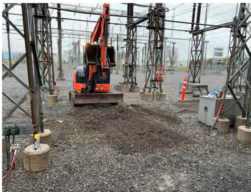
Photographie 2 Excavation Tranchée exploratoire TR-2
