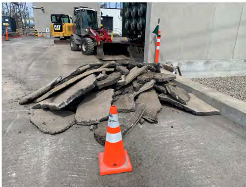
Photographie 7 Empilement de l'asphalte retirée – Excavation 1
