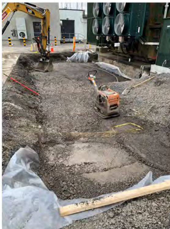
Photographie 8 Remblayage – Excavation 1
