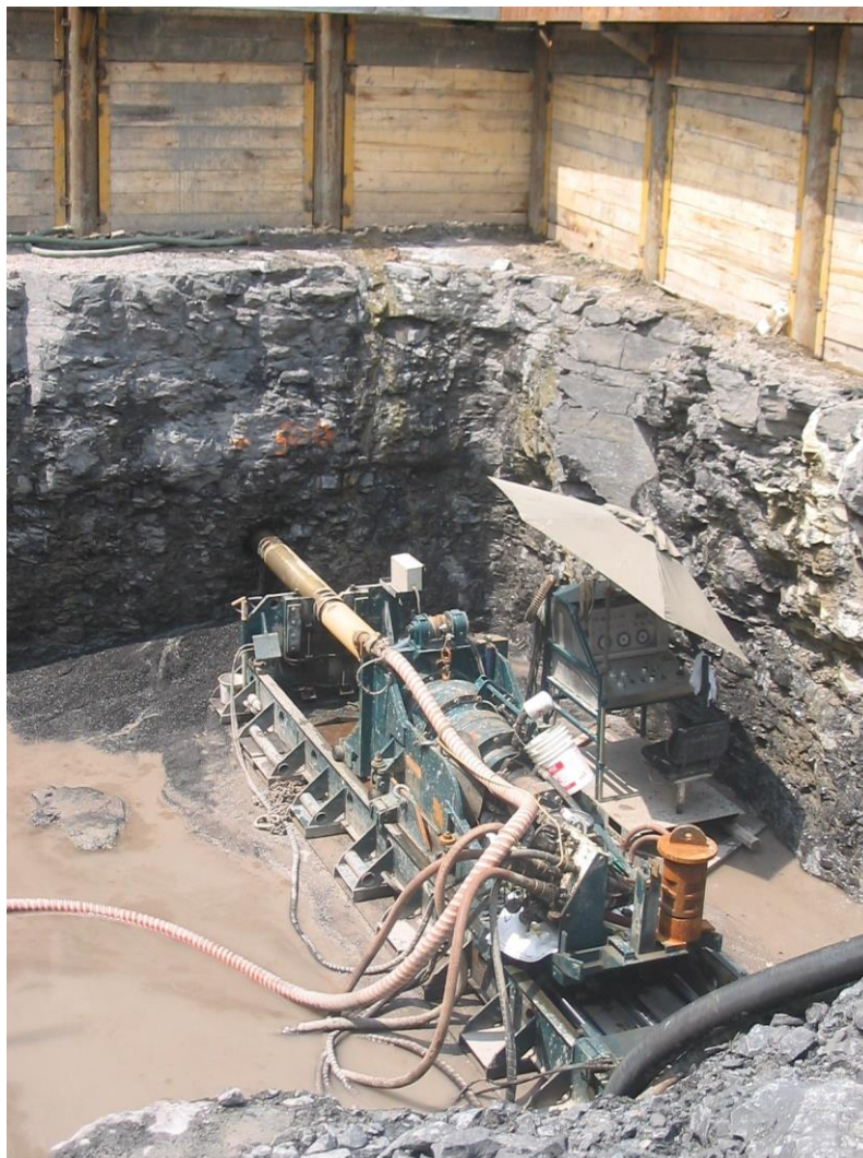
Photo 3-2 : Puits de départ d'un forage poussé
