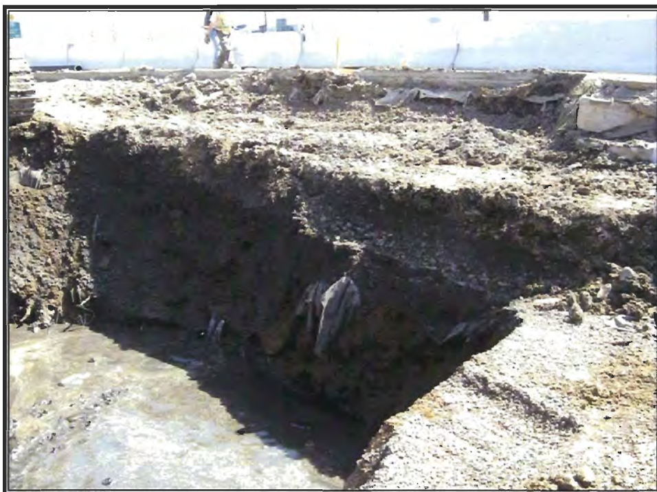
Photo 9 : Paroi sud de l'excavation EXC-05 – Présence de la membrane imperméable installée par Inspec-Sol en 1998 lors de travaux réalisés sur la travée sud de l'avenue Souigny.
