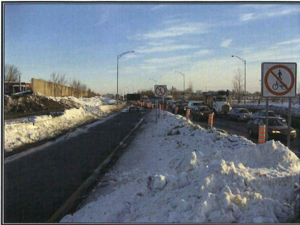
Photo 1 : Site à l'étude – Vue vers l'est.
