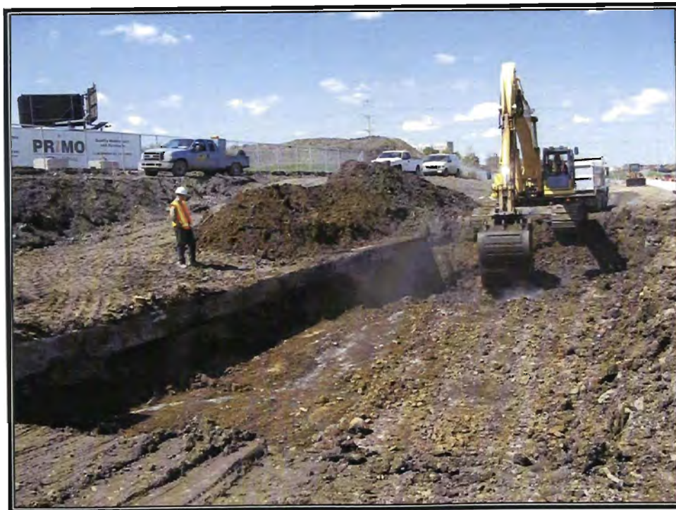
Photo 8 : Excavation des sols du secteur de l'ancien site d'enfouissement EXC-05.
