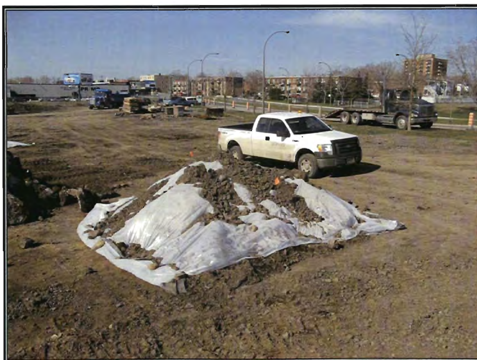
Photo 12 : Mise en pile des sols contaminés et recouvrement de la pile à l'aide d'une membrane imperméable.
