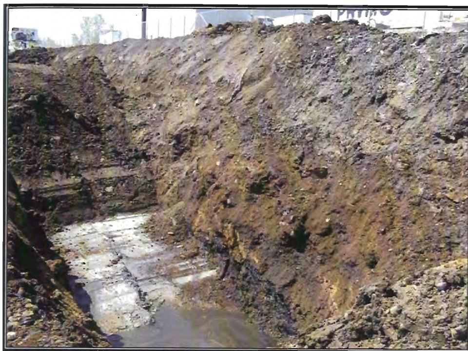
Photo 5 : Surexcavation des sols du secteur EXC-02 de l'ancien site d'enfouissement.
