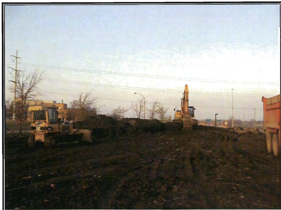
Photo 16 : Chargement des sols de la PILE-20 située sur le terrain du MTQ.
