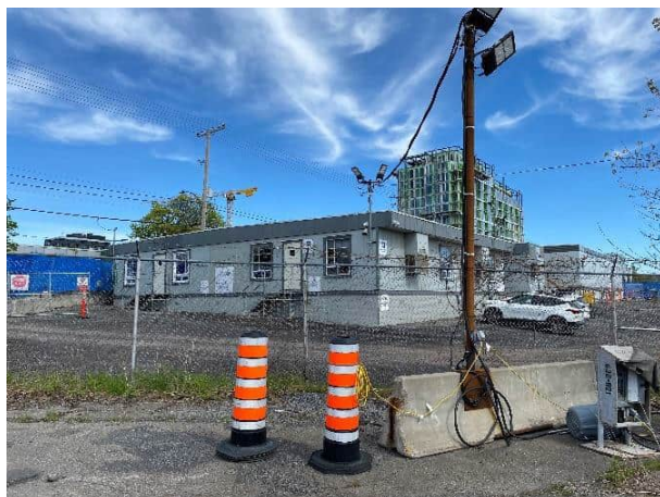
PHOTO 9 Vue de la portion nord du lot 6 573 741
