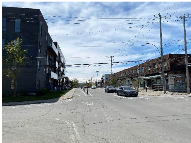
PHOTO 17 Vue de la rue de Marseille vers le sud au niveau de l'intersection avec l'avenue Parkville
