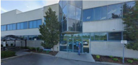
Le bâtiment au 7295 rue Tellier totalise donc un pointage de 45/100, en raison de sa distance au forage prévu (52 m entre le mur le plus proche du bâtiment et l'emplacement du forage), de son âge (34 ans), de sa sensibilité jugée moyenne (fondations et sols en béton, murs en béton ou maçonnerie) et de son état général évalué à bon.
