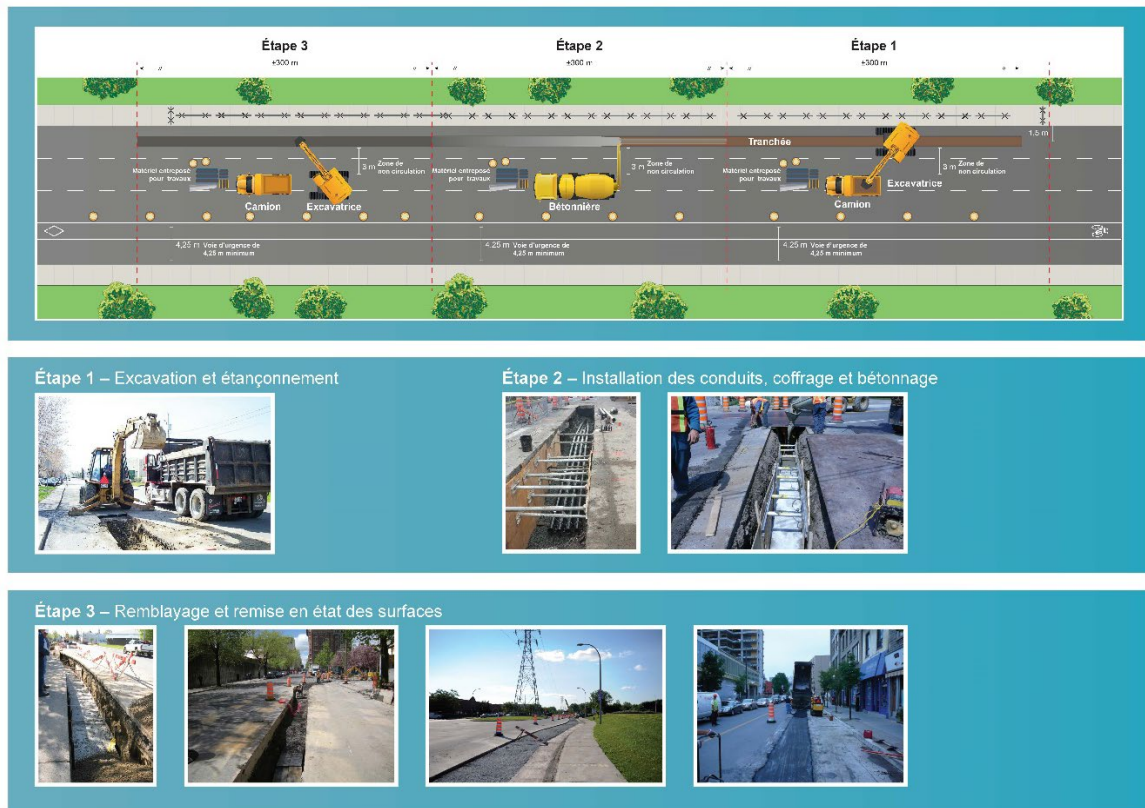
Figure 2-3 : Étapes de la construction d'une canalisation souterraine
