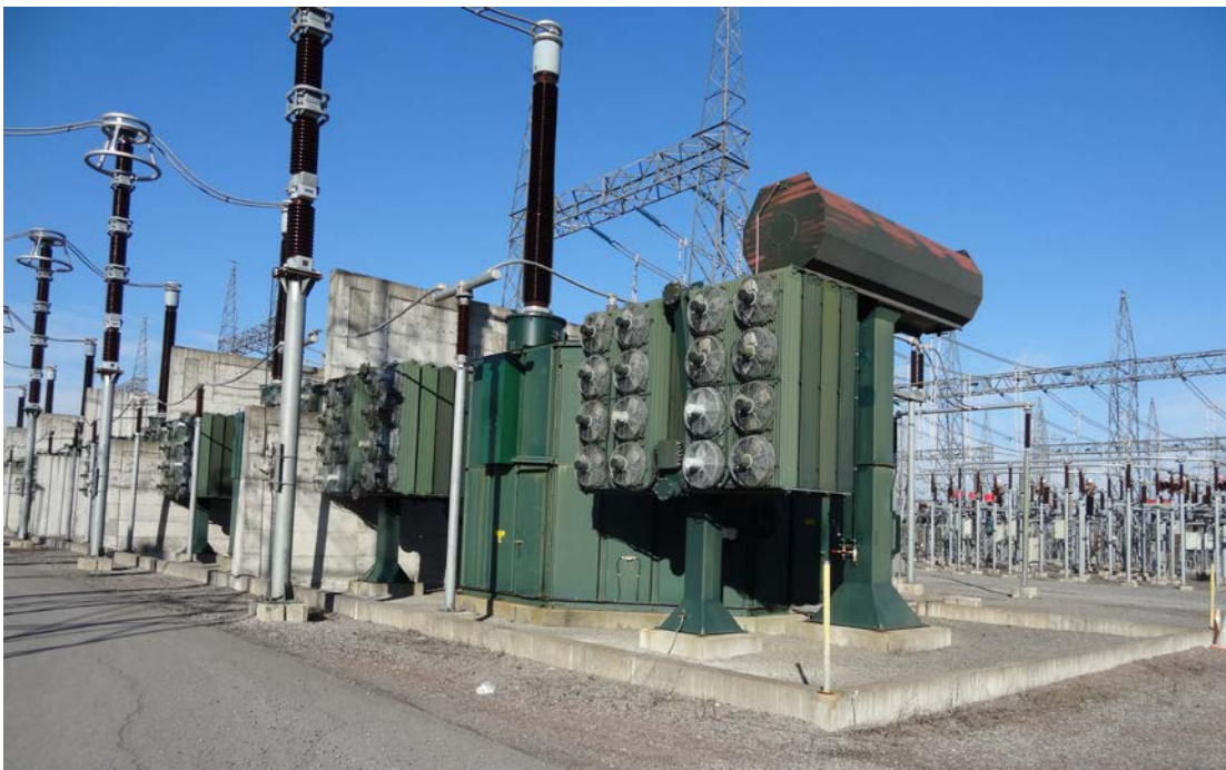
Photo 10-4 : Transformateur de puissance au poste du Saguenay
