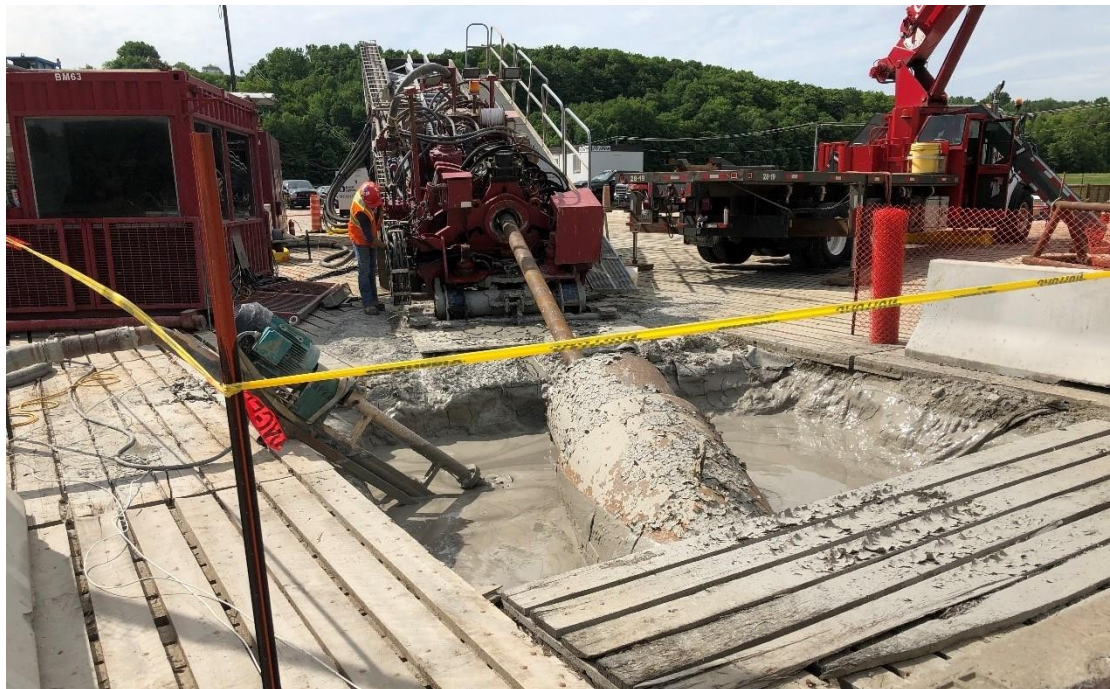
Photo 7-5 : Exemple de foreuse en cours d'utilisation pour des travaux de forage dirigé
