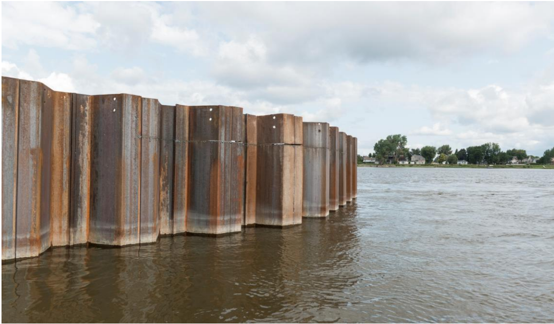
Photo 7-4 : Exemple de batardeau en palplanches
