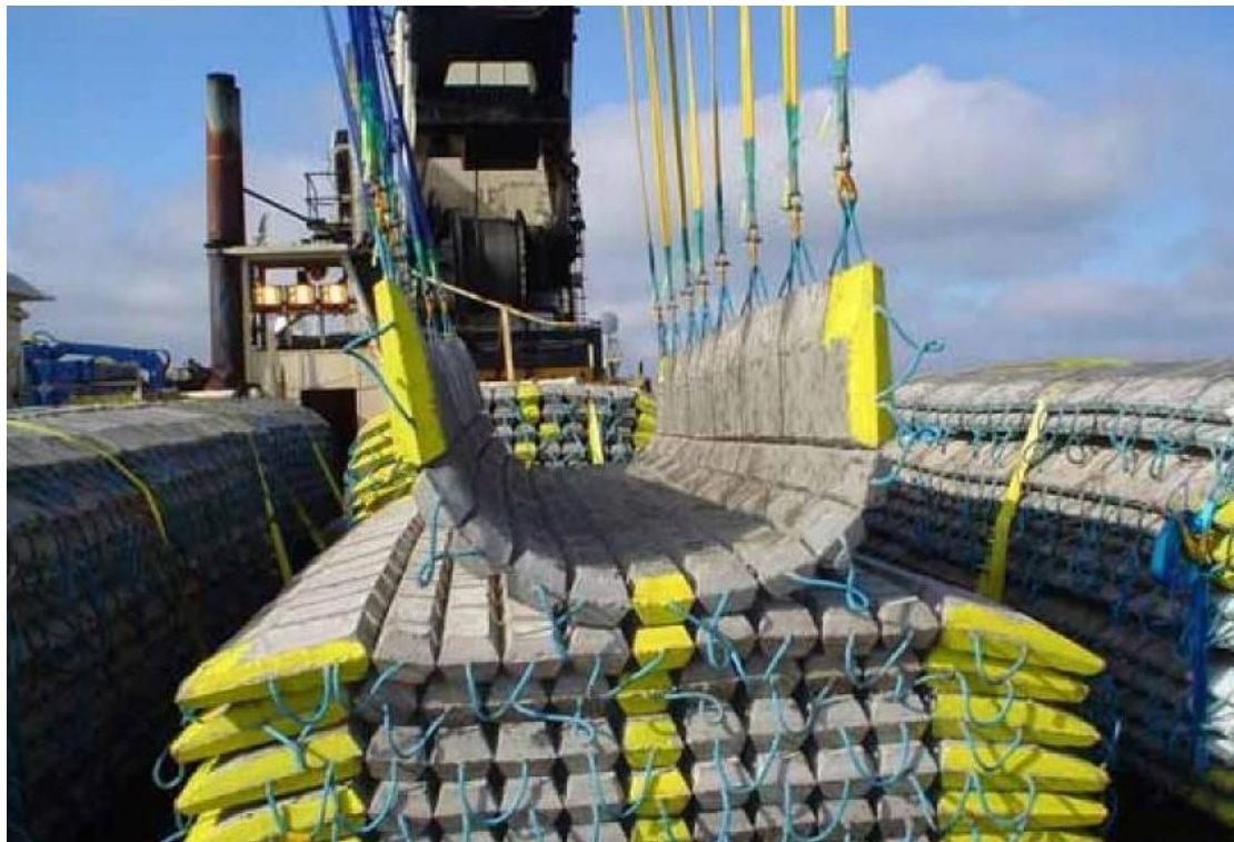
Photo 7-6 : Matelas de béton utilisé dans la portion américaine du projet
