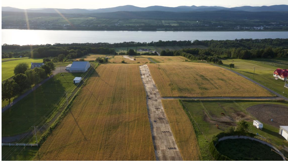
Photo 7-1 : Exemple de voie d'accès sur matelas de bois en terre agricole
