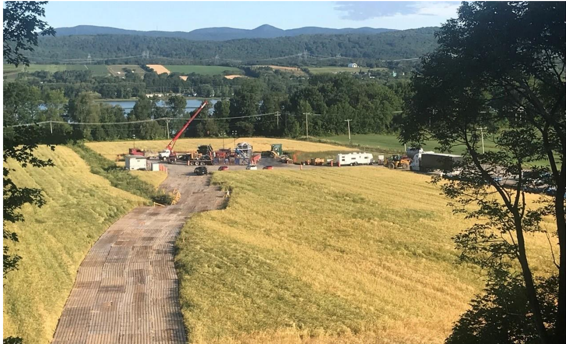
Photo 7-3 : Exemple de travaux de forage en terre agricole réalisés sur des matelas de bois
