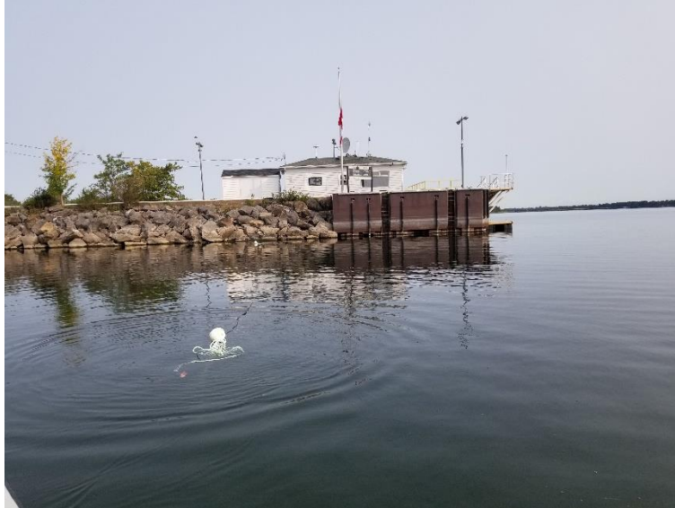
Photo 16 : Enrochement à l'emplacement des douanes canadiennes; HH1-1
