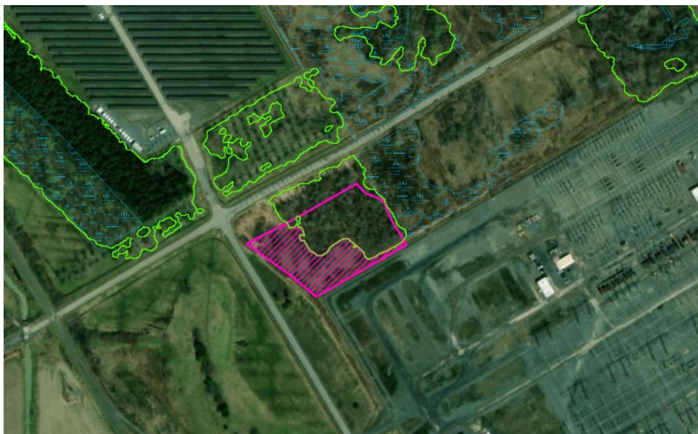
Figure 1 : Déboisement au poste Hertel.
