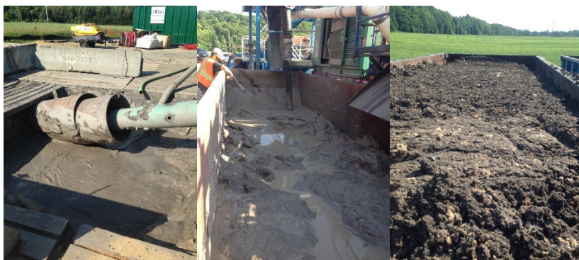
Figure QC-39: Gestion des boues de forage - Projet de l'Île d'Orléans (2019)
