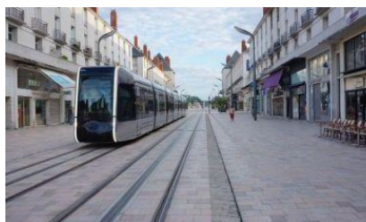
Tours, source : SYSTRA
