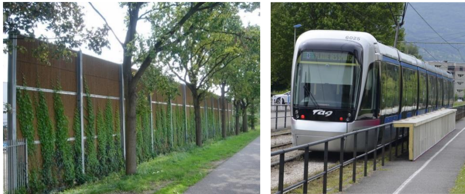
Figure 123 : Exemples d'écrans antibruit
