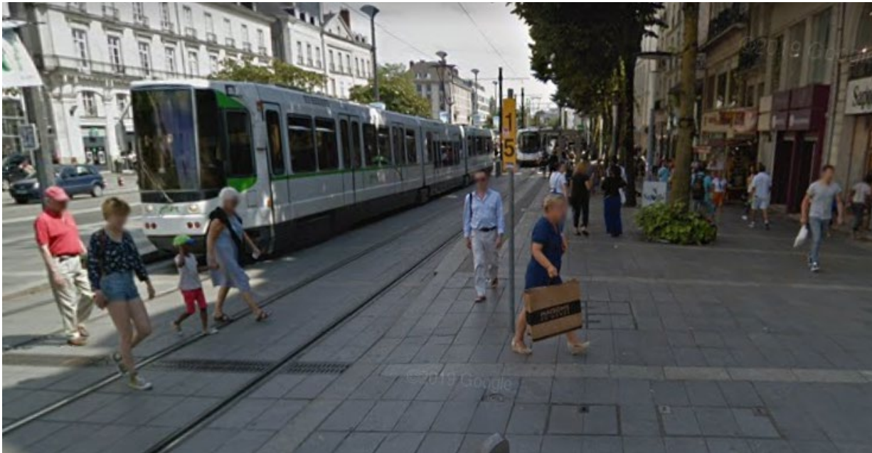
Photo 13 : Nantes (France) – Tramway dans une rue commerciale
