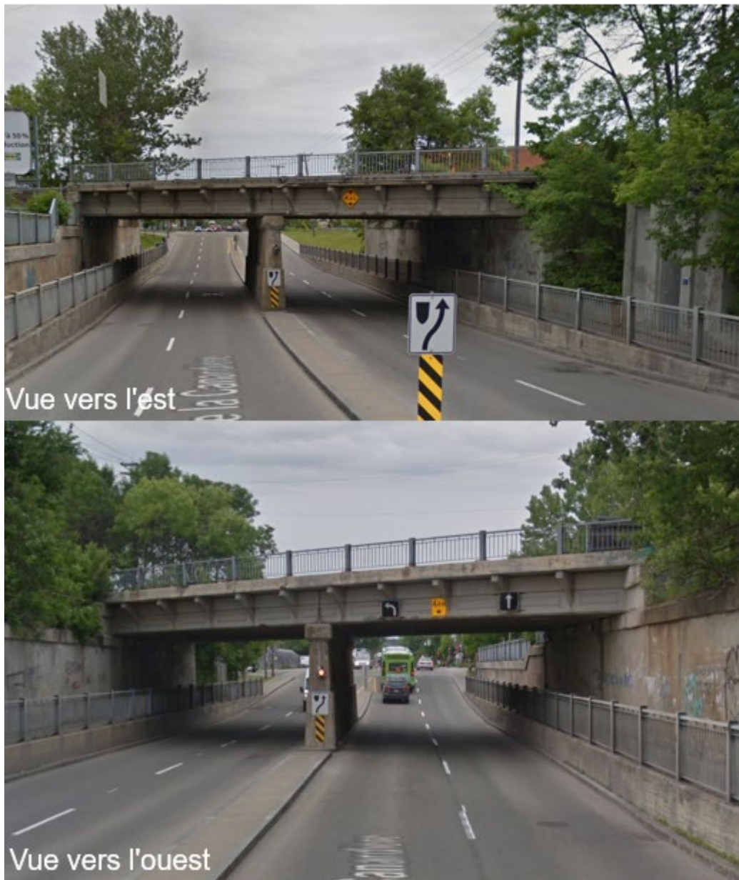
Photo 30 : Chemin de la Canardière à l'intersection du pont d'étagement du CN
