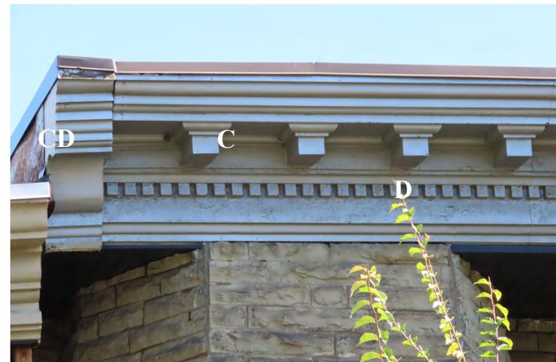
Corniche moulurée, en métal comprenant consoles d'arrêt (CD), modillons et denticules (D) sur la frise du 586-588, chemin de la Canardière.
