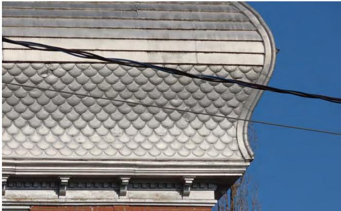
Détail du toit à bulbe et de son parement de tôle en plaques et de tôle en écailles de poissons.
