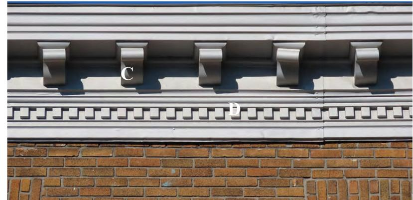
Corniche moulurée à consoles (C) et à denticules (D), en métal, au 589-599, chemin de la Canardière.
