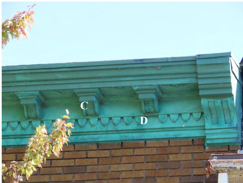
Corniche moulurée à consoles (C) et à denticules (D) ayant la particularité d'être en bois. 750-752, chemin de la Canardière.
