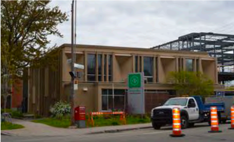
Le 1650, chemin de la Canardière vers 2020. Photo : Patri-Arch., Pré-inventaire du patrimoine moderne, Ville de Québec, 2020.
