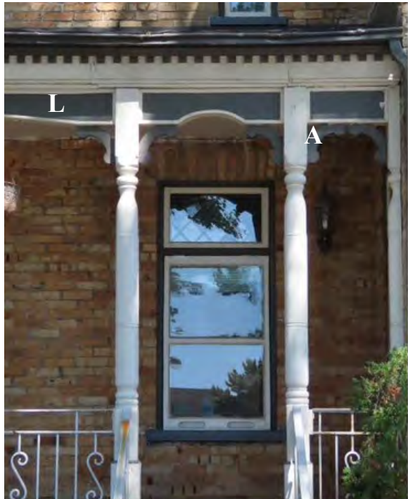
Colonnes tournées dotées d'aisseliers (A) et lambrequins (L). 1720, chemin de la Canardière.
