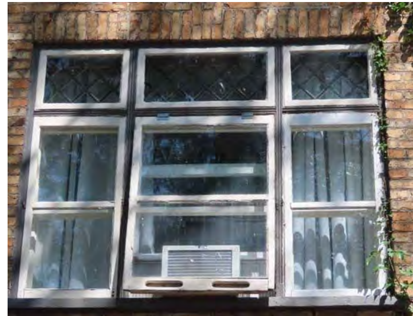
Fenêtre à imposte rectangulaire et à baies latérales au 1720, chemin de la Canardière.
