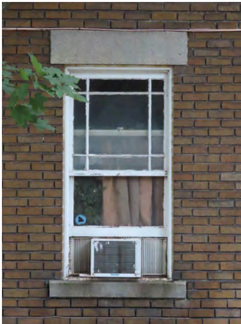
Fenêtre à guillotine à petits-bois, ces fins meneaux ornant la partie supérieure de la fenêtre. 594-596, 4 e Avenue.
