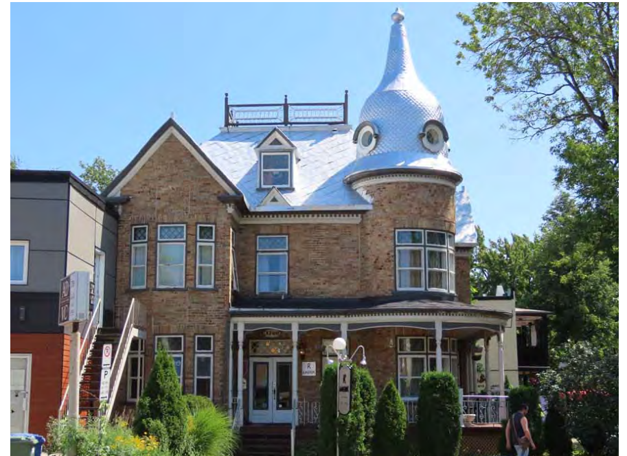
Le 1720, chemin de la Canardière. L'ère victorienne introduit des édifices aux saillies nombreuses, au plan au sol complexe et irrégulier, et offrant des compositions asymétriques. La tour, désaxée, au couronnement conique devient le parfait attribut de ce genre d'édifices. La monumentalité typique des édifices éclectiques s'exprime aussi par des détails d'architecture, comme la terrasse faîtière et son garde-corps au sommet du toit à quatre versants.
