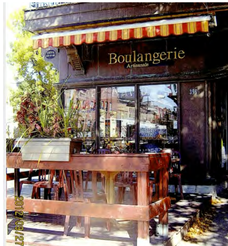
Détail de la façade du 392-396, 3 e Avenue, le 27 septembre 2012. Photo : Répertoire des permis de construction de la Ville de Québec.
