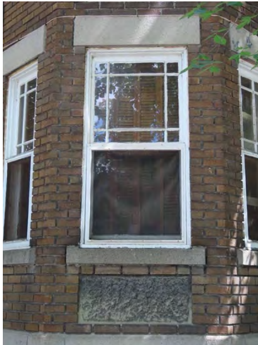
Logette polygonale au 594-596, 4 e Avenue, avec fenêtres à guillotine à petits-bois.
