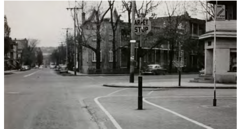
Intersection de la 4 e Avenue, de la 8 e Rue et du chemin de la Canardière en 1954. Le 392-394, chemin de la Canardière en arrière-plan, au centre. Archives de la Ville de Québec. En ligne.
