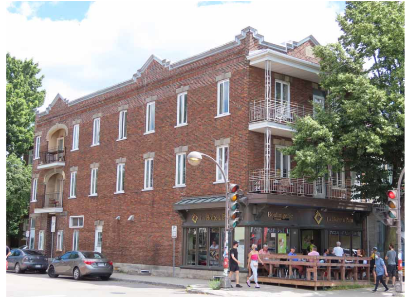
Exemple de bâtiment à valeur patrimoniale «supérieure», l'édifice Létourneau, 392-396, 3 e Avenue
