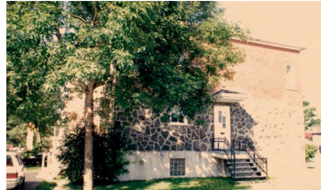
Le 1875-1885, avenue Mailloux en 1984. Photo : Répertoire des permis de construction de la Ville de Québec.
