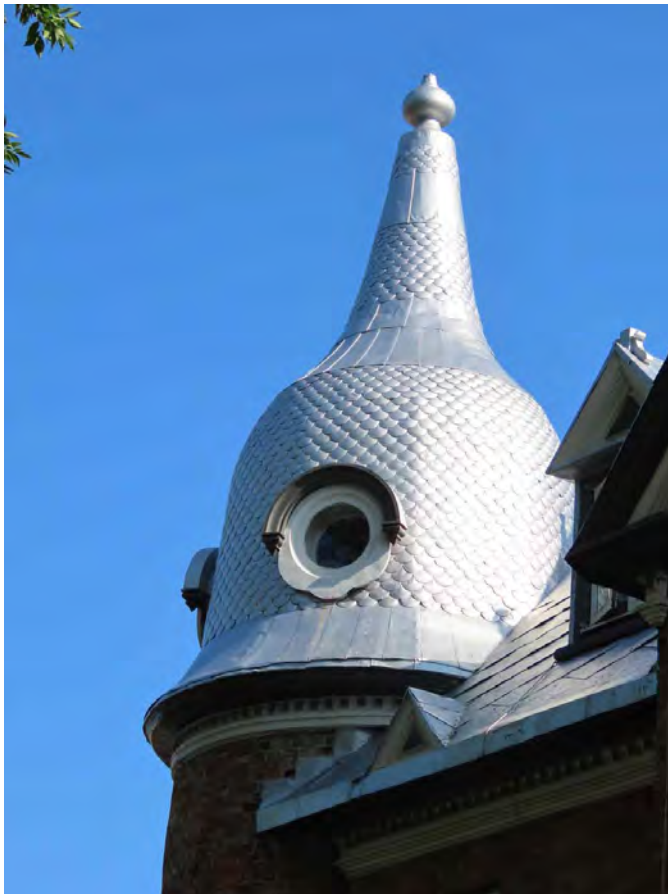
Toit à l'impérial de la tour d'angle du 1720, chemin de la Canardière, recouverte de tôles en forme d'écailles de poissons.
