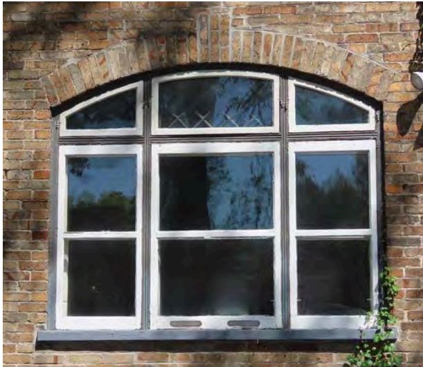
Fenêtre à imposte en arc surbaissé et à baies latérales au 1720, chemin de la Canardière.
