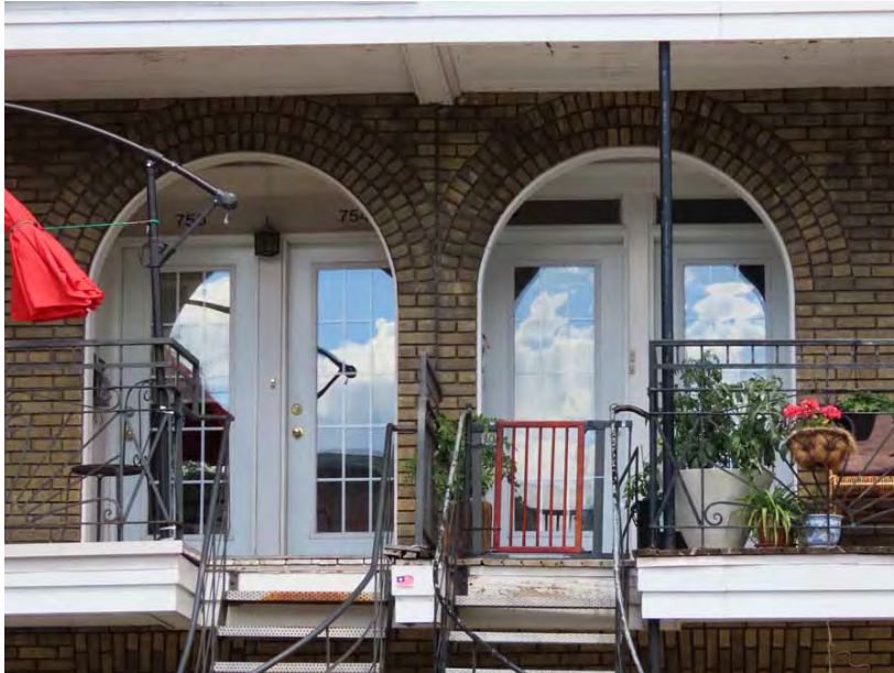
Arcs plein cintre et leur linteau de même forme, surmontant les portes donnant accès aux étages du 748-758, 4 e Avenue.
