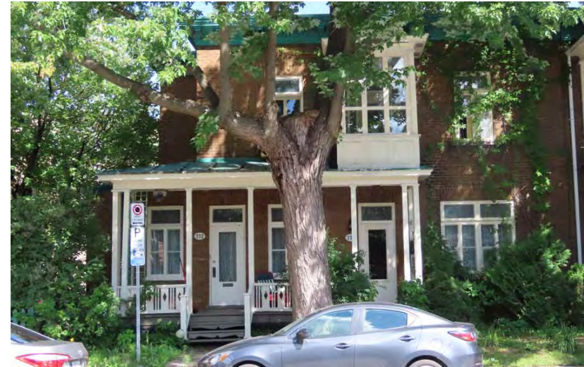
Galerie entièrement composée de bois au 770-772, chemin de la Canardière.
