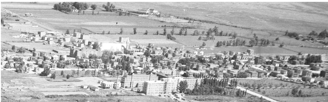
Figure 65 W.B. Edwards, photographie aérienne, 1948 (AVQ N023733)
