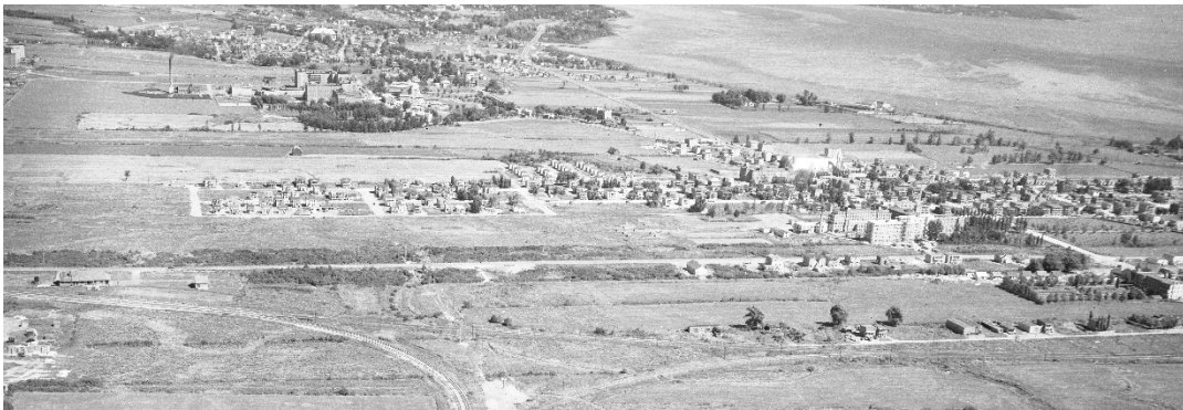
Figure 64 W.B. Edwards, photographie aérienne, 1948 (AVQ N023733)
