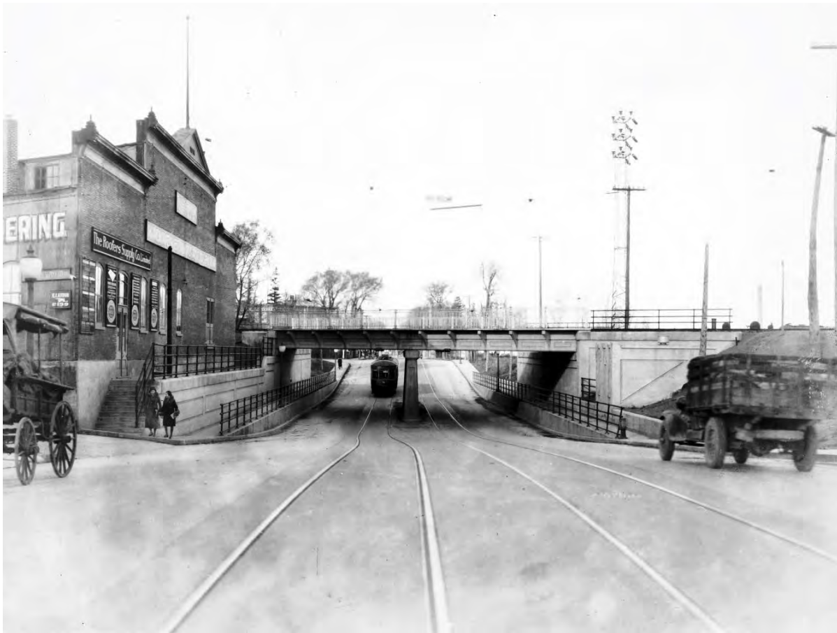
Figure 57 Entrepôt et viaduc du chemin de la Canardière desservi par le tramway, vers 1940 (ASSSCM)
